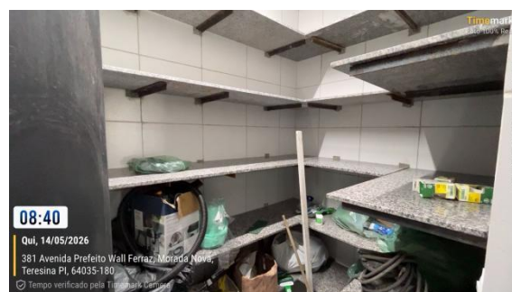
Figura 28: Instalação de prateleiras de granito nos depósitos do restaurante.
