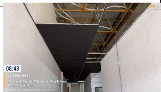
Figura 33: Execução de forro mineral no banheiro.
