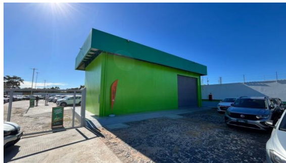
Figura 4: Construção de edificação de lavagem de veículos no pátio externo da Localiza;
