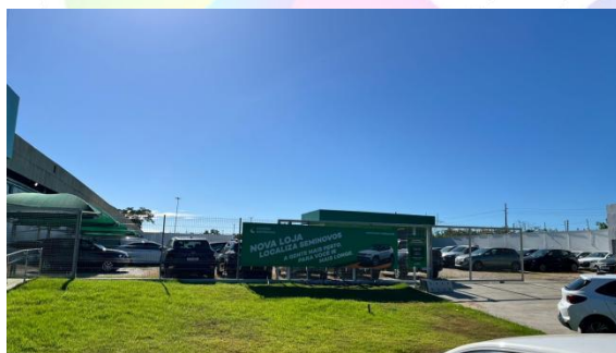
Figura 1: Instalação de gradil metálico e tendas no estacionamento da loja Localiza;
