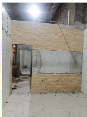
Figura 30: Instalação de revestimentos de pisos e paredes.
