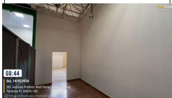
Figura 32: Execução de pintura de paredes do banheiro.
