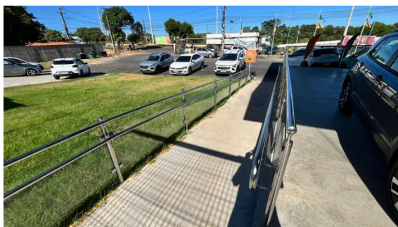
Figura 11: Execução de rampa de acesso com corrimãos
