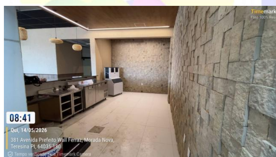
Figura 24: Execução de revestimentos cerâmicos de paredes e pisos internos.
