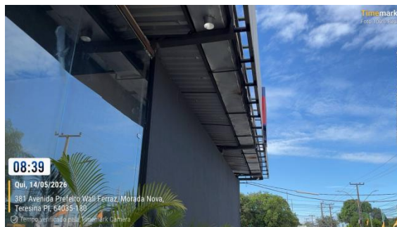
Figura 21: Execução de nova estrutura para complemento de cobertura, calhas e descidas pluviais;
