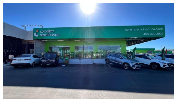
Figura 12: Execução de comunicação visual da fachada da loja
