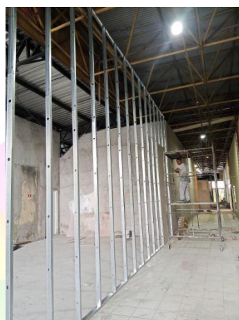
Figura 36: Instalação de divisórias em drywall no acesso aos banheiros
