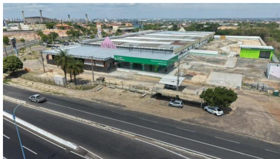
Figura 3: Execução de terraplenagem, demolição de muro e pavimentação interna do pátio da Localiza;
