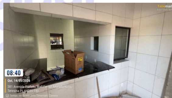
Figura 25: Execução de revestimentos cerâmicos de paredes e pisos internos.
