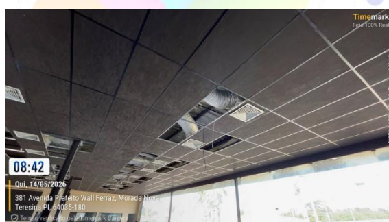
Figura 30: Execução de sistemas de ar-condicionado dutado.
