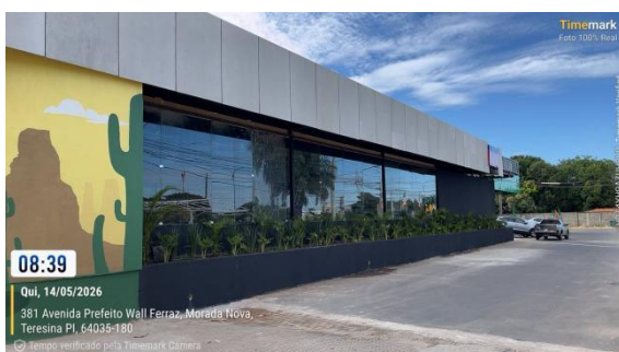
Figura 22: Instalação de esquadrias, paisagismo e pintura da fachada;
