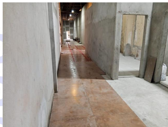
Figura 31: Instalação de revestimentos de pisos e paredes.
