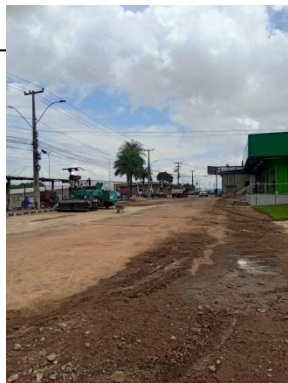
Figura 5: Execução de pavimentação asfáltica na via de acesso à loja.
