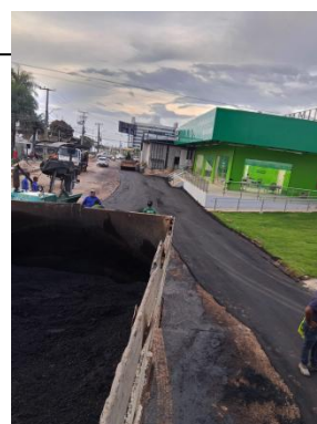
Figura 6: Execução de pavimentação asfáltica na via de acesso à loja.
