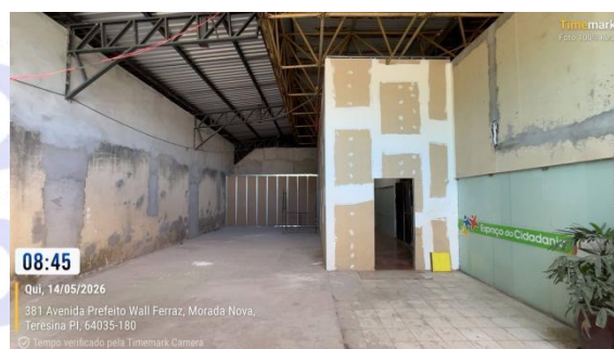
Figura 37: Instalação de divisórias em drywall no acesso aos banheiros
