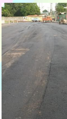
Figura 7: Execução de pavimentação asfáltica na via de acesso à loja.
