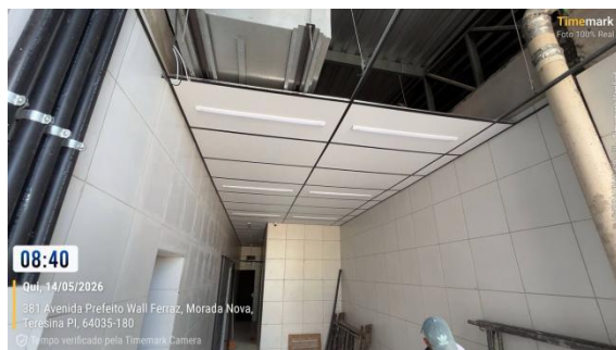
Figura 26: Execução de forro mineral nos ambientes internos do restaurante;
