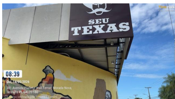
Figura 20: Execução de nova estrutura para complemento de cobertura, calhas e descidas pluviais;
