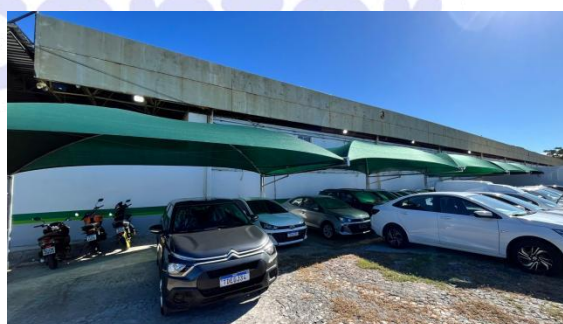
Figura 2: Instalação de gradil metálico e tendas no estacionamento da loja Localiza;
