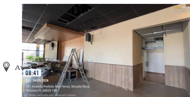
Figura 32: Execução de pintura interna e estrutura do palco.
