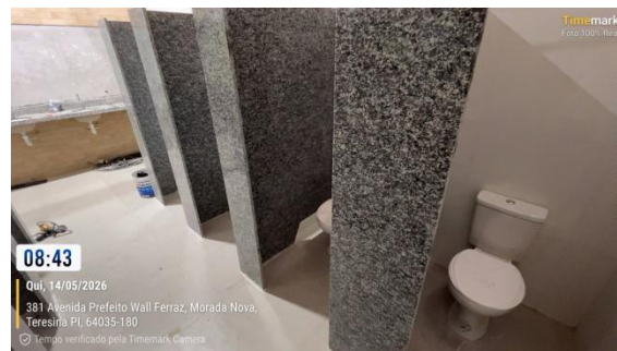
Figura 35: Instalação de divisórias de granito, louças e metais.
