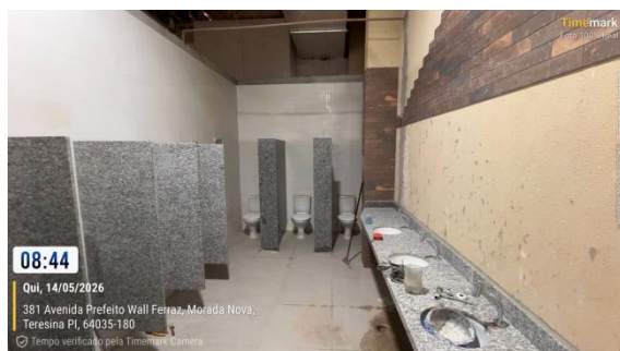
Figura 34: Instalação de divisórias de granito, louças e metais.
