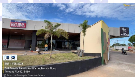
Figura 19: Pintura de paredes externas do restaurante.
