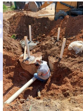
Figura 8: Execução de fossa séptica para as instalações da loja.
