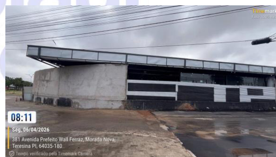
Fachada do restaurante com nova platibanda e cobertura
