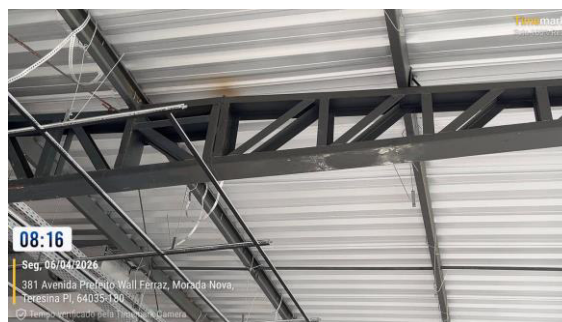
Nova calha, estrutura metálica da cobertura e instalações
