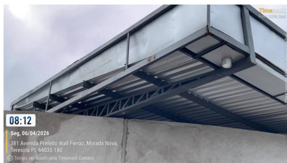
Nova calha, estrutura metálica da cobertura e platibanda
