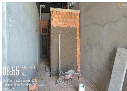
Figura 21: Aplicação de reboco sobre as parede de diversos ambientes.
