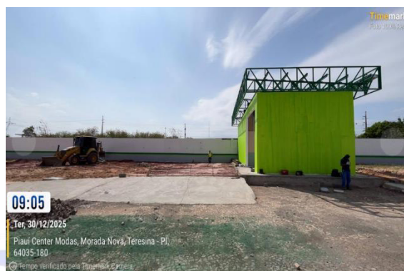
Figura 10: Execução estrutura de cobertura com treliças metálicas.
