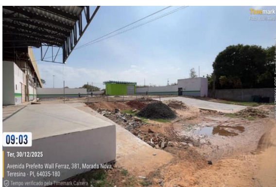
Figura 9: Remoção de parede externa e instalação de gradil no local.
