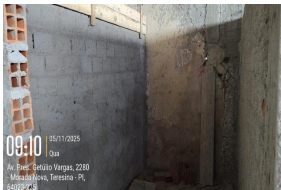
Figura 31: Assentamento com alvenaria e reboco das paredes
