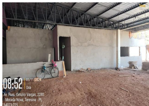
Figura 19: Aplicação de reboco sobre as parede de diversos ambientes.
