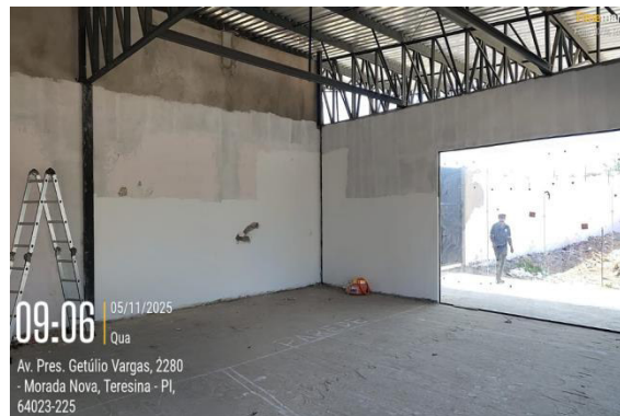
Figura 2: Aplicação de massa corrida sobre as paredes.
