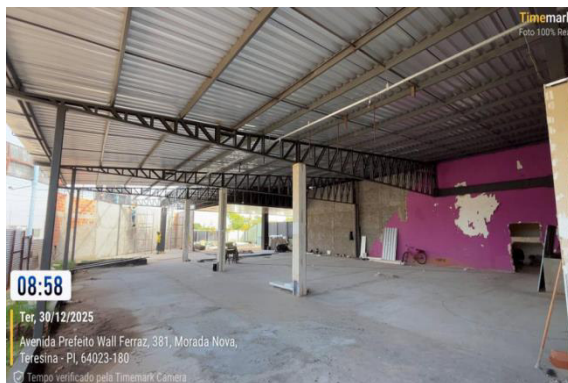
Figura 26: Execução de contrapiso no interior do restaurante.
