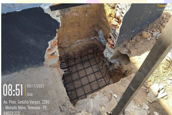
Figura 16: Inserção de “aranha” nos blocos de fundação.
