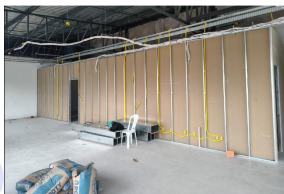
Figura 4: Instalação de paredes de drywall e pintura das mesmas com tons em verde.
