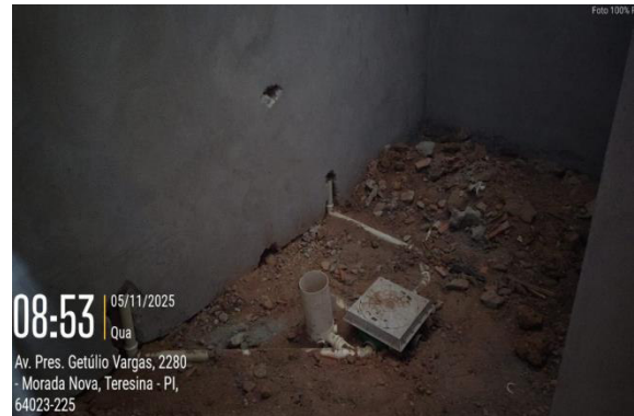
Figura 25: Instalação de tubulação hidrossanitária (esgoto) em diversos banheiros.
