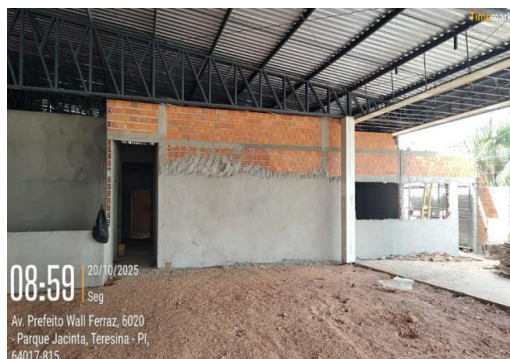
Figura 18: Aplicação de reboco sobre as parede de diversos ambientes.
