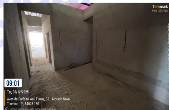
Figura 29: Aplicação de reboco sobre parede de corredor e diversos ambientes.
