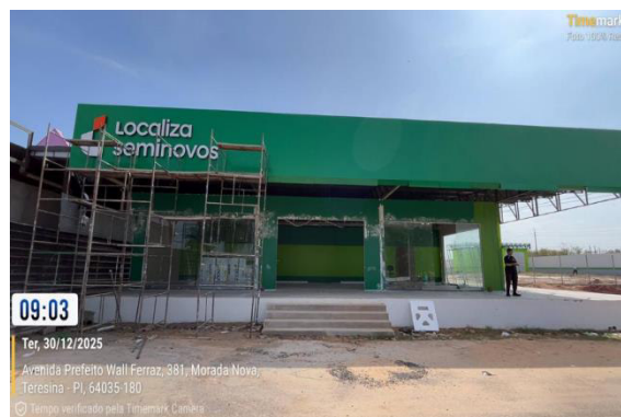
Figura 8: Execução de platibanda com a logo da Localiza.
