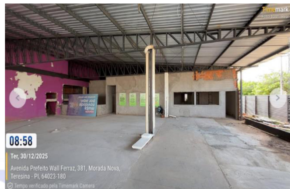
Figura 27: Execução de contrapiso no interior do restaurante.
