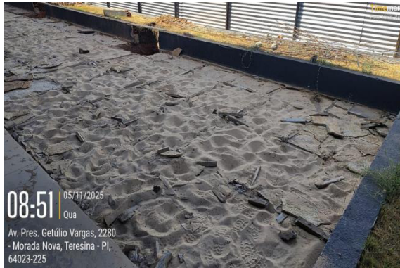
Figura 24: Demolição de piso antigo na área externa.
