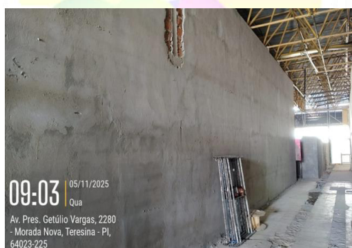
Figura 22: Aplicação de reboco sobre as parede de diversos ambientes.
