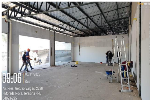
Figura 1: Aplicação de reboco sobre os eletrodutos.
