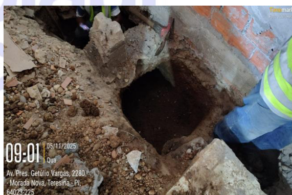
Figura 17: Escavação para passagem de tubulações e caixas de passagem.
