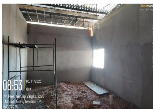
Figura 20: Aplicação de reboco sobre as parede de diversos ambientes.
