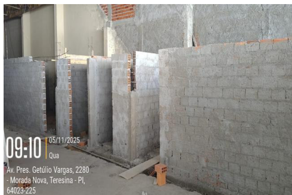
Figura 30: Assentamento com alvenaria e reboco das paredes
