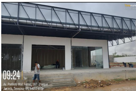
Figura 7: Execução de platibanda com a logo da Localiza.
