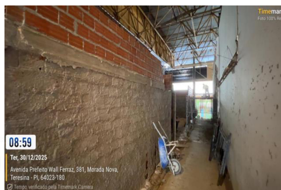
Figura 32: Assentamento com alvenaria e reboco das paredes
