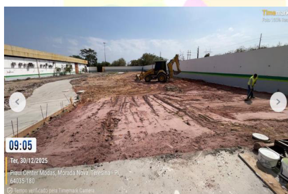
Figura 11: Aterro e nivelamento de pátio para veículos.
