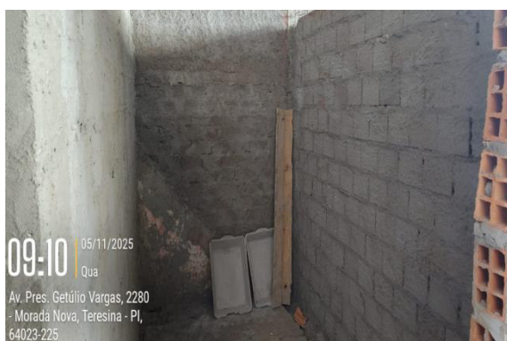
Figura 31: Assentamento com alvenaria e reboco das paredes
