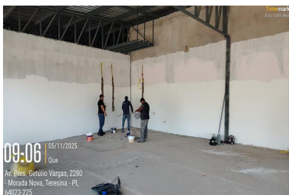
Figura 3: Aplicação de massa corrida sobre as paredes.
