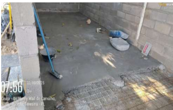
Figura 9: Concretagem de contrapiso na construção em frente ao viveiro.
