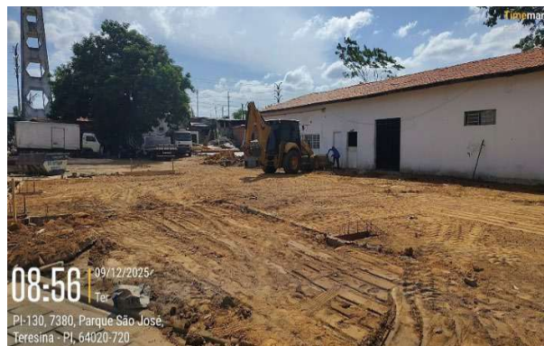
Figura 91: Aterro e nivelamento de superfície da expansão do almoxarifado
