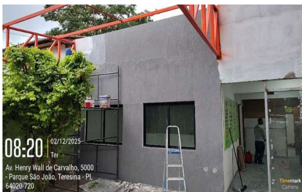
Figura 79: Pintura sobre a parede da fachada no Anexo Administrativo
