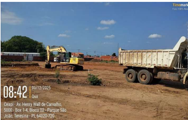
Figura 99: :Terraplanagem de terreno (Corte ,Aterro e Nivelamento)
