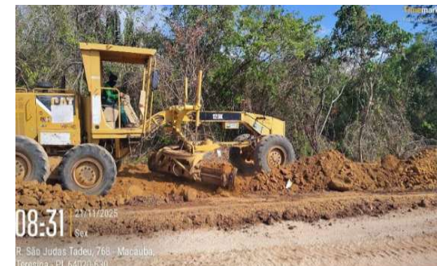
Figura 67: Limpeza, aterro, mistura e nivelamento para execução de via auxiliar da balança rodoviária
