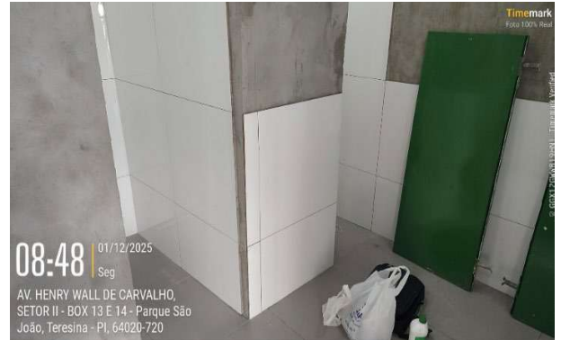
Figura 61: Assentamento de porcelanato sobre contrapiso e parede em banheiro
