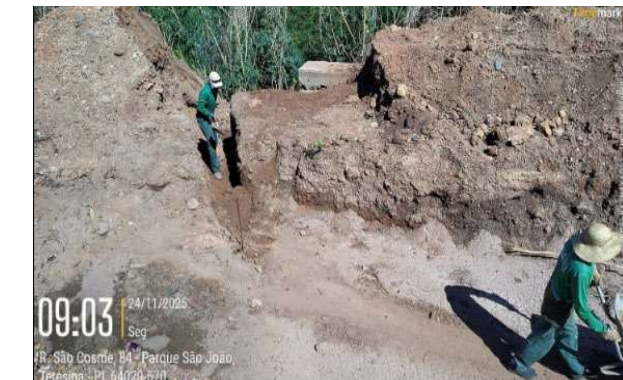
Figura 67: Limpeza, aterro, mistura e nivelamento para execução de via auxiliar da balança rodoviária
