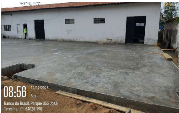
Figura 94: Concretagem e nivelamento de fundação radier para expansão do almoxarifado
