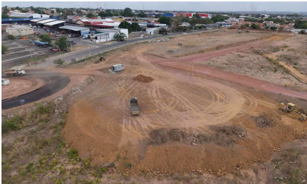
Figura 74: Terraplanagem de terreno (Corte ,Aterro)
