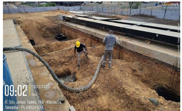
Figura 108: Concretagem da fundação de guarita da balança rodoviária
