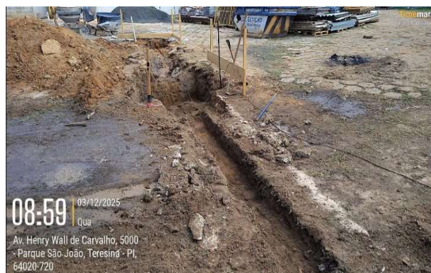
Figura 89: Escavação de vala de fundação para fundação de expansão do almoxarifado
