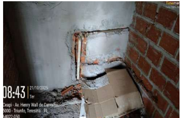
Figura 34: Corte em parede para execução dos pontos de água fria e esgoto
