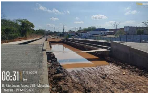
Figura 66: Limpeza, aterro, mistura e nivelamento para execução de via auxiliar da balança rodoviária
