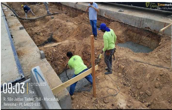
Figura 109: Adensamento vibratório para redução de vazios na concretagem
