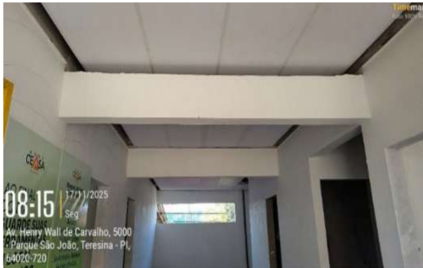
Figura 54: Instalação de forro em diversos ambientes no Anexo Administrativo
