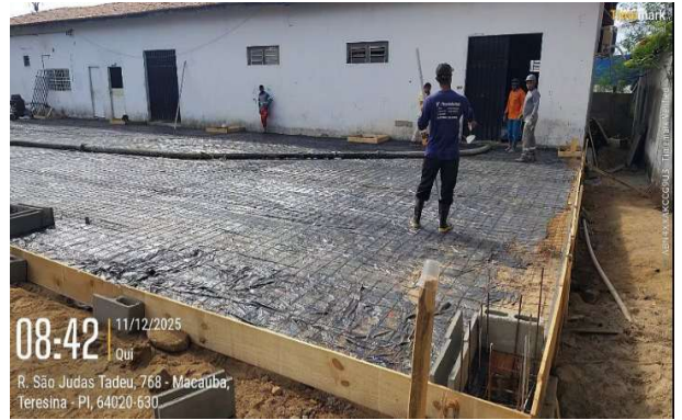
Figura 93: Concretagem e nivelamento de fundação radier para expansão do almoxarifado
