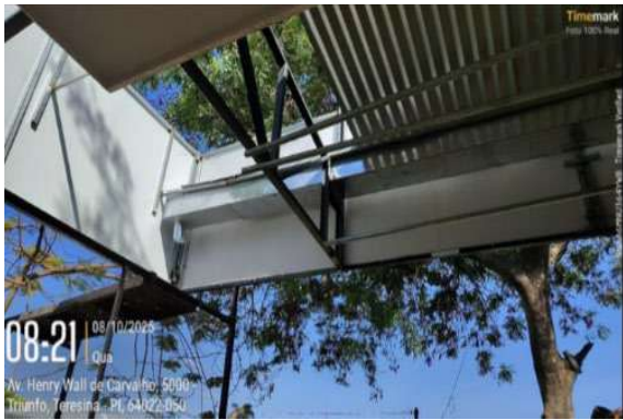
Figura 3: Inserção de tubulação pluvial e calha de zinco em cobertura da fachada norte e oeste
