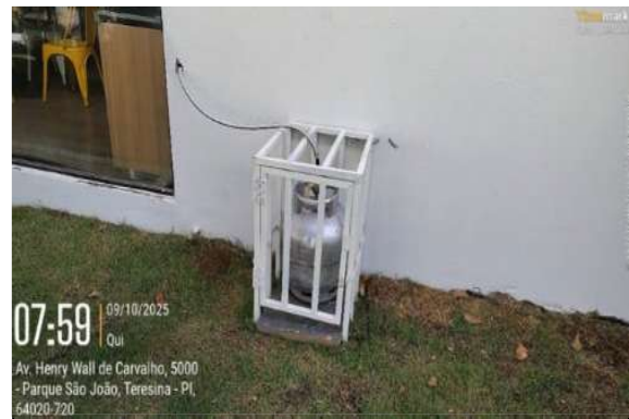
Figura 4: Execução de grade proteção para casa de gás
