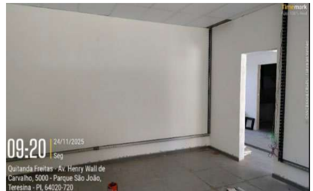
Figura 51: Instalação de eletrocalha, eletroduto rígido e fios elétricos em seu interior
