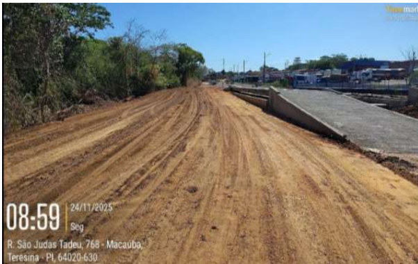
Figura 66: Limpeza, aterro, mistura e nivelamento para execução de via auxiliar da balança rodoviária
