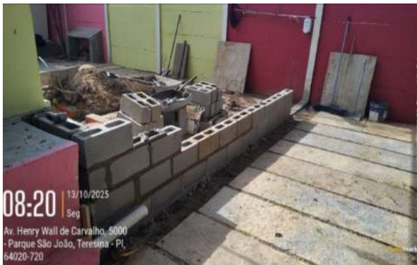
Figura 27: Assentamento de parede com bloco de concreto estrutural na área externa do Anexo Administrativo
