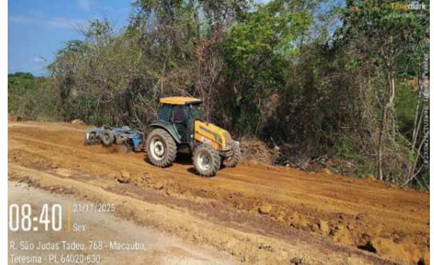
Figura 65: Limpeza, aterro, mistura e nivelamento para execução de via auxiliar da balança rodoviária
