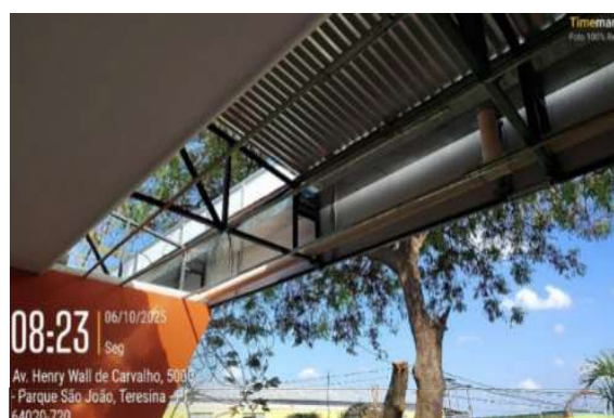
calha de zinco em cobertura da fachada norte e oeste
