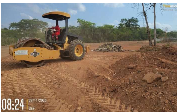
Figura 78: Compactação de solo com o equipamento "pé de carneiro "
