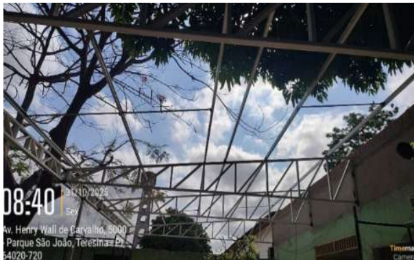
Figura 33: Instalação de treliça e terças metálicas para cobertura na fachada norte do Anexo Administrativo
