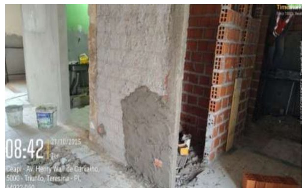
Figura 16: Reboco sobre parede interna em diversos ambientes e platibanda da fachada norte no Anexo Administrativo
