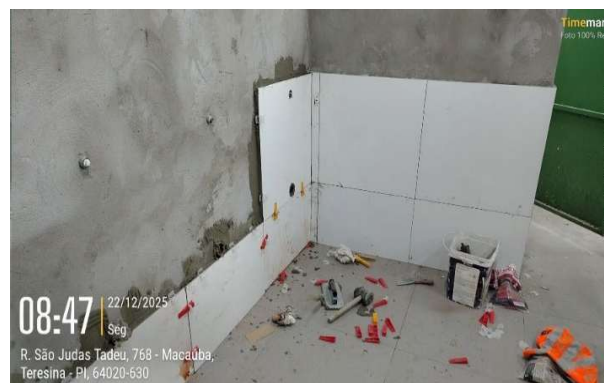
Figura 116: Assentamento de porcelanato sobre piso e parede do banheiro
