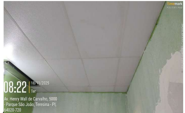
Figura 55: Instalação de forro em diversos ambientes no Anexo Administrativo
