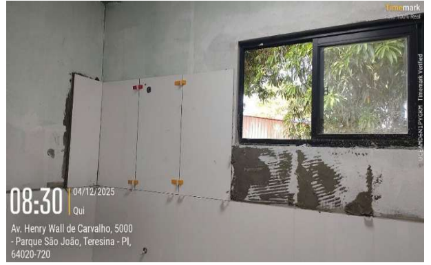
Figura 84: Assentamento de porcelanato sobre as paredes no Anexo Administrativo
