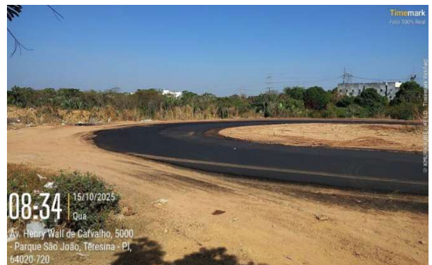
Figura 39: Aplicação de CBUQ como camada asfáltica em rotatória próxima da balança rodoviária
