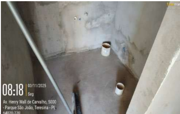
Figura 37: Execução de contrapiso do Anexo Administrativo
