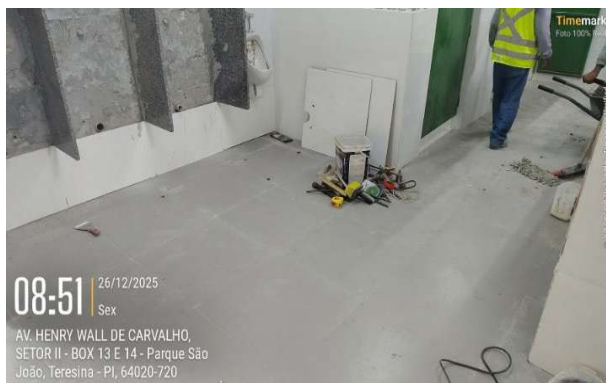
Figura 117: Assentamento de porcelanato sobre piso e parede do banheiro
