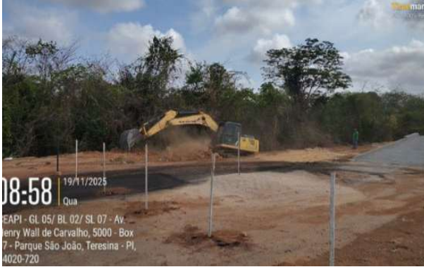
Figura 64: Limpeza, aterro, mistura e nivelamento para execução de via auxiliar da balança rodoviária
