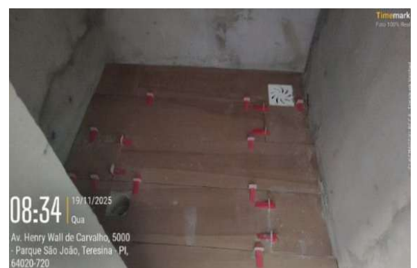
Figura 47: Assentamento de porcelanato em piso, rodapé e parede do Anexo Administrativo
