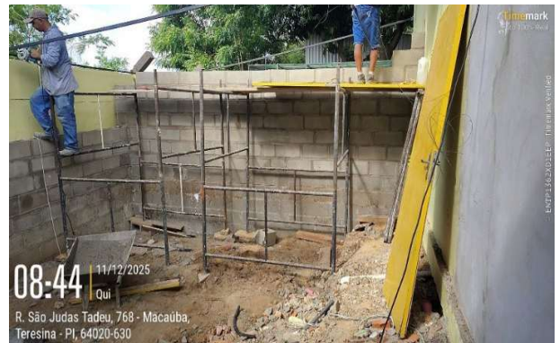
Figura 86: Assentamento de parede com blocos de concreto estrutural na área externa do Anexo Administrativo
