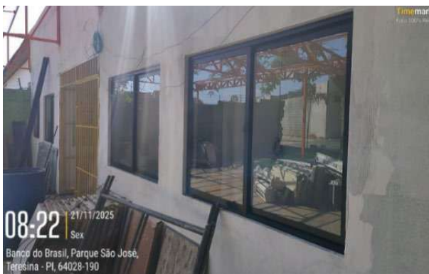
Figura 56: Instalação de esquadria e vidros em portas e janelas
