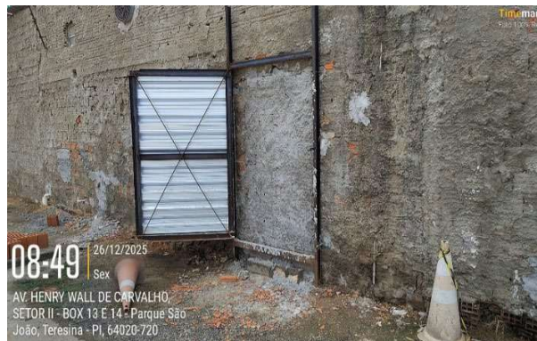
Figura 118 : Vedação de porta provisória com alvenaria no banheiro
