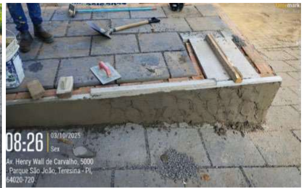
Figura 8: Reboco sobre alvenaria ao lado da via até o almoxarifado
