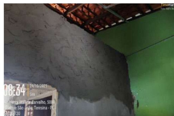
Figura 18: Reboco sobre parede interna em
