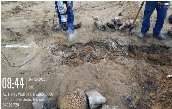
Figura 98: :Quebra de piso sextavado com martelete
