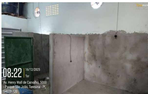
Figura 115: Assentamento e reboco das divisões entre os banheiros
