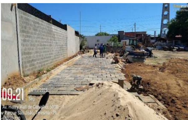
Figura 52: Execução de nova via até o almoxarifado
