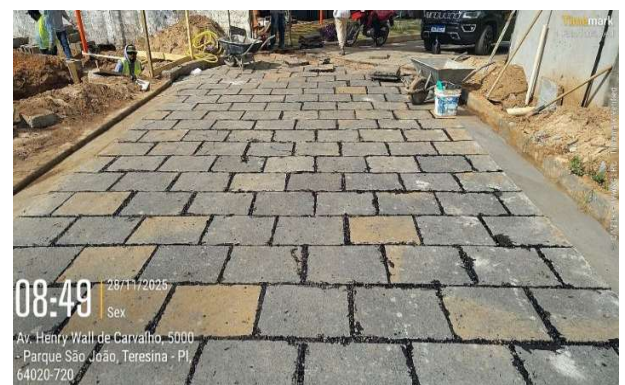
Figura 53: Execução de nova via até o almoxarifado
