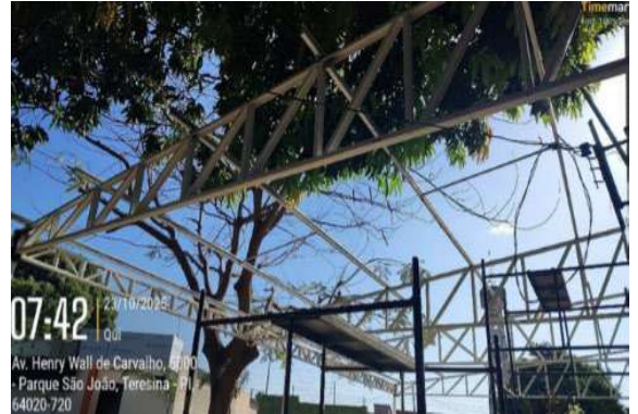
Figura 32: Instalação de treliça e terças metálicas para cobertura na fachada norte do Anexo Administrativo
