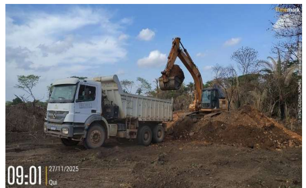
Figura 73: Terraplanagem de terreno (Corte, Aterro)
