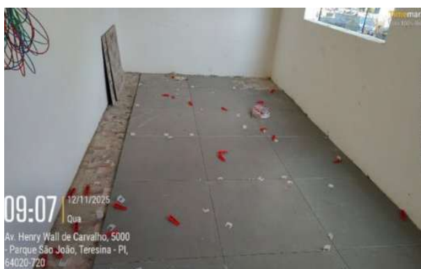
Figura 46: Assentamento de porcelanato em piso, rodapé e parede do Anexo Administrativo
