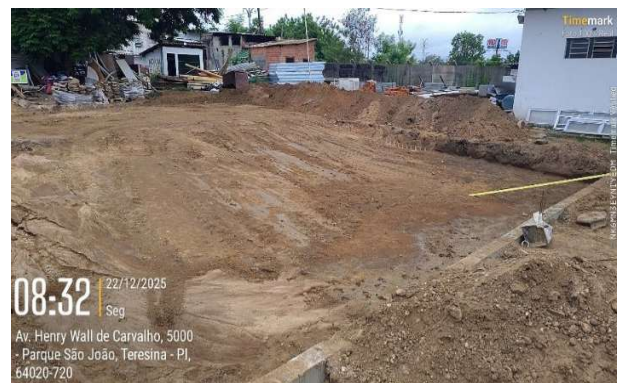
Figura 97: Corte de solo de primeira categoria para execução de docas
