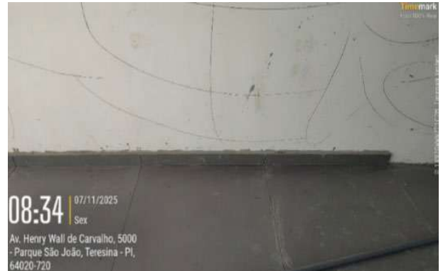
Figura 49: Assentamento de porcelanato em piso, rodapé e parede do Anexo Administrativo
