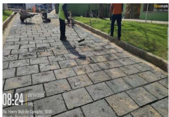
Figura 24: Reparo do pavimento de granito cinza até o alboxarifado
