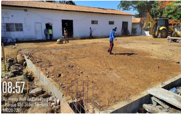
Figura 92: Compactação de terreno aterrado com placa vibratória
