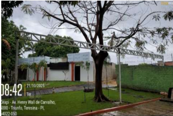
Figura 31: Instalação de treliça e terças metálicas para cobertura na fachada norte do Anexo Administrativo
