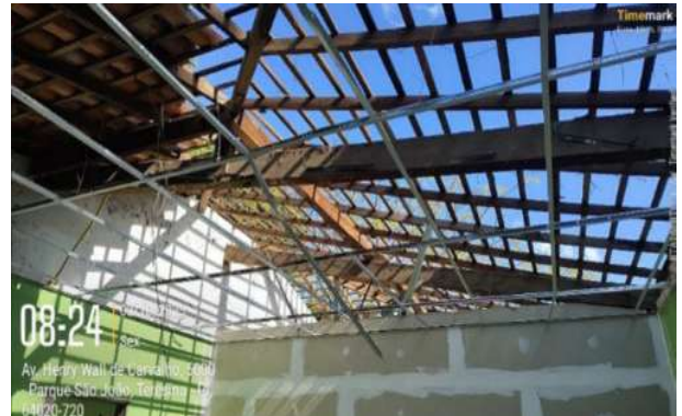
Figura 14: Substituição de telha danificada da estrutura antiga do Anexo Administrativo
