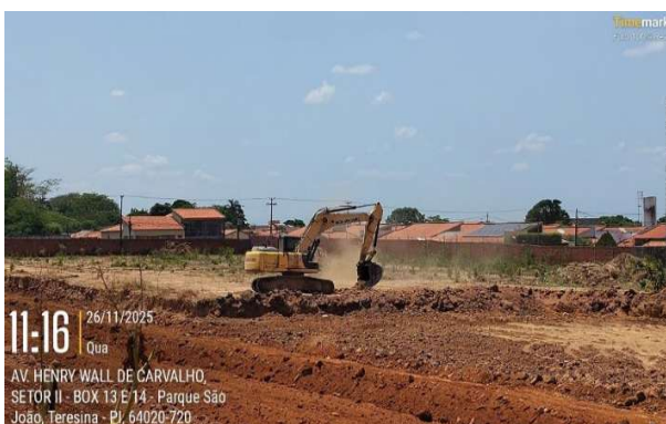
Figura 72: Terraplanagem de terreno (Corte, Aterro)
