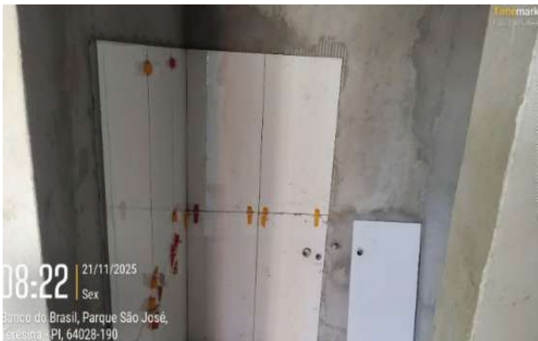
Figura 48: Assentamento de porcelanato em piso, rodapé e parede do Anexo Administrativo
