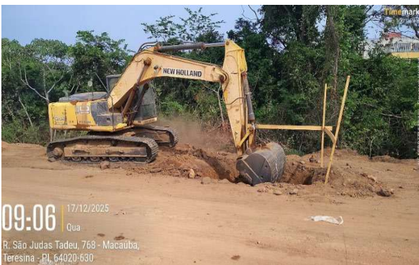
Figura 111: Escavação de vala para fundação com escavadeira hidráulica
