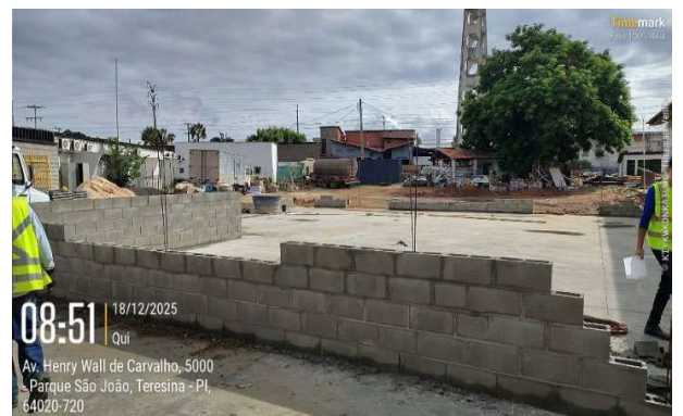
Figura 95: Assentamento de parede com bloco de concreto estrutural
