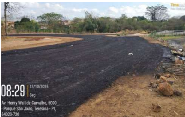
Figura 38: Imprimiçãõ de base em rotatória próxima da balança rodoviária
