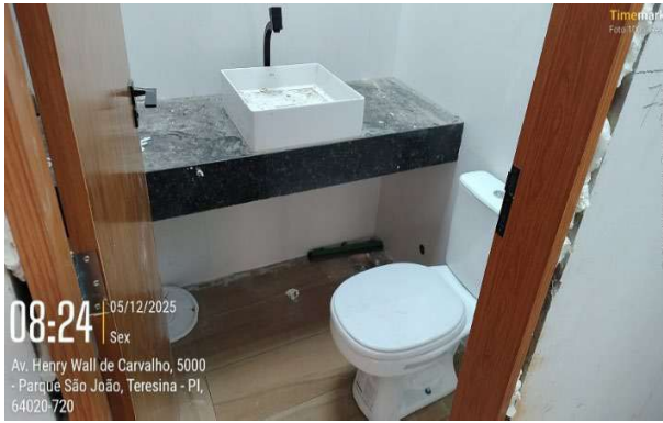
Figura 83: Instalação de bancada com cuba nos banheiros
