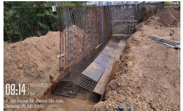
Figura 71: Execução de formas para concretagem de base de muro de arrimo
