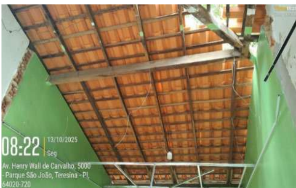
Figura 15: Substituição de telha danificada da estrutura antiga do Anexo Administrativo
