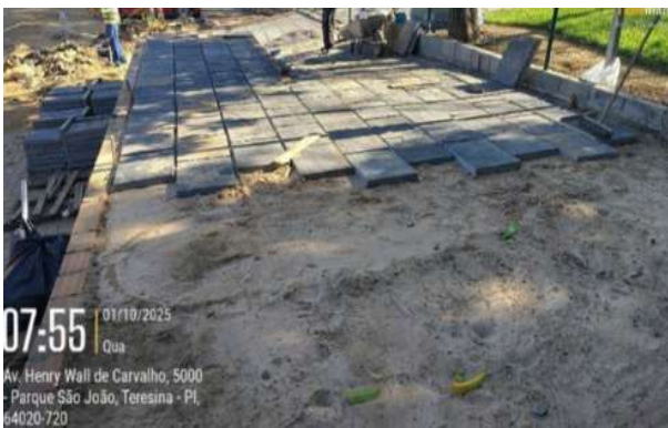
Figura 7: Execução de calçada com pavimento de pedra granito cinza
