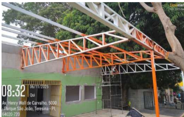
Figura 50: Pintura de estrutura de aço da cobertura com a cor laranja
