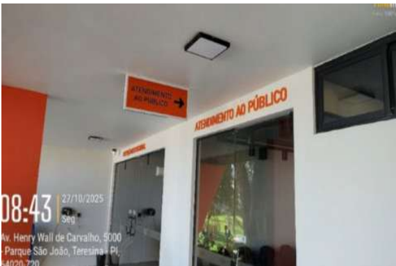
Figura 5: Instalação de letreiros em acrílico na fachada norte
