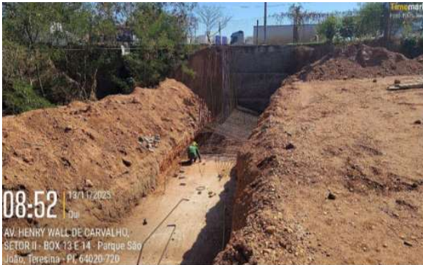
Figura 70: Inserção de armadura em muro de arrimo
