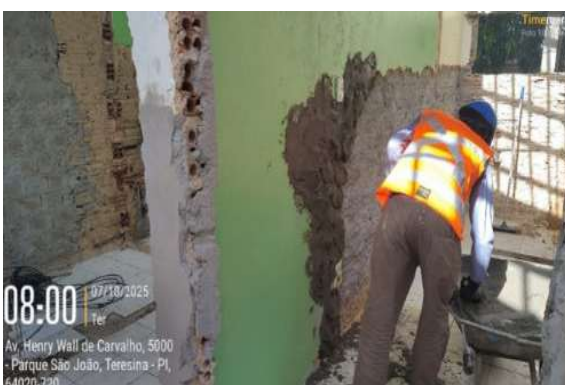
Figura 17: Reboco sobre parede interna em
