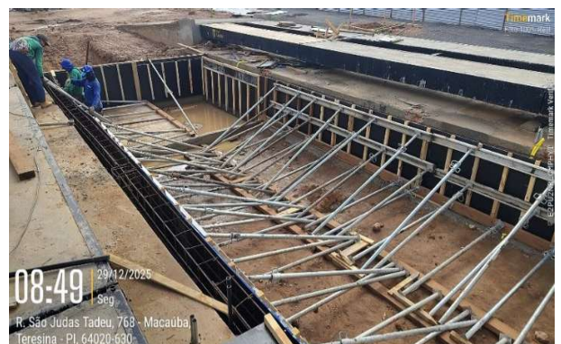
Figura 112: Execução de formas para concretagem de viga-baldrame na lateral da balança rodoviária com escoramento
