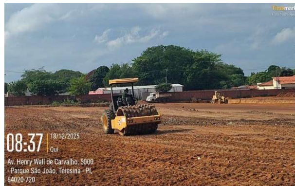
Figura 106: Compactação de terreno com "pé de carneiro"
