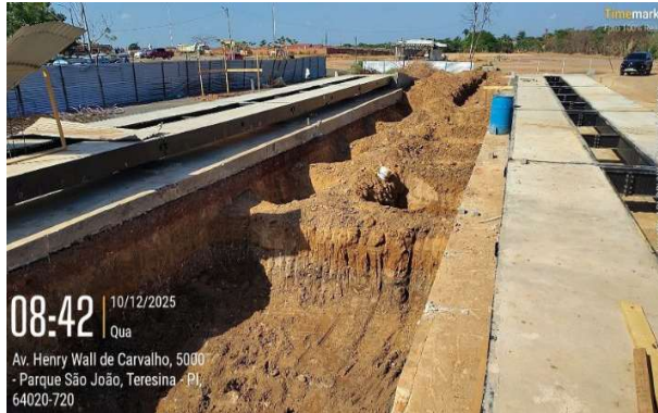
Figura 107: Execução de vala para fundação de guarita e reparo em balança
