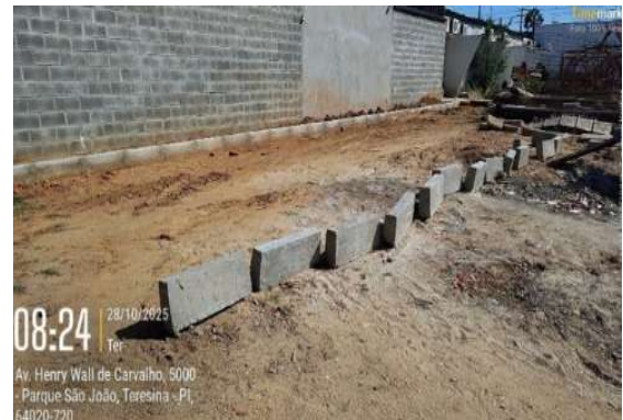
Figura 6: Inserção de blocos de concreto para meio fio na continuidade da nova via até o almoxarifado
