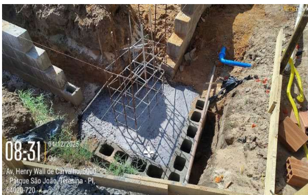
Figura 90: Inserção de armadura e concretagem de blocos de fundação
