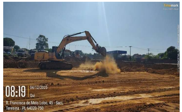
Figura 100: Terraplanagem de terreno (Corte, Aterro e Nivelamento)
