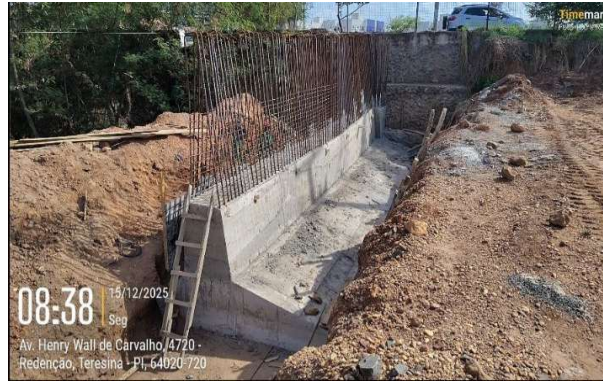
Figura 110: Concretagem de contraforte do muro de arrimo
