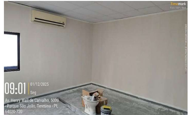
Figura 43: Pintura e lixamento sobre parede com a cor branca em diversos ambientes do Anexo Administrativo
