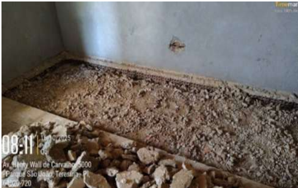
Figura 13: Quebra de revestimento cerâmico, reboco e parede, piso no Anexo Administrativo
