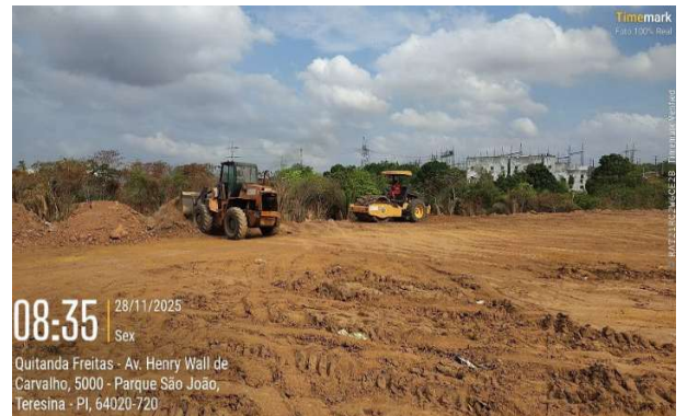
Figura 75: Terraplanagem de terreno (Corte ,Aterro)
