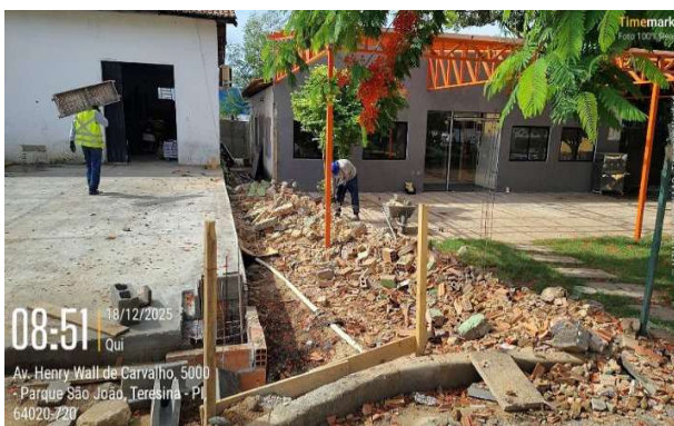
Figura 96: Quebra de muro entre o Anexo Administrativo e almoxarifado
