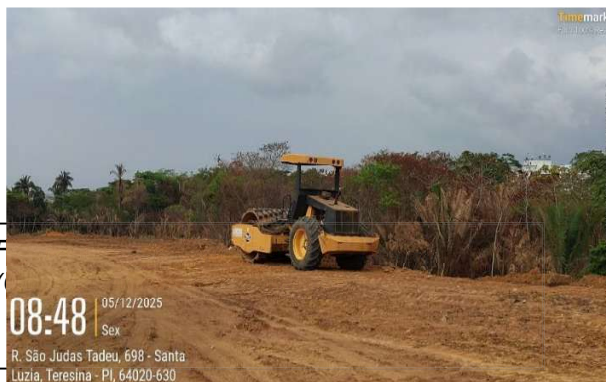
Figura 105: :Compactação de terreno com "pé de carneiro"
