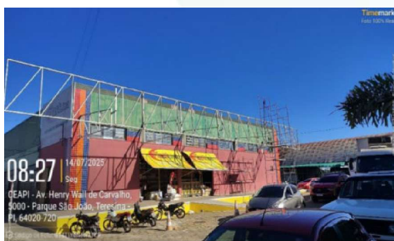
Figura 35: Instalação de treliças e barras metálicas pintadas na cor branca em fachadas e remoção da fachada antiga do galpão GP12-AMA.
