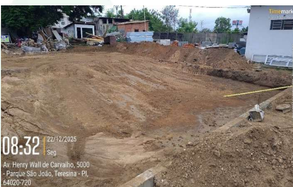
Figura 62: Corte de solo para execução de docas.
