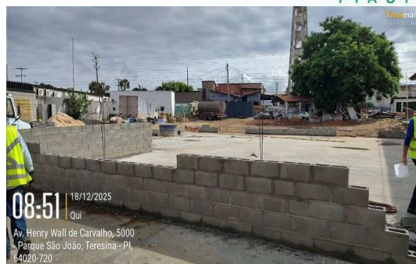
Figura 61: Assentamento de paredes com bloco de concreto estrutural.
