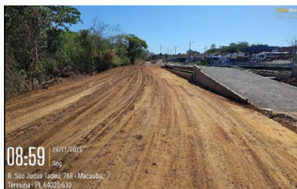
Figura 76: Limpeza, aterro, mistura e nivelamento para execução de via auxiliar da balança rodoviária.
