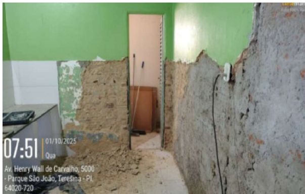
Figura 43: Demolição de revestimentos cerâmicos, reboco, paredes e pisos no Anexo Administrativo.
