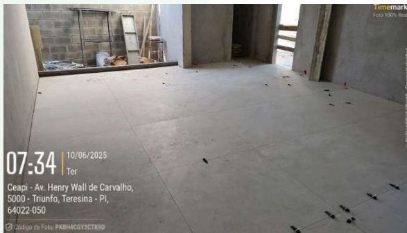
Figura 20: Aplicação de revestimento no piso em porcelanato em diversos ambientes da ADM19-ROX;
