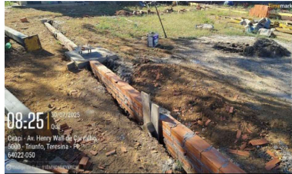
Figura 56: Assentamento com tijolos cerâmicos para execução de viga baldrame
