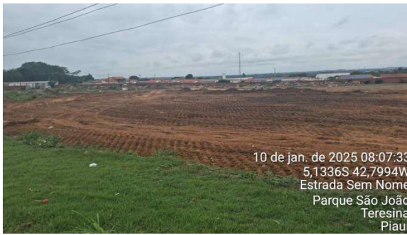
Figura 63: Transporte de aterro e regularização de solo na Área de Expansão.
