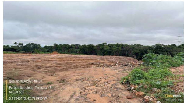
Figura 66: Transporte de aterro e regularização de solo na Área de Expansão.
