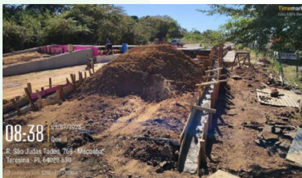
Figura 06: Aterro e compactação do solo no interior da rampa.
