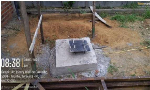
Figura 55: Concretagem em fundação na construção da expansão do almoxarifado;
