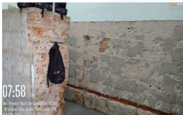
Figura 79: Demolição de superfície da parede em banheiro.
