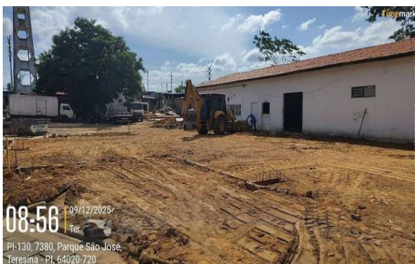
Figura 60: Aterro e nivelamento de superfície da expansão do almoxarifado.
