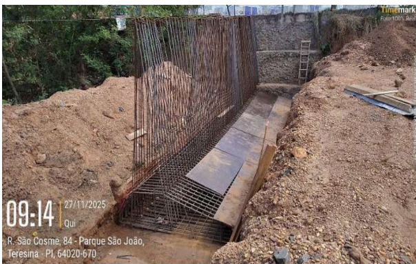
Figura 77: Inserção de armadura em muro de arrimo.
