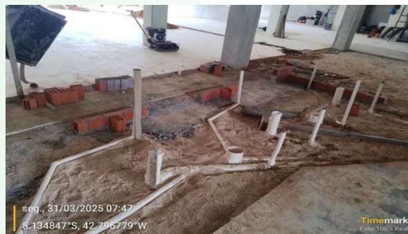
Figura 14: Execução de instalações hidrossanitárias dos banheiros da ADM19-ROX.
