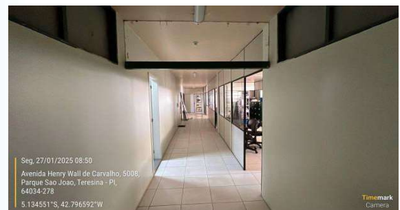
Figura 23: Corredor principal da sede administrativa antes da reforma.
