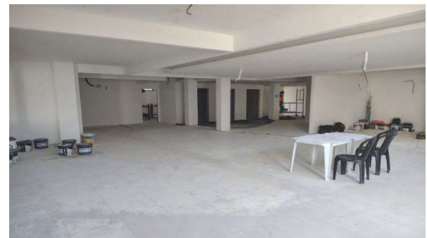
Figura 21: Emassamento e lixamento de paredes e forro na ADM19-ROX.
