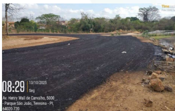
Figura 75: Imprimição de base em rotatória próxima da balança rodoviária.
