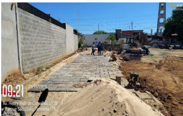
Figura 58: Execução de nova via até o almoxarifado.
