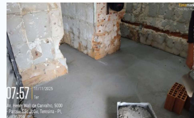
Figura 80: Execução de contrapiso para banheiro.
