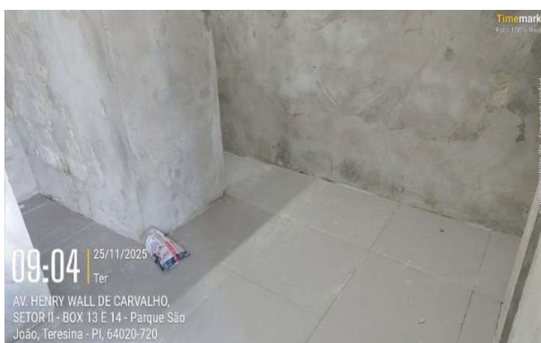
Figura 81: Aplicação de reboco sobre parede em banheiro.
