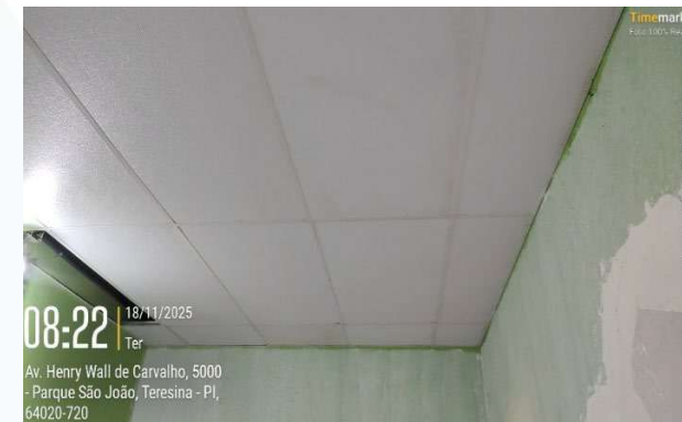
Figura 48: Instalação de forro em diversos ambientes no Anexo Administrativo.
