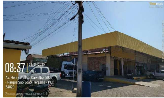
Figura 38: Instalação de chapas trapezoidais pintadas de amarelo na fachada leste e sul
