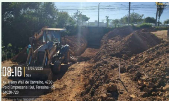
Figura 73: Corte de solo para construção e concretagem da base do muro de arrimo;
