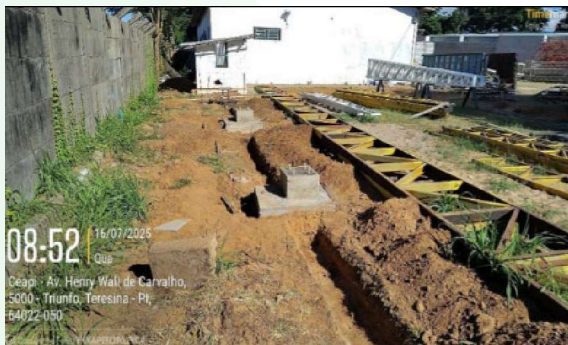
Figura 57: Escavação de vala para viga baldrame.
