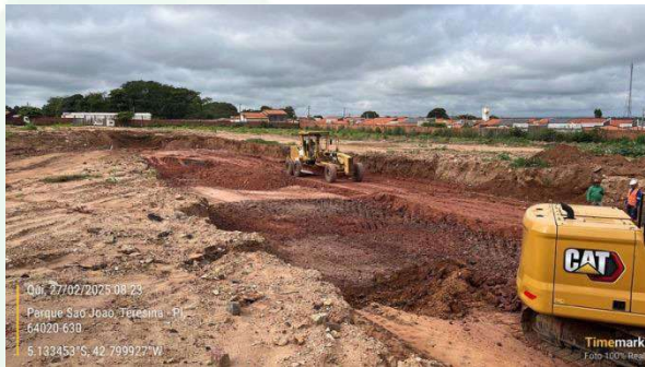
Figura 65: Execução de platôs e arruamentos na Área de Expansão.
