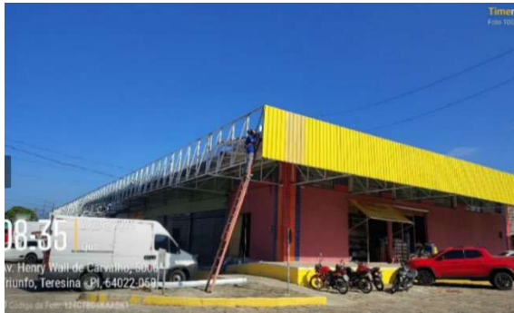
Figura 37: Instalação de chapas trapezoidais pintadas de amarelo na fachada leste e sul
