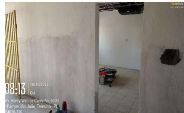
Figura 46: Pintura e aplicação de massa corrida e lixamento de diversos ambientes no Anexo Administrativo.
