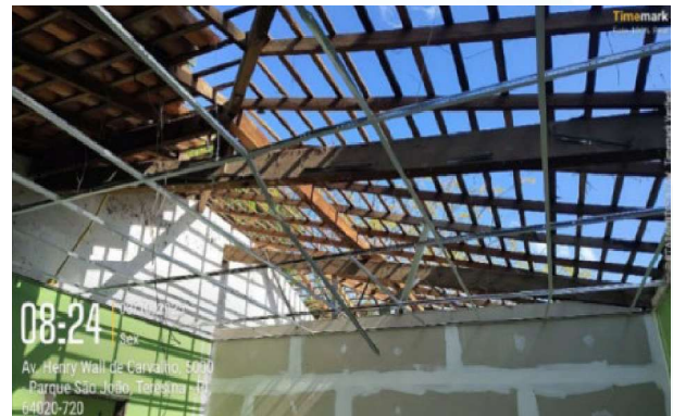
Figura 44: Substituição de telhas danificadas da estrutura antiga do Anexo Administrativo.
