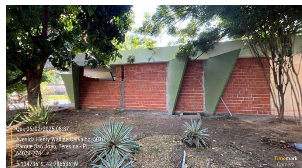
Figura 15: Construção de paredes de alvenaria em bloco cerâmico nas fachadas sul, oeste, norte e nas vedações internas da ADM19-ROX.
