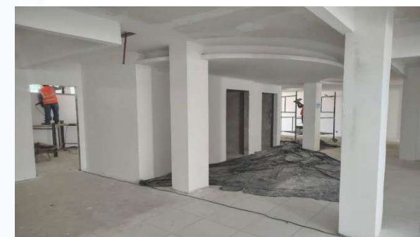
Figura 17: Construção de ambientes sanitários na ADM19-ROX;
