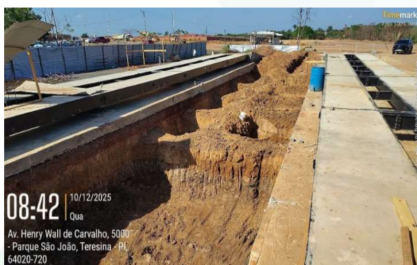
Figura 08: Execução de vala para fundação de guarita e reparo em balança.
