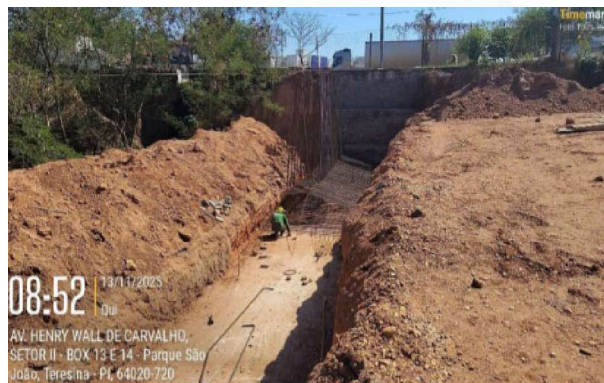
Figura 78: Execução de formas para concretagem de base de muro de arrimo.
