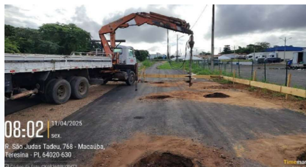
Figura 03: Perfuração para execução de estacas com caminhão com trado mecânico acoplado e manualmente;
