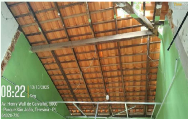
Figura 45: Substituição de telhas danificadas da estrutura antiga do Anexo Administrativo.
