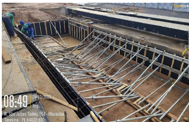
Figura 10: Execução de formas para concretagem de viga-baldrame na lateral da balança rodoviária com escoramento.
