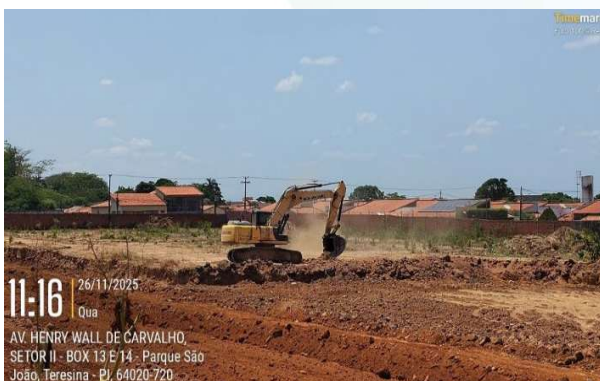
Figura 67: Terraplanagem de terreno (corte e aterro)
