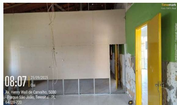
Figura 42: Execução de parede de drywall no setor de engenharia
