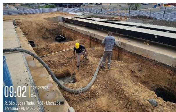
Figura 09: Concretagem da fundação da guarita das balanças rodoviárias.
