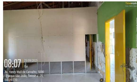
Figura 40: Execução de parede de drywall no setor de engenharia
