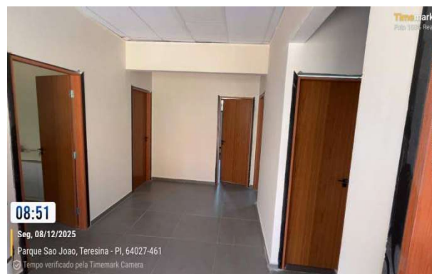
Figura 52: Instalação de bancada com cuba nos banheiros.
