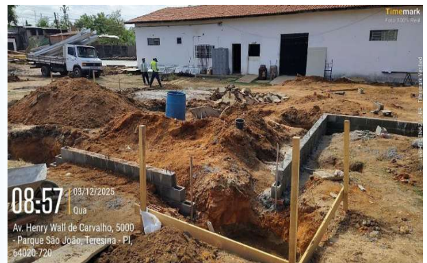
Figura 59: Assentamento de viga baldrame com bloco de concreto estrutural na expansão do almoxarifado.
