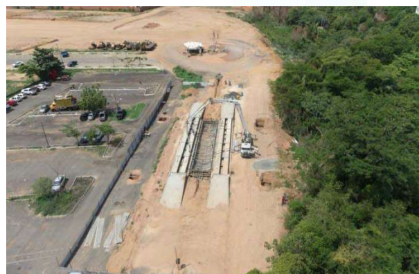
Figura 11: Concretagem de fundações da região central do pórtico das balanças rodoviárias.
