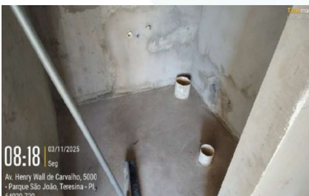
Figura 47: Execução de contrapiso do Anexo Administrativo.
