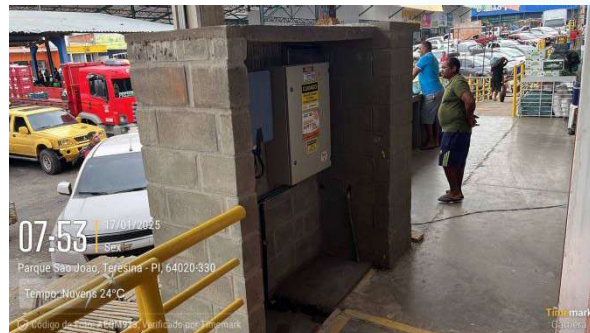
Figura 34: Construção de abrigo para inversor de sistema de energia solar com capacidade de geração de 35,1 kWp e potência nominal de saída de 25 kW (1,50x0,60mx2,00m) em bloco de concreto estrutural no lado Norte do GP14-VER.
