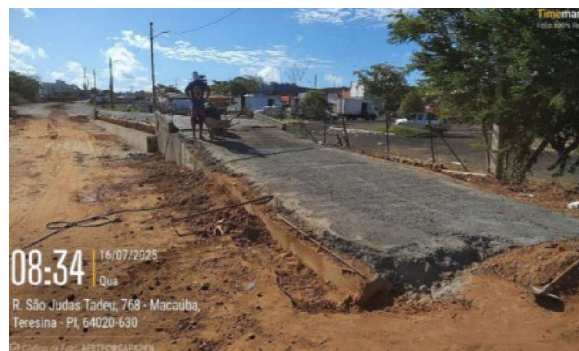
Figura 07: Concretagem de rampas das balanças rodoviárias.
