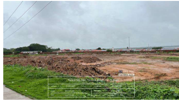
Figura 64: Transporte de aterro e regularização de solo na Área de Expansão.
