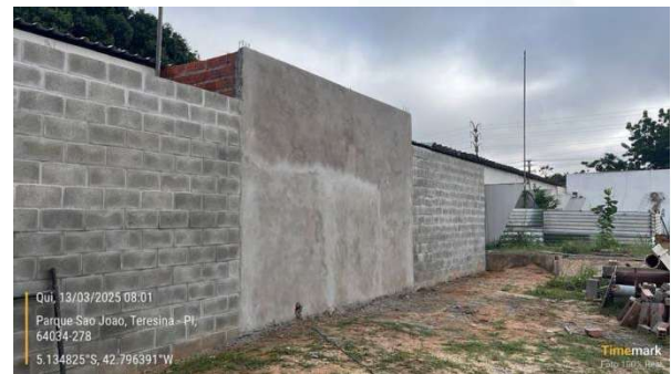
Figura 13: Reboco de paredes de alvenaria executadas na ADM19-ROX.
