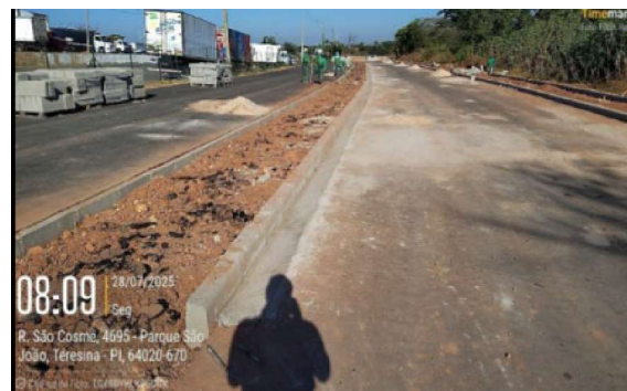
Figura 74: Execução de sarjetas para calçada da faixa central e lateral
