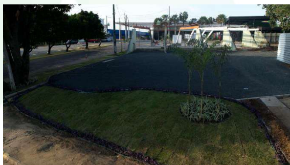
Figura 32: Nivelamento do solo, aterro com piçarra, areia vegetal e finalização com brita na Central de Eventos.
