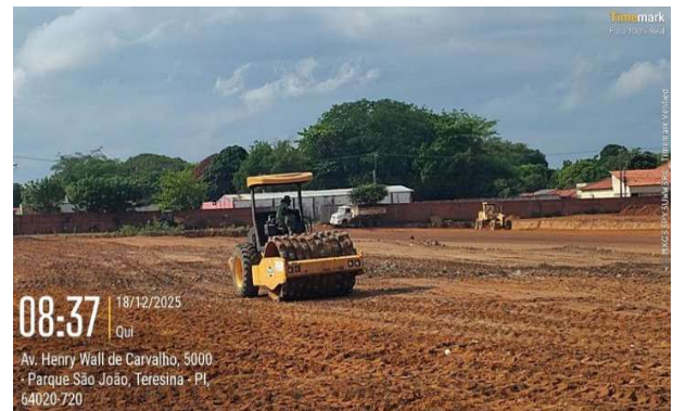
Figura 72: Compactação de terreno com rolo compactador.
