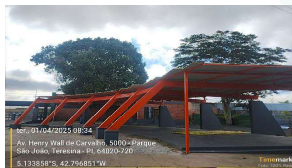
Figura 31: Instalação de telhas trapezoidais na cobertura do antigo Galpão Trindade.
