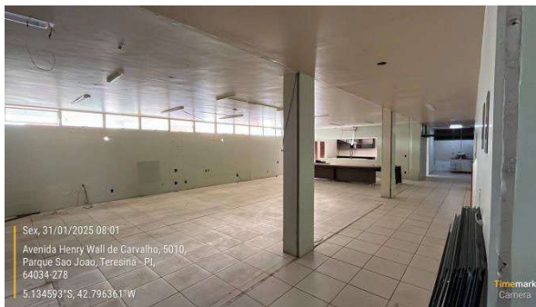
Figura 12: Desmobilização e retirada de divisórias, vidros, componentes elétricos e portas da ADM19-ROX.
