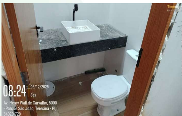
Figura 51: Instalação de bancada com cuba nos banheiros.
