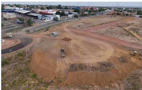
Figura 68: Terraplanagem de terreno (corte e aterro)
