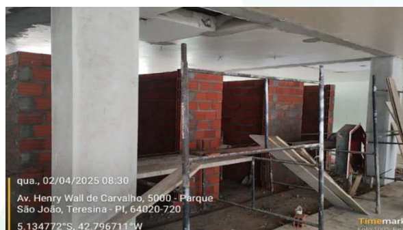
Figura 16: Construção de ambientes sanitários na ADM19-ROX;
