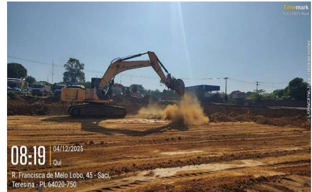
Figura 70: Terraplanagem de terreno (corte, aterro e nivelamento)
