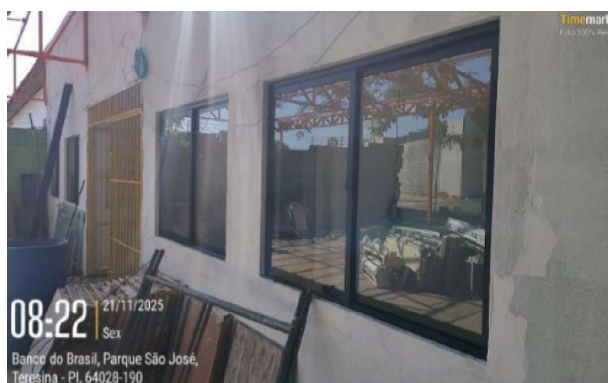
Figura 49: Instalação de esquadria e vidros em portas e janelas.
