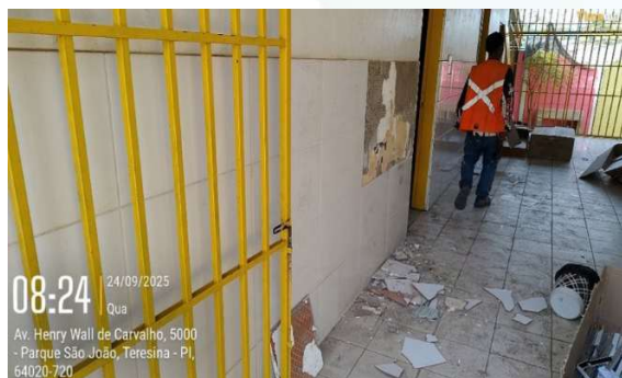
Figura 41: Limpeza e remoção de elementos(janelas e peças cerâmicas) do setor de engenharia
