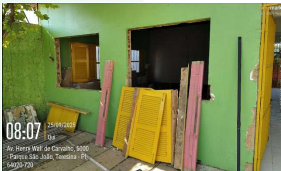
Figura 39: Limpeza e remoção de elementos(janelas e peças cerâmicas) do anexo administrativo
