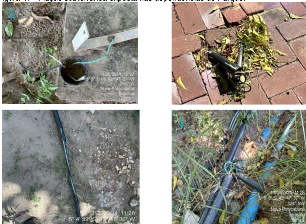
Figura 47 - Fiação subterrânea exposta nas dependências do Parque.
