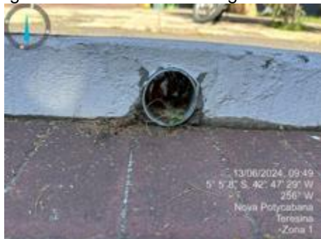
Figura 52 - Canais de drenagem obstruídos
