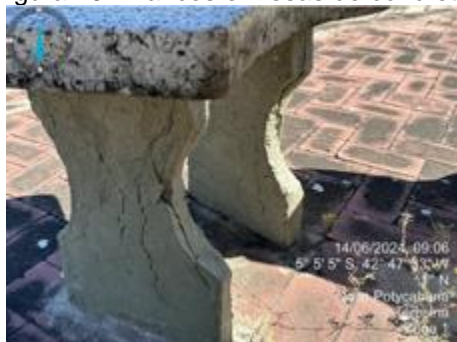
Figura 40 - Bancos e mesas de concreto com rachaduras.
