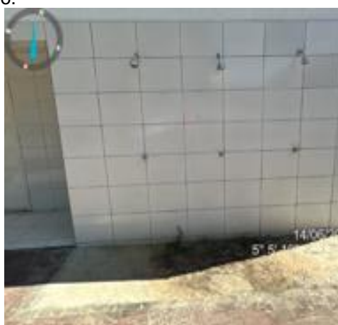
Figura 34- Ralos dos chuveiros externos obstruídos de areia e box sem instalação de chuveiro.
