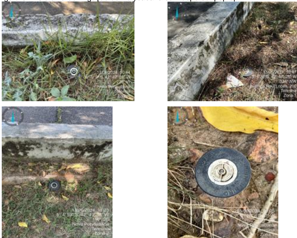
Figura 62 - Sistema de irrigação do Potycabana com aspersor pop up.
