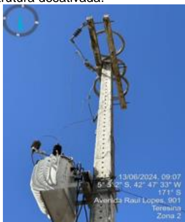
Figura 44 - Transformador e instalação remanescente de antiga subestação – infraestrutura desativada.
