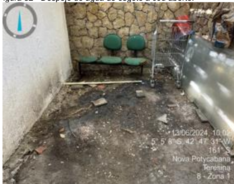
Figura 32 - Despejo de água de esgoto a céu aberto.
