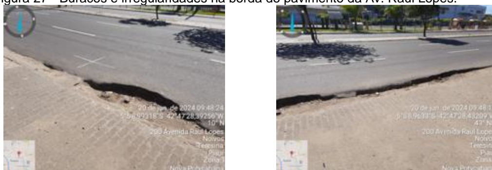
Figura 27 - Buracos e irregularidades na borda do pavimento da Av. Raul Lopes.
