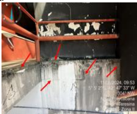
Figura 28 - Manifestações patológicas estruturais no mezanino e corrosão na escada metálica.
