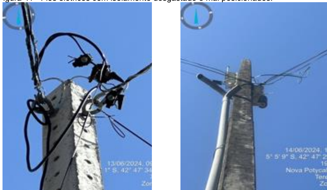
Figura 41 - Fios elétricos com isolamento desgastado e mal posicionados.
