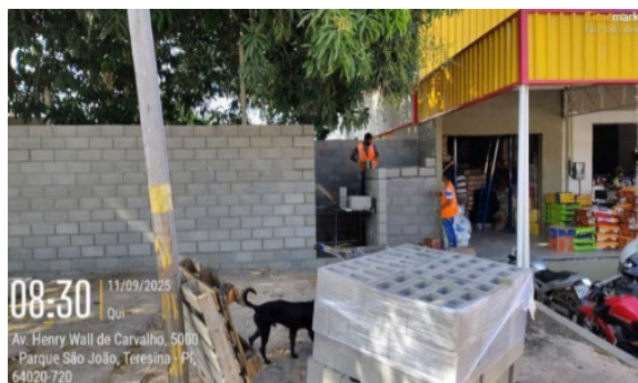
Figura 56: Assentamento com bloco de concreto estrutural em parede
