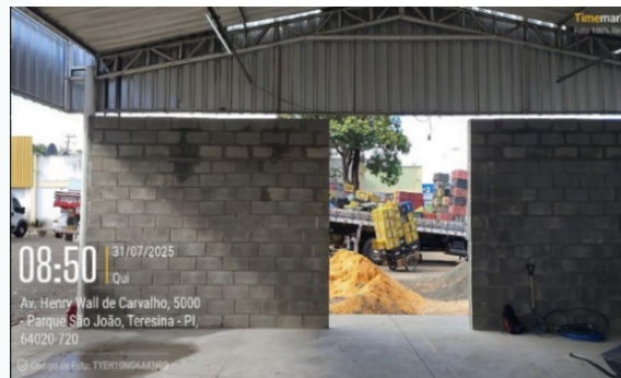
Figura 13: Assentamento de parede com bloco de concreto estrutural e inserção de armadura entre os furos.
