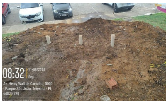
Figura 37: Execução de fossa séptica.
