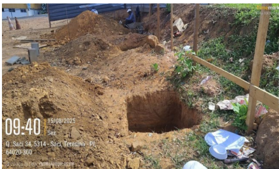
Figura 70: Escavação para fundação(blocos)
