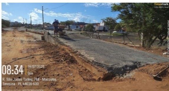
Figura 63: Concretagem de rampas das balanças
