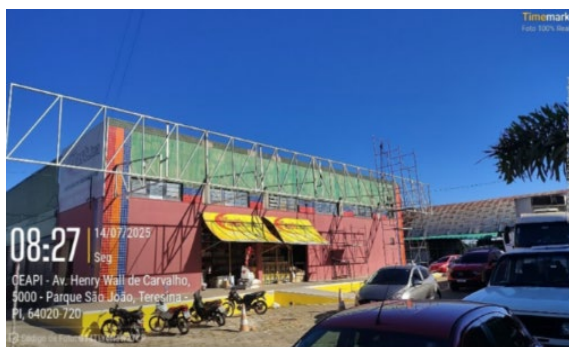
Figura 02: Instalação de treliças e barras metálicas pintadas na cor branca em fachadas e remoção da fachada antiga do galpão GP12-AMA.
