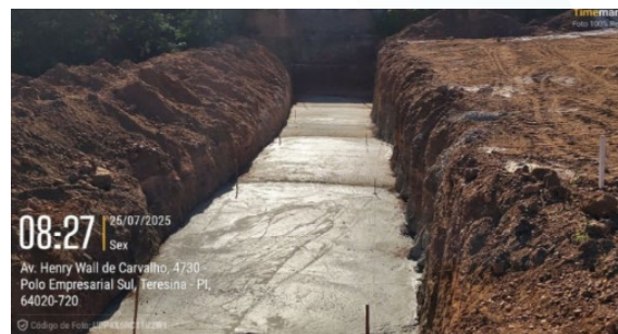
Figura 68: Corte de solo para construção e concretagem da base do muro de arrimo;
