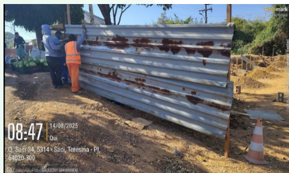
Figura 69: Instalação de tapumes.
