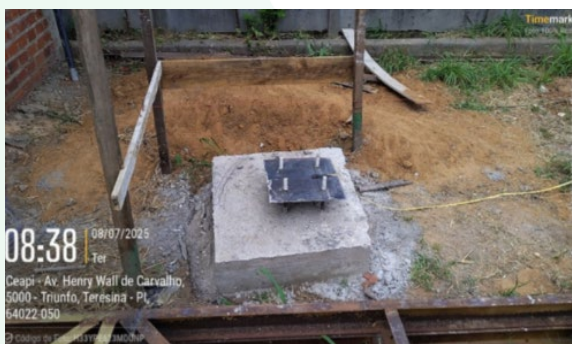
Figura 16: Concretagem em fundação na construção da expansão do almoxarifado;
