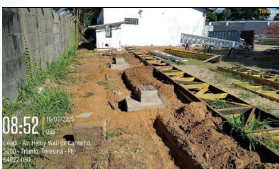
Figura 19: Escavação de vala para viga baldrame.
