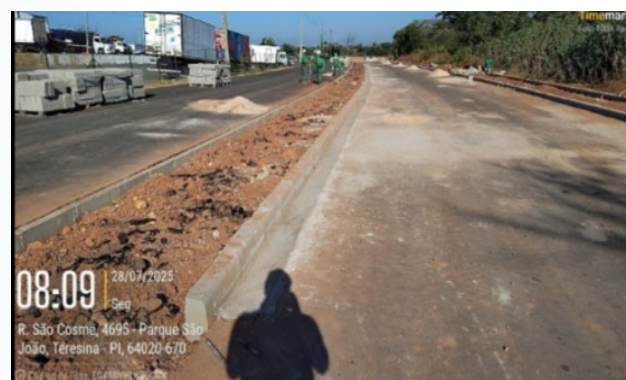
Figura 66: Execução de sarjetas para calçada da faixa central e lateral
