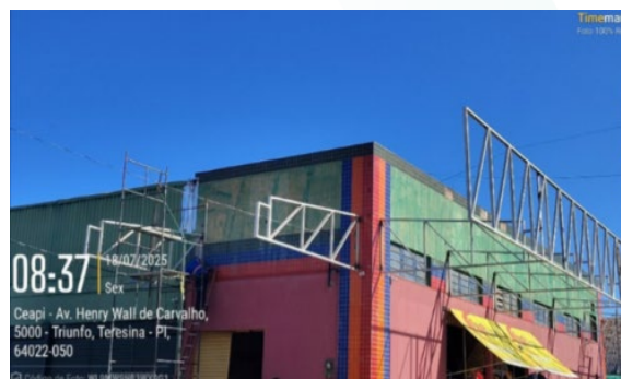
Figura 03: Instalação de treliças e barras metálicas pintadas na cor branca em fachadas e remoção da fachada antiga do galpão GP12-AMA.
