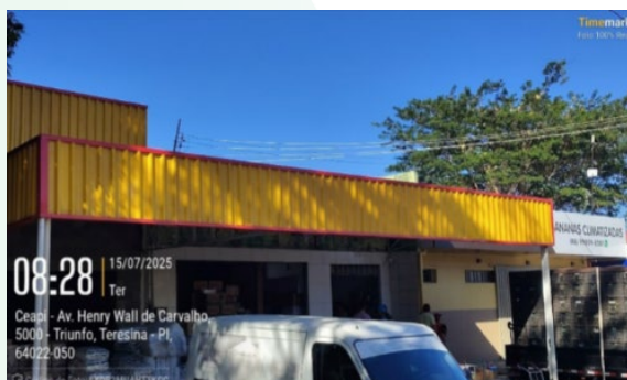
Figura 10: Instalação de calha de zinco, barras metálicas e telhas trapezoidais em fachada e cobertura da construção.
