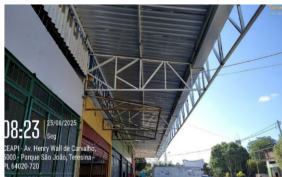
Figura 05: Instalação de calhas de zinco e chapas trapezoidais brancas no galpão GP12-AMA.
