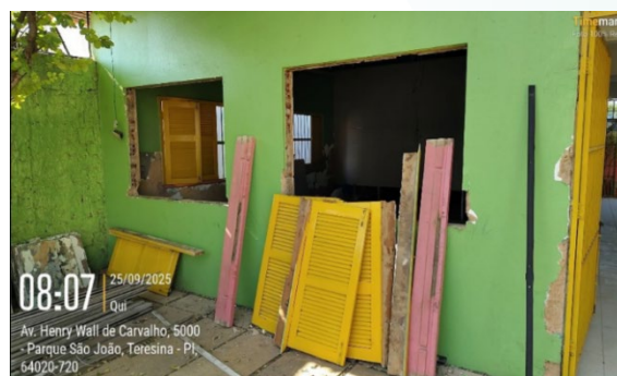
Figura 57: Limpeza e remoção de elementos (janelas e peças cerâmicas) do setor de engenharia
