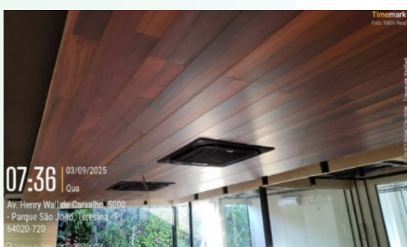
Figura 52: :Execução de perfil amadeirado sobre tecto rebaixado
