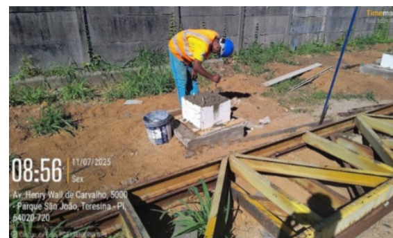
Figura 17: Concretagem em fundação na construção da expansão do almoxarifado;
