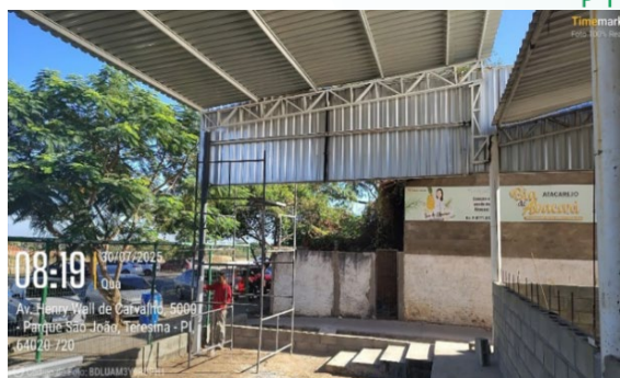
Figura 15: Instalação de treliças, barras e chapas trapezoidais brancas em telhado.
