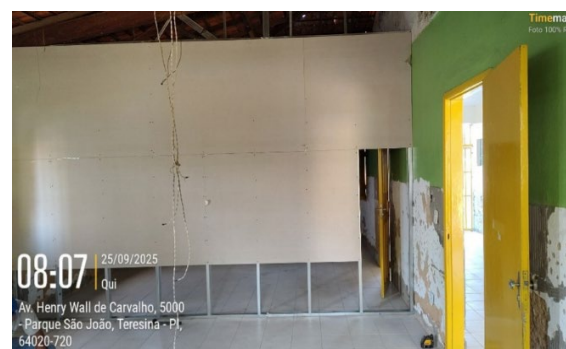
Figura 59: Execução de parede de drywall no setor de engenharia
