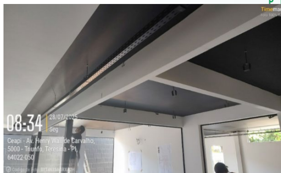
Figura 41: Instalação de eletrocalhas.
