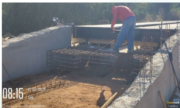
Figura 61: Inserção de blocos de armadura para concretagem no interior da rampa
