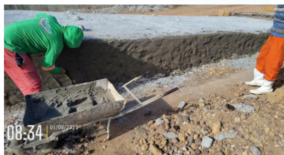
Figura 64: Acabamento em rampa e nas laterais.
