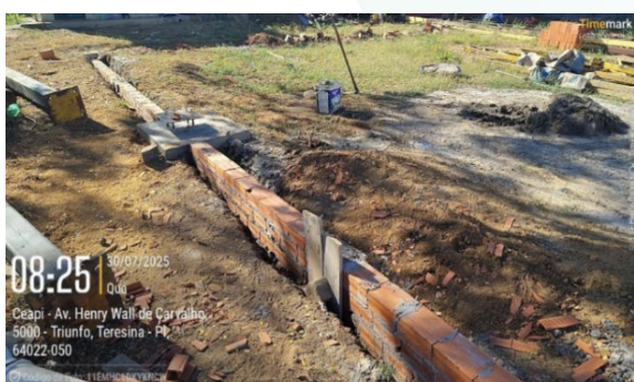
Figura 18: Assentamento com tijolos cerâmicos para execução de viga baldrame
