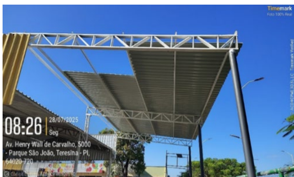
Figura 14: Instalação de treliças, barras e chapas trapezoidais brancas em telhado.
