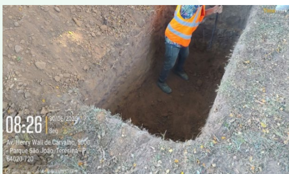
Figura 36: Execução de fossa séptica.
