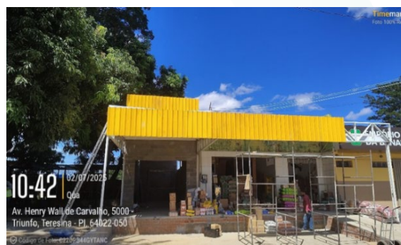
Figura 09: Instalação de calha de zinco, barras metálicas e telhas trapezoidais em fachada e cobertura.
