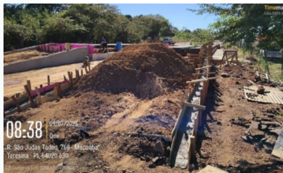
Figura 62: Aterro e compactação do solo no interior da rampa.
