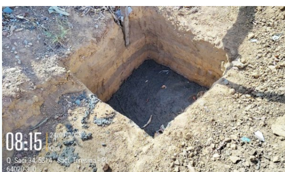
Figura 72: Concretagem com concreto magro em base de fundação.
