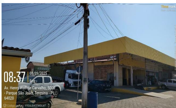
Figura 07: Instalação de chapas trapezoidais pintadas de amarelo na fachada leste e sul
