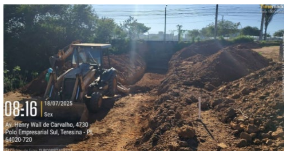
Figura 67: Corte de solo para construção e concretagem da base do muro de arrimo;
