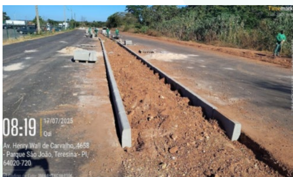
Figura 65: Execução de meio fio na faixa central e faixa lateral próximo à balança rodoviária.
