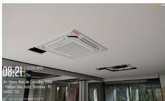
Figura 47: Instalação de ar condicionado em diversos ambientes
