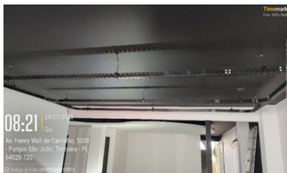
Figura 40: Instalação de eletrocalhas.
