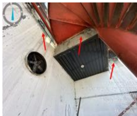
Figura 28 - Manifestações patológicas estruturais no mezanino e corrosão na escada metálica.
