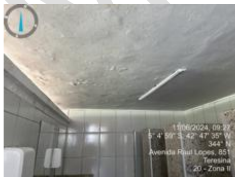
Figura 33 – Banheiros de uso público.
