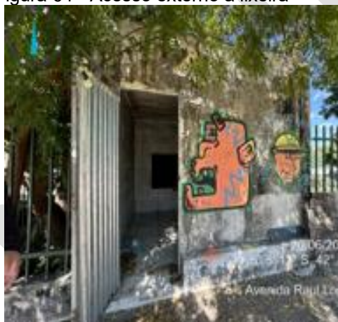
Figura 64 - Acesso externo à lixeira
