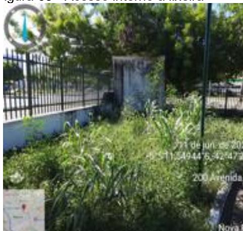
Figura 63 - Acesso interno à lixeira
