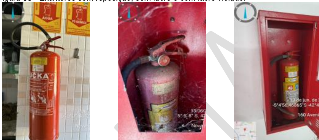
Figura 55 - Extintores sem reposição, sem lacre e com lacre violado.
