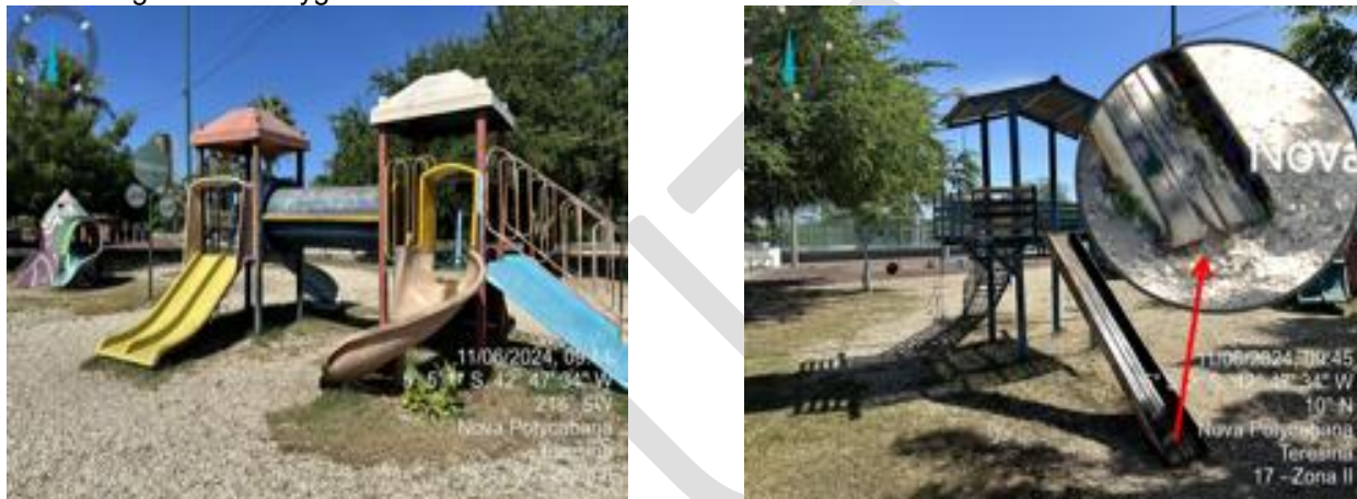
Figura 39 - Playground abandonado e danos na estrutura.
