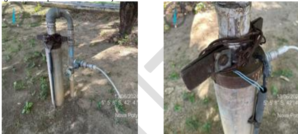
Figura 59 - Poço instalado no Potycabana.
