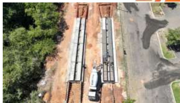
Figura 53: Concretagem de módulos internos das balanças;
