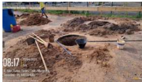
Figura 39: Perfuração para execução de estacas com caminhão com trado mecânico acoplado e manualmente;
