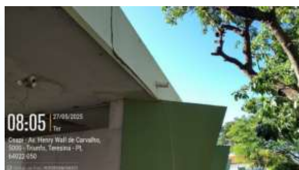
Figura 23: Instalação de manta impermeabilizante e argamassa polimérica em laje ,teste de vazamento e furo na platibanda para inserção de tubo para drenagem pluvial;
