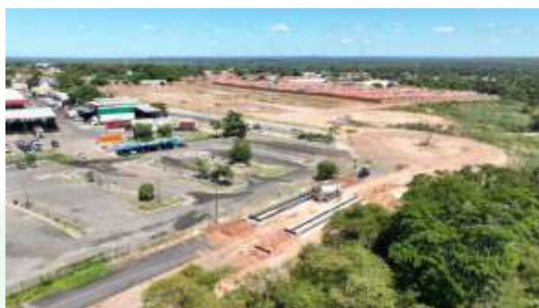
Figura 36: Vista geral das balanças rodoviárias.
