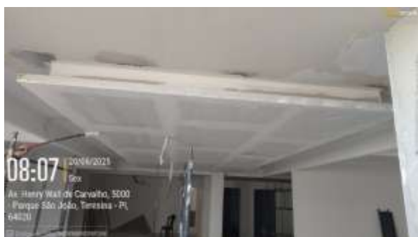
Figura 24: Aplicação de detalhes de gesso no forro da ADM19-ROX;
