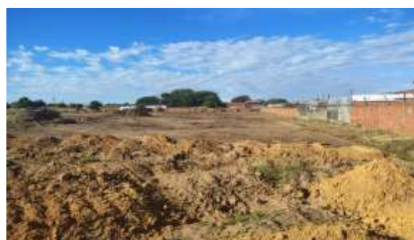
Figura 35: Limpeza da vegetação local na área de expansão.
