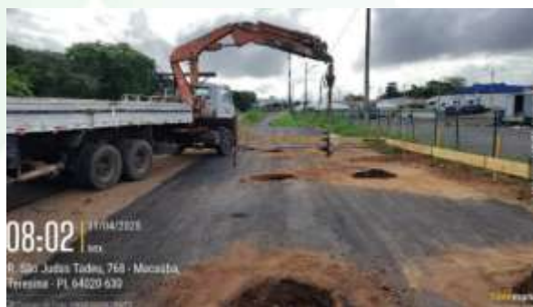
Figura 38: Perfuração para execução de estacas com caminhão com trado mecânico acoplado e manualmente;
