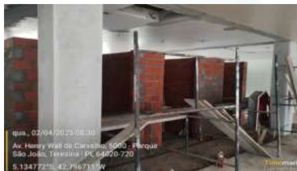
Figura 13: Construção de ambientes sanitários na ADM19-ROX;
