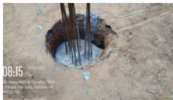
Figura 41: Inserção de armaduras e concretagem de estacas da fundação das balanças;
