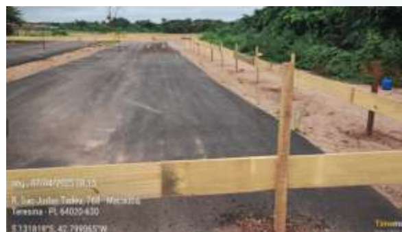
Figura 37: Execução do gabarito de obra na construção das balanças rodoviárias, localizadas próximo à rotatória na área de expansão;
