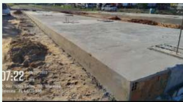
Figura 48: Concretagem do piso da balança e nivelamento do concreto na construção das balanças rodoviárias.
