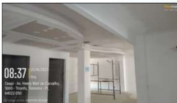
Figura 25: Aplicação de detalhes de gesso no forro da ADM19-ROX;
