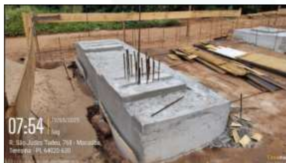
Figura 44: Inserção de armaduras e concretagem de blocos de fundação das balanças;
