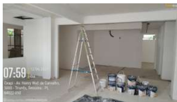
Figura 29: Emassamento e lixamento de paredes e forro na ADM19-ROX.
