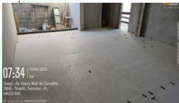
Figura 26: Aplicação de revestimento no piso em porcelanato em diversos ambientes da ADM19-ROX;
