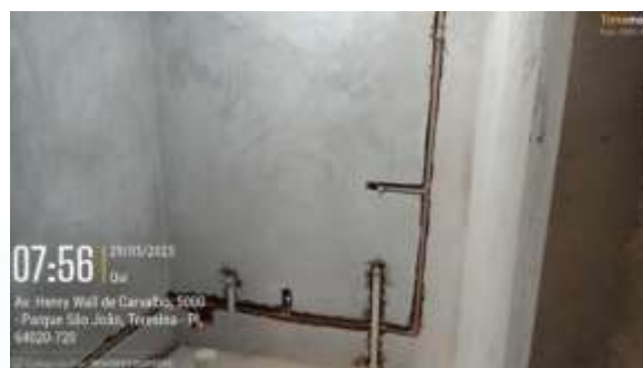
Figura 11: Inserção de instalações hidrossanitárias nos banheiros da ADM19-ROX;
