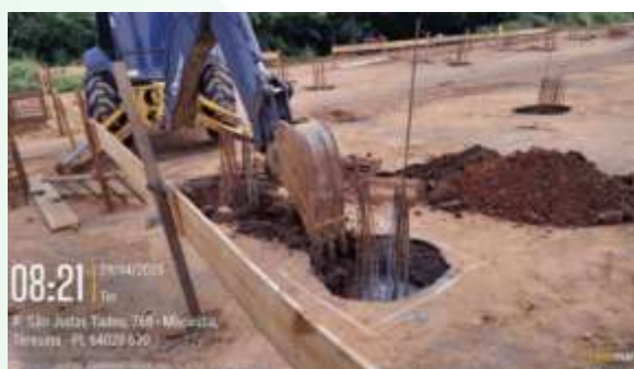
Figura 42: Escavação de camada asfáltica presente entre os blocos de fundação com o auxílio de retroescavadeira.
