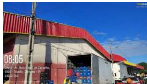
Figura 03: Instalação e corte de telhas metálicas trapezoidais pintadas de vermelho e barras metálicas pintadas de amarelo na fachada sul, leste e norte da platibanda no galpão GP14-VER.
