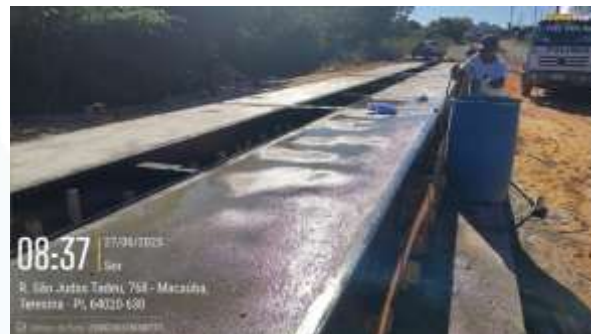
Figura 51: Concretagem de módulos internos das balanças;
