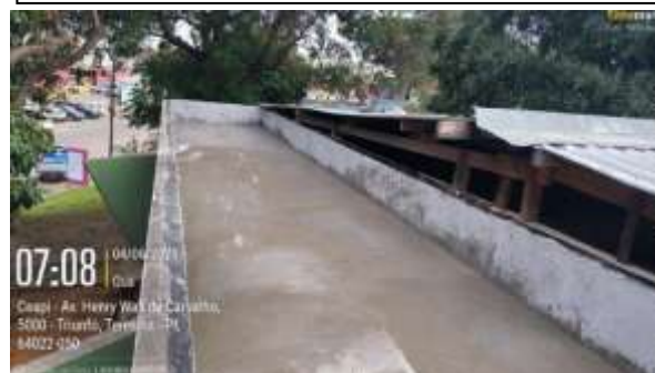
Figura 21: Instalação de manta impermeabilizante e argamassa polimérica em laje ,teste de vazamento e furo na platibanda para inserção de tubo para drenagem pluvial;
