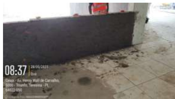
Figura 19: Assentamento e reboco de parede em tijolos cerâmicos na sala de reunião e banheiro;
