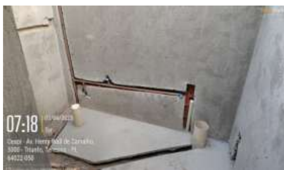
Figura 12: Inserção de instalações hidrossanitarias nos banheiros da ADM19-ROX;
