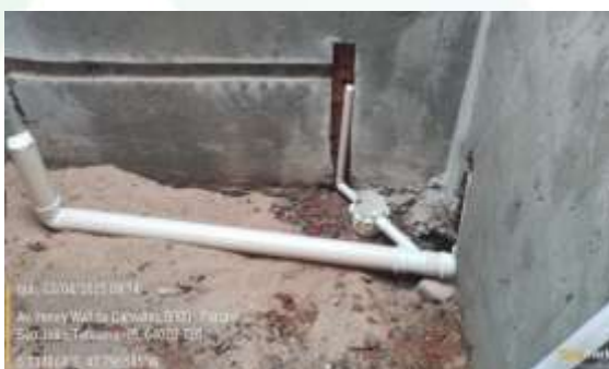
Figura 10: Inserção de instalações hidrossanitárias nos banheiros da ADM19-ROX;
