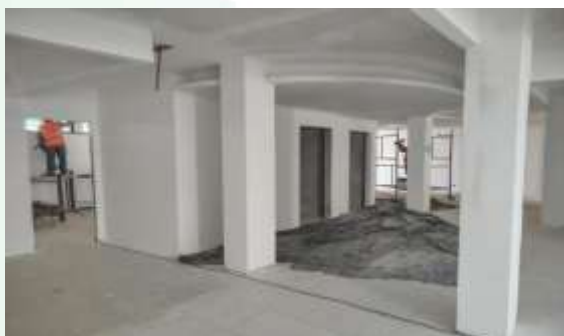
Figura 14: Construção de ambientes sanitários na ADM19-ROX;
