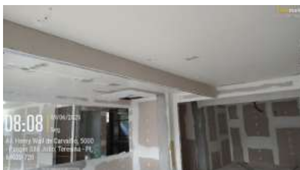
Figura 18: Instalação de paredes de drywall em diversos ambientes na ADM19-ROX .
