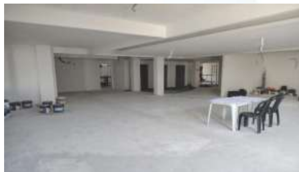
Figura 31: Emassamento e lixamento de paredes e forro na ADM19-ROX.
