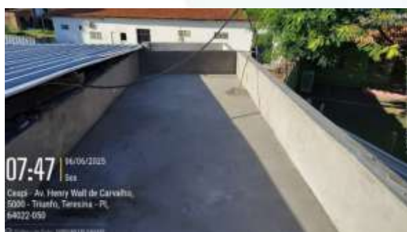
Figura 22: Instalação de manta impermeabilizante e argamassa polimérica em laje ,teste de vazamento e furo na platibanda para inserção de tubo para drenagem pluvial;
