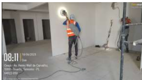
Figura 30: Emassamento e lixamento de paredes e forro na ADM19-ROX.
