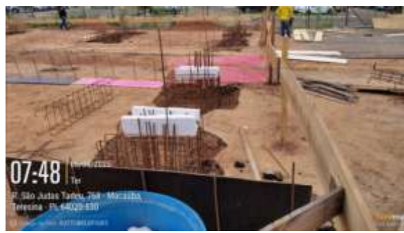
Figura 43: Inserção de armaduras e concretagem de blocos de fundação das balanças;
