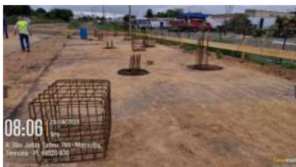
Figura 40: Inserção de armaduras e concretagem de estacas da fundação das balanças;
