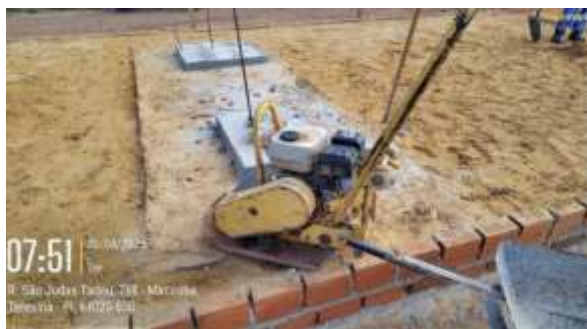
Figura 46: Aterro e compactação entre os blocos de fundação
