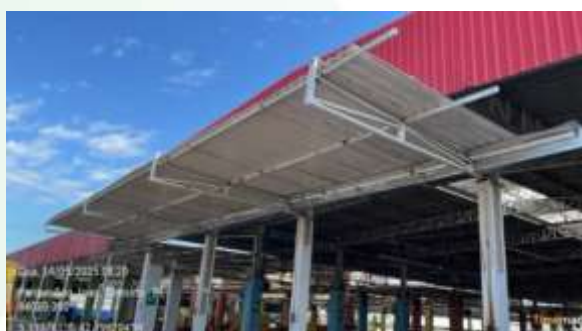
Figura 02: Construção de nova marquise presente na fachada sul do galpão GP14-VER;
