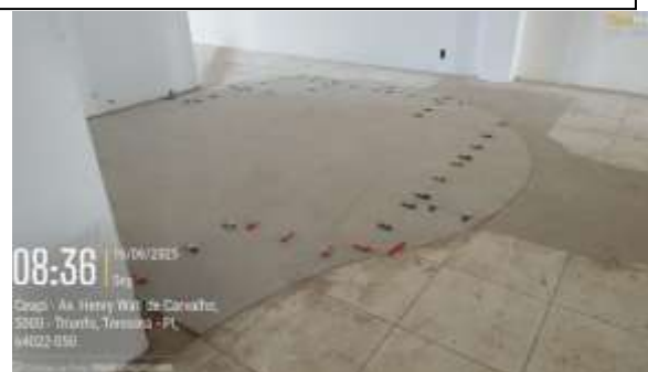
Figura 27: Aplicação de revestimento no piso em porcelanato em diversos ambientes da ADM19-ROX;
