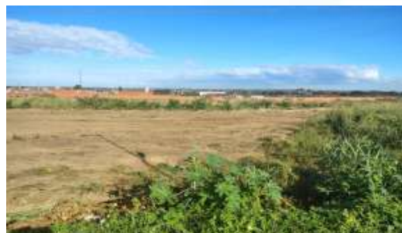
Figura 33: Limpeza da vegetação local na área de expansão.
