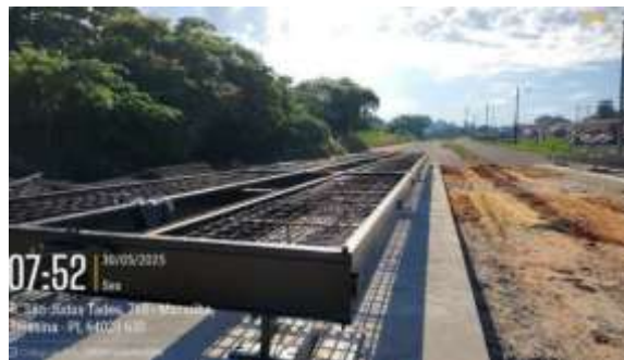
Figura 49: Instalação dos módulos das balanças rodoviárias.
