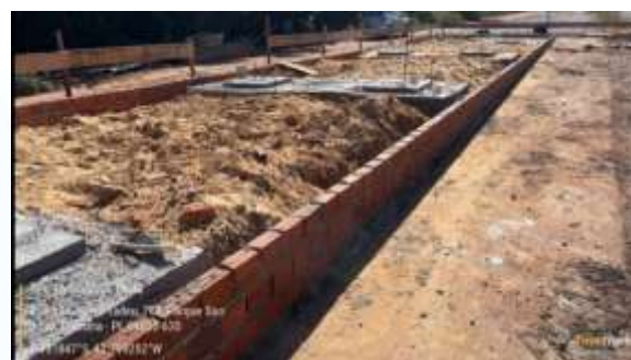
Figura 45: Aterro e compactação entre os blocos de fundação
