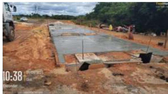
Figura 47: Concretagem do piso da balança e nivelamento do concreto na construção das balanças rodoviárias.
