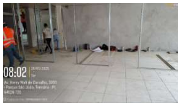
Figura 15: Instalação de paredes de drywall em diversos ambientes na ADM19-ROX .
