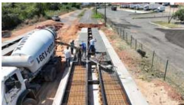
Figura 52: Concretagem de módulos internos das balanças;
