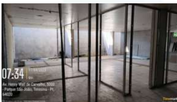
Figura 16: Instalação de paredes de drywall em diversos ambientes na ADM19-ROX .
