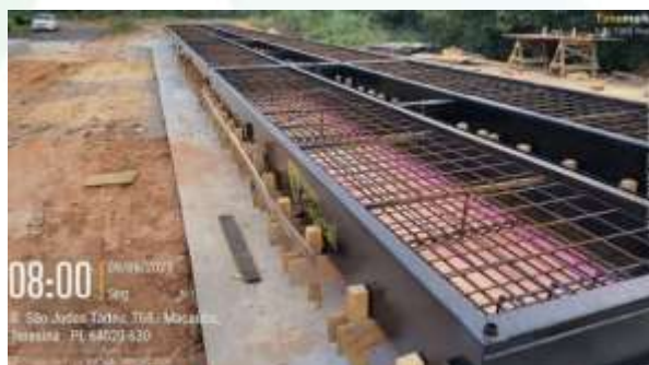
Figura 50: Execução de fôrmas em madeirite resinado para concretagem de módulos internos das balanças;
