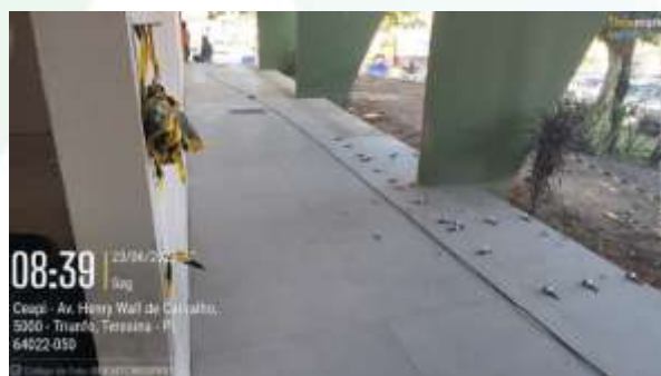
Figura 28: Aplicação de revestimento no piso em porcelanato em diversos ambientes da ADM19-ROX;
