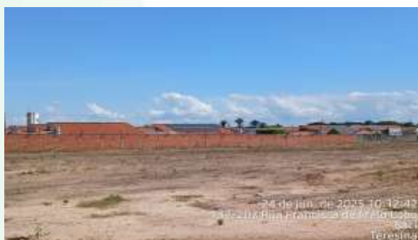
Figura 34: Limpeza da vegetação local na área de expansão.
