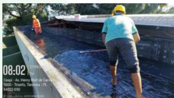
Figura 20: Instalação de manta impermeabilizante e argamassa polimérica em laje ,teste de vazamento e furo na platibanda para inserção de tubo para drenagem pluvial;
