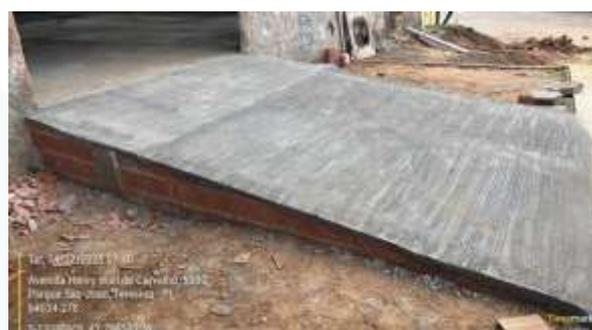
Figura 48: Execução de rampa com 4,40m de comprimento e 2,80m de largura na área externa da Metalúrgica.
