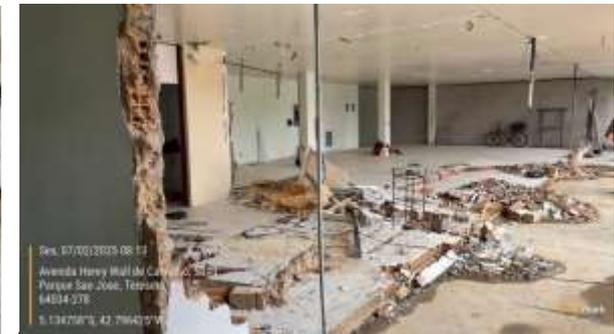
Figura 60: Demolição de paredes de alvenaria em bloco cerâmico nas fachadas sul, oeste e norte da ADM19-ROX.
