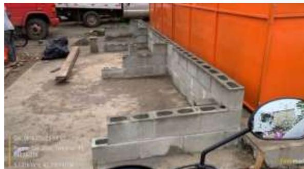
*Figura 07: Execução de alvenaria em bloco de concreto estrutural para construção de depósito (7,46x1,22x1,86m) de resíduos com capacidade para três contêineres de lixo de 1000L ao lado da loja Quitanda, no final da Rua 1.*
