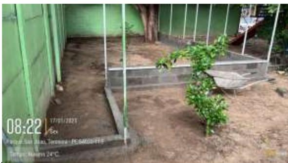
*Figura 19: Construção de viveiro de aves de 60 m<sup>2</sup> em blocos de concreto estrutural e tubos de metalon soldados no Centro de Recreação e Reforço Infantil.*
