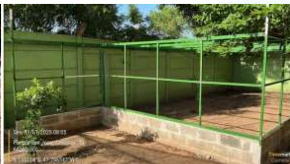
*Figura 20: Construção de viveiro de aves de 60 m<sup>2</sup> em blocos de concreto estrutural e tubos de metalon soldados no Centro de Recreação e Reforço Infantil.*
