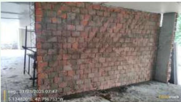
*Figura 65: Construção de paredes de alvenaria em bloco cerâmico nas fachadas sul, oeste, norte e nas vedações internas da ADM19-ROX.*
