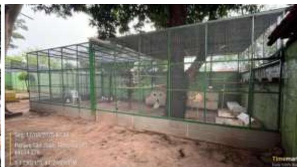
*Figura 22: Construção de viveiro de aves de 60 m<sup>2</sup> em blocos de concreto estrutural e tubos de metalon soldados no Centro de Recreação e Reforço Infantil.*
