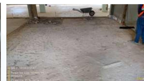
Figura 56: Demolição de revestimentos e retirada de esquadrias.
