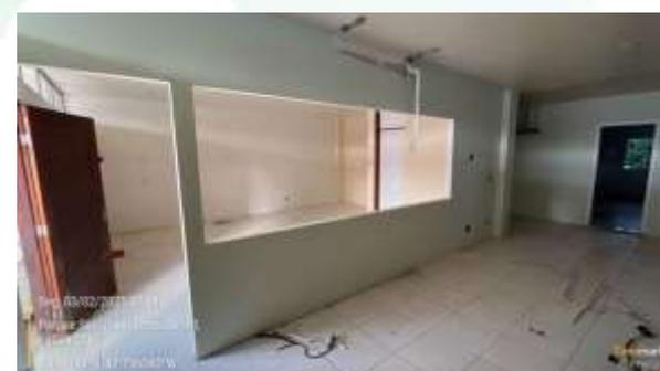
Figura 55: Desmobilização e retirada de divisórias, vidros, componentes elétricos e portas da ADM19-ROX.
