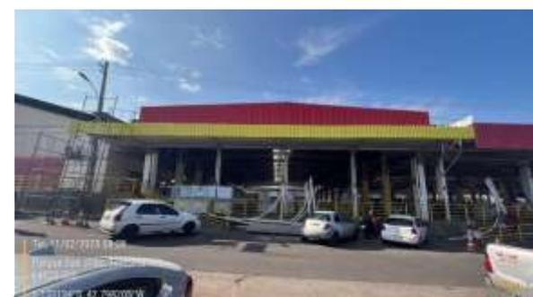
*Figura 18: Instalação de platibandas em telhas metálicas trapezoidais nas fachadas Sul e lado Norte do GP14-VER (Central do Varejo e Galpão de Ligação)*
