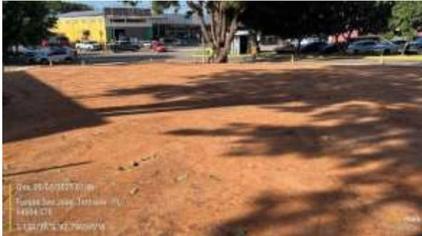
Figura 33: Nivelamento do solo, aterro com piçarra, areia vegetal e finalização com brita na Central de Eventos.
