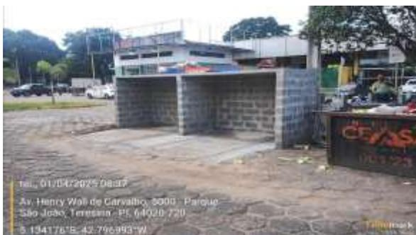
*Figura 06: Construção de abrigo em bloco de concreto estrutural (1,20x4,80x1,80m) para instalação de dois containers de 1000L para depósito de lixo na rua 7.*
