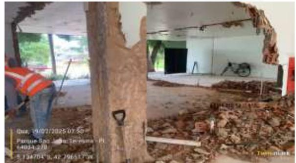
Figura 58: Demolição de paredes de alvenaria em bloco cerâmico nas fachadas sul, oeste e norte da ADM19-ROX.
