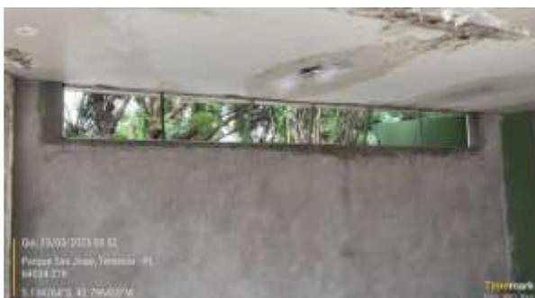
*Figura 75: Instalação de contramarcos onde serão instalados os basculantes nas fachadas Oeste e Norte da ADM19-ROX.*
