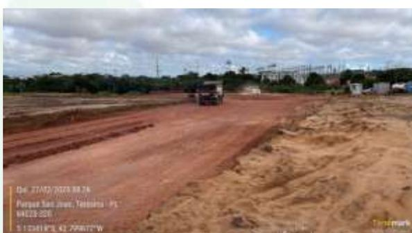
Figura 87: Execução de platôs e arruamentos na Área de Expansão.
