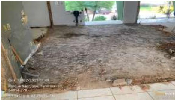
Figura 57: Demolição de revestimentos e retirada de esquadrias.
