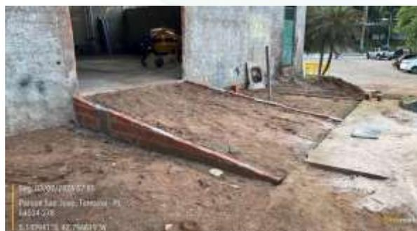
Figura 47: Execução de rampa com 4,40m de comprimento e 2,80m de largura na área externa da Metalúrgica.
