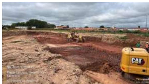
Figura 88: Execução de platôs e arruamentos na Área de Expansão.
