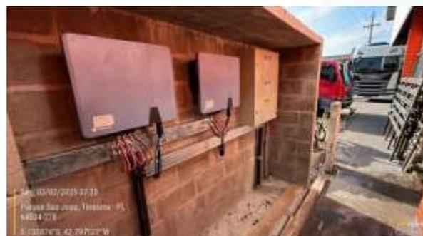
Figura 09: Instalação de inversores para sistema de energia solar com capacidade de geração de 70,2 kWp e potência de saída de 50 kW no lado leste do GP02-AZL.
