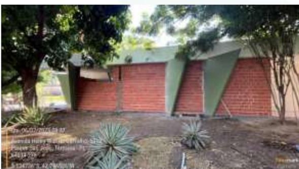
*Figura 67: Construção de paredes de alvenaria em bloco cerâmico nas fachadas sul, oeste, norte e nas vedações internas da ADM19-ROX.*
