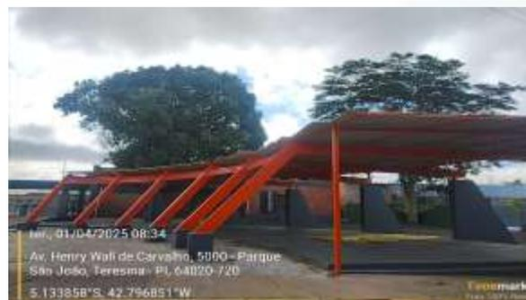
Figura 40: Instalação de telhas trapezoidais na cobertura do antigo Galpão Trindade.
