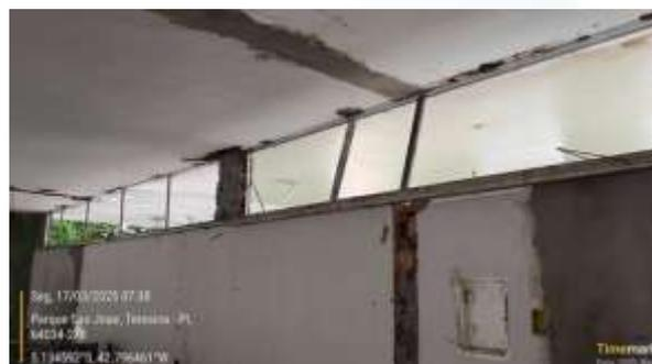
*Figura 76: Instalação de contramarcos onde serão instalados os basculantes nas fachadas Oeste e Norte da ADM19-ROX.*
