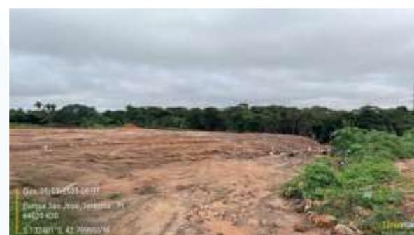
Figura 84: Transporte de aterro e regularização de solo na Área de Expansão.
