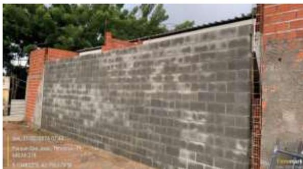
*Figura 69: Construção de paredes de alvenaria em bloco de concreto estrutural na fachada sul e nas vedações internas da ADM19-ROX.*
