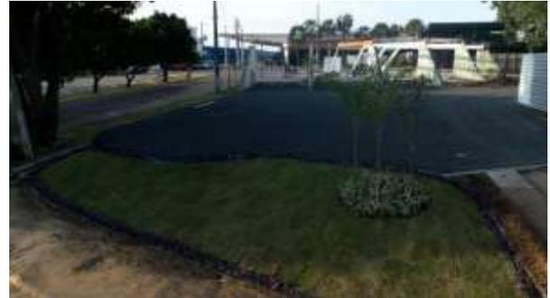
Figura 34: Nivelamento do solo, aterro com piçarra, areia vegetal e finalização com brita na Central de Eventos.
