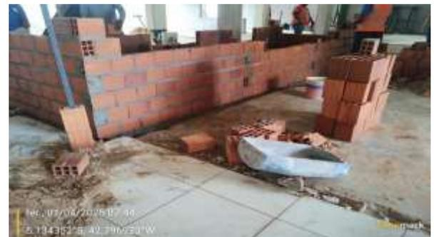
*Figura 66: Construção de paredes de alvenaria em bloco cerâmico nas fachadas sul, oeste, norte e nas vedações internas da ADM19-ROX.*
