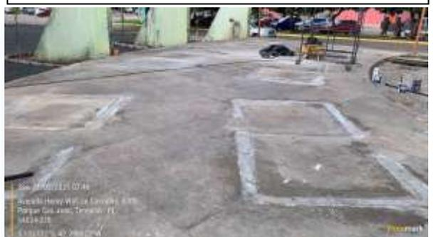
Figura 32: Demolição de módulos de alvenaria existentes no Galpão do ANP16-LIL.
