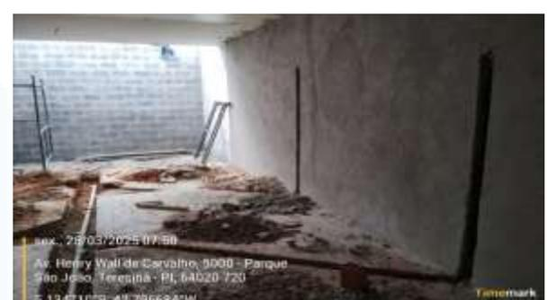
Figura 62: Demolição de piso para instalação de drenos de ar-condicionado e instalações hidrossanitárias dos banheiros da ADM19-ROX.
