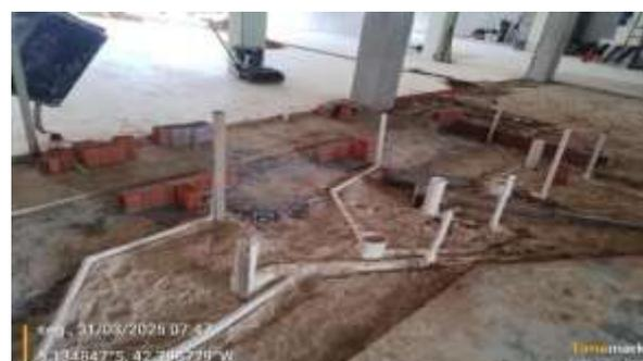
*Figura 78: Execução de instalações hidrossanitárias dos banheiros da ADM19-ROX.*
