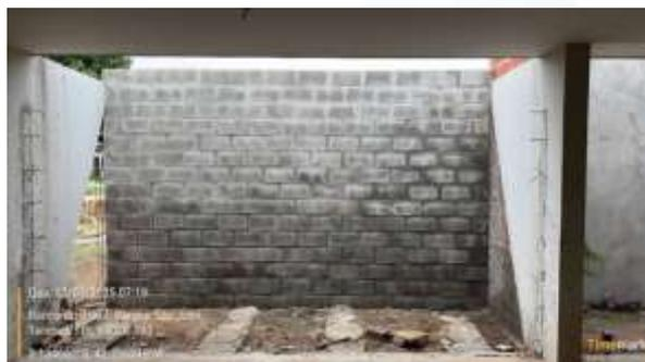
*Figura 70: Construção de paredes de alvenaria em bloco de concreto estrutural na fachada sul e nas vedações internas da ADM19-ROX.*
