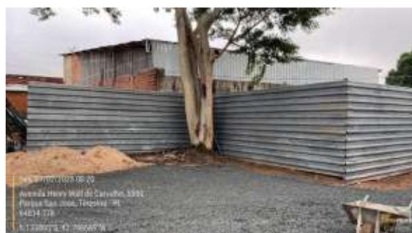
Figura 46: Execução de tapumes metálicos para demarcação de área da Metalúrgica.
