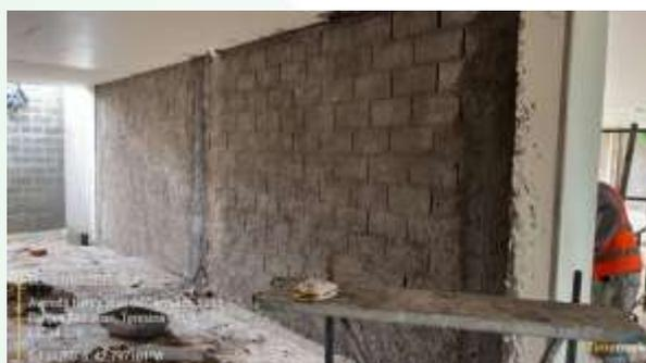
*Figura 71: Construção de paredes de alvenaria em bloco de concreto estrutural na fachada sul e nas vedações internas da ADM19-ROX.*
