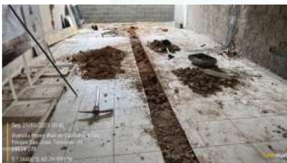
Figura 61: Demolição de piso para instalação de drenos de ar-condicionado e instalações hidrossanitárias dos banheiros da ADM19-ROX.
