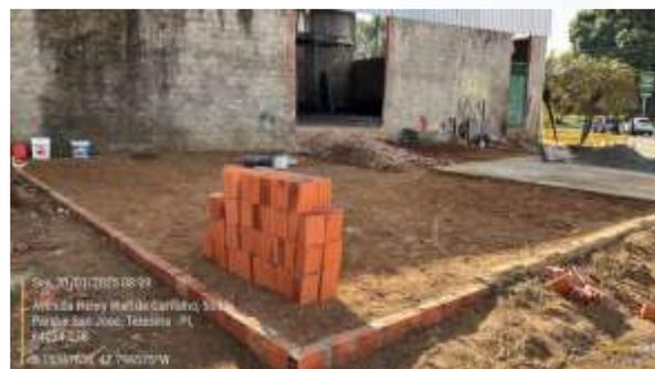
Figura 44: Execução de alvenaria de assentamento e preparação de solo para piso na área externa da Metalúrgica.
