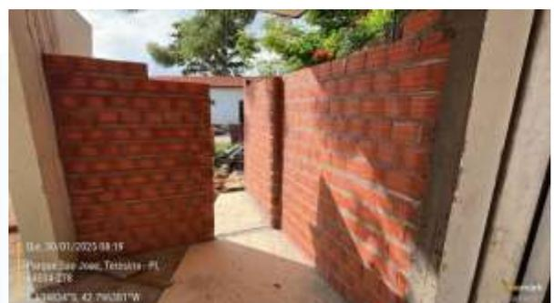
*Figura 68: Construção de paredes de alvenaria em bloco cerâmico nas fachadas sul, oeste, norte e nas vedações internas da ADM19-ROX.*
