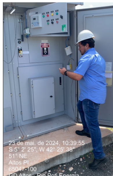
Figura 10 - Equipe da GeraWatt Energia realizando a avaliação das conexões da cabine primária.
