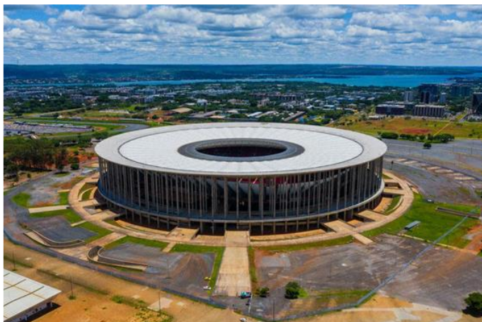
Figura 33: Estádio Mané Garrincha
