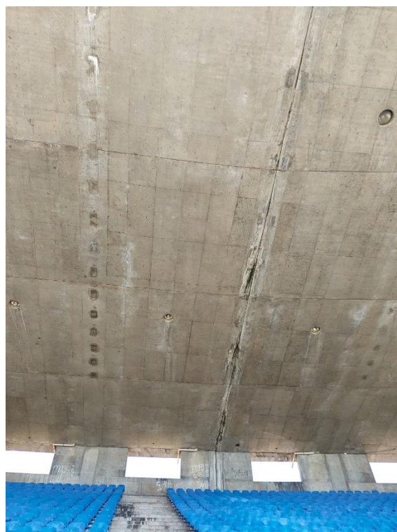
Figura 28 – Detalhe da cobertura arquibancada e junta de dilatação
