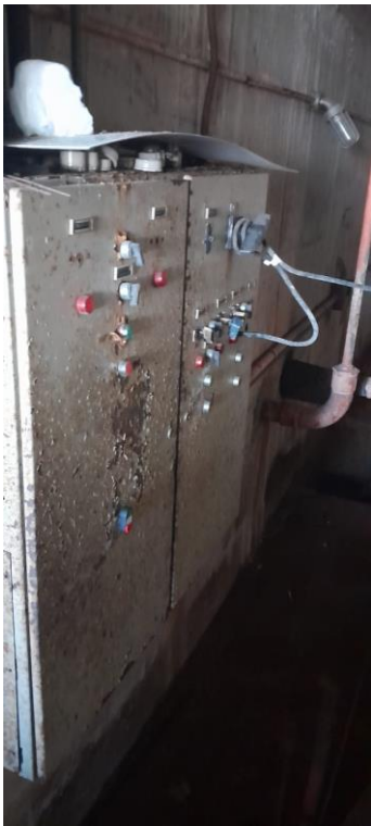
Figura 44 – Painel da casa de bombas
