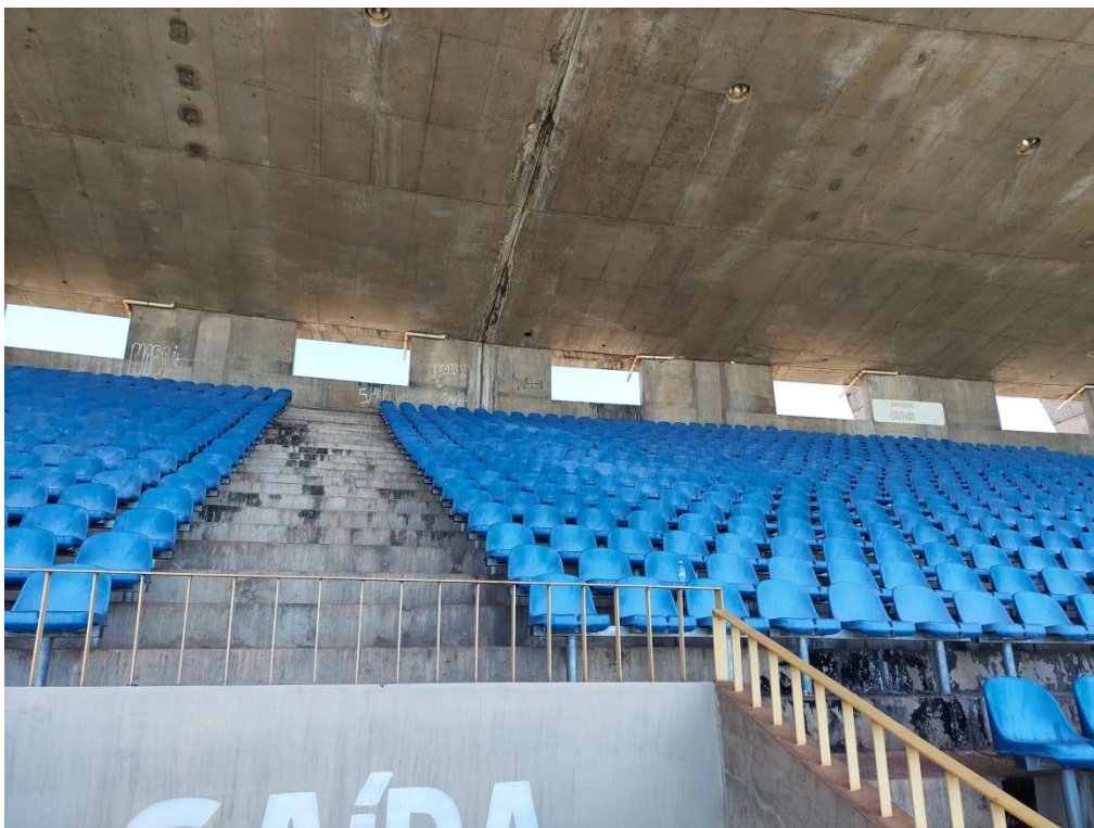
Figura 17 – Captação de água pluvial da cobertura sem devido encaminhamento até a GAP
