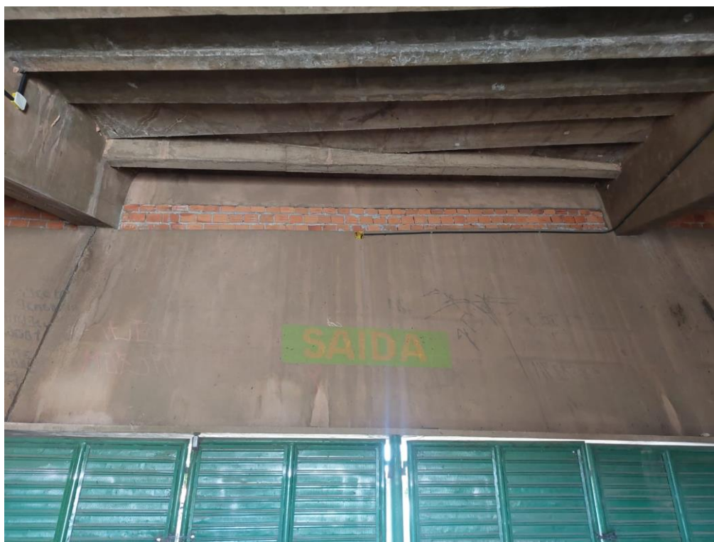
Figura 19 – Fechamento em alvenaria do vão de ventilação feito para evitar furtos
