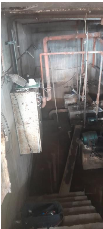
Figura 44 – Painel da casa de bombas
