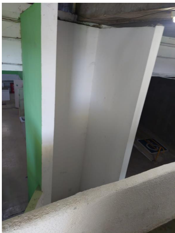
Figura 29 – Vão destinado a instalação de elevador do térreo para o mezanino
