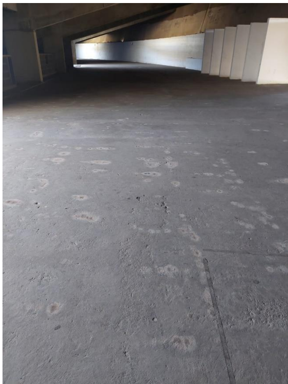
Figura 22 – Área de circulação
