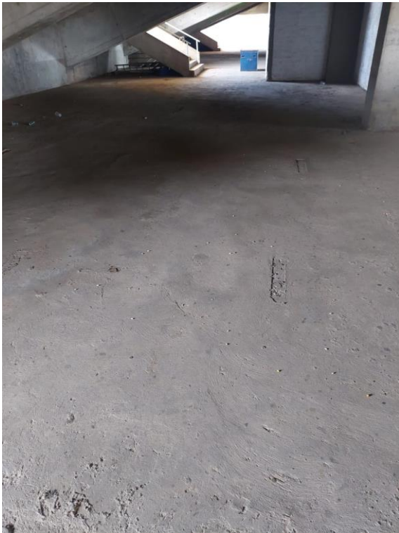
Figura 37 – Piso de concreto atual do acesso à arquibancada
