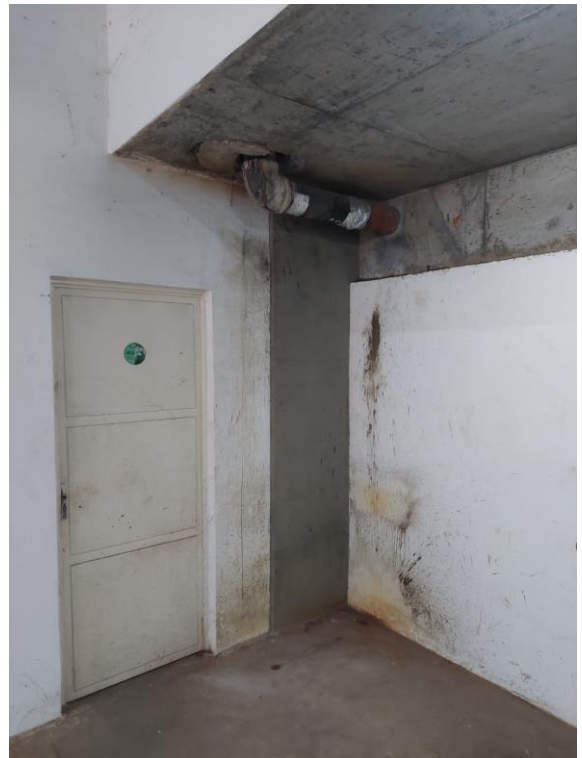
Figura 35 - Detalhe da laje com tubulação aparente
