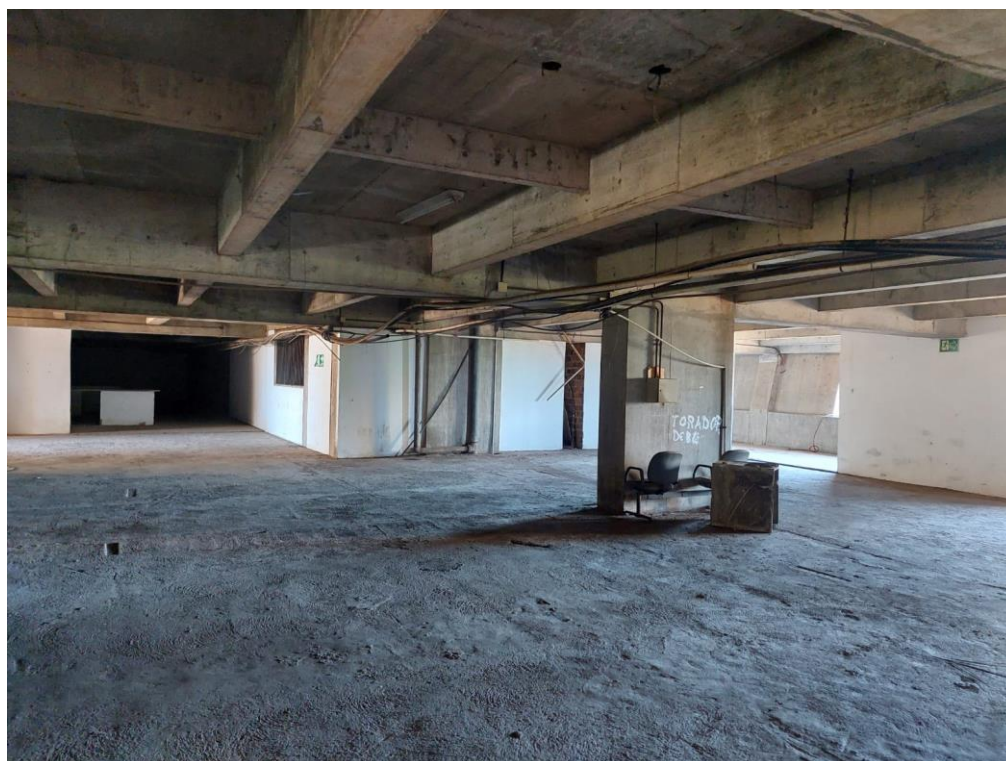
Figura 31 – Área de circulação
