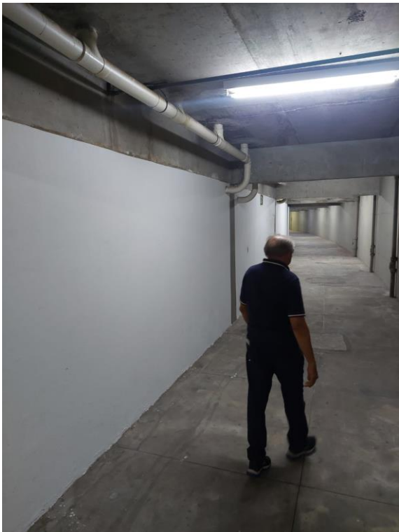
Figura 33 – Área de circulação
