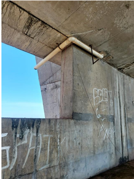
Figura 17 – Captação de água pluvial da cobertura sem devido encaminhamento até a GAP
