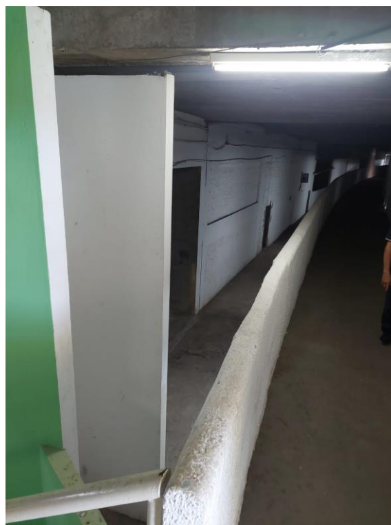
Figura 30 – Vão destinado a instalação de elevador do térreo para o mezanino
