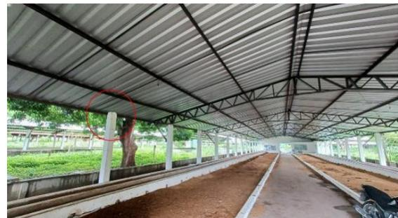
Figura 20 - Alguns pavilhões tiveram suas vigas treliçadas (metálicas) removidas
