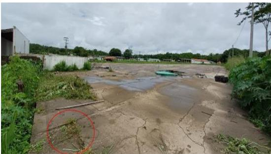
Figura 17 - Deslocamento do piso e fissuras oriundas das raízes das vegetações
