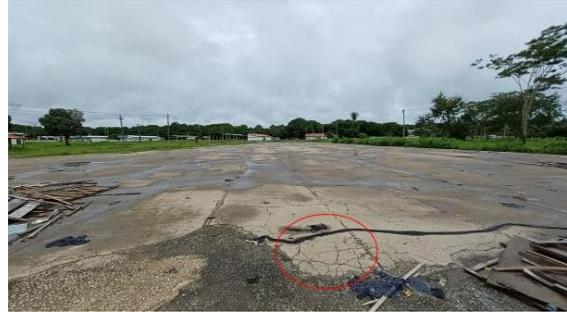
Figura 16 - Piso de concreto com alta retração
