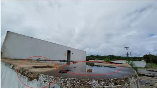
Figura 15 - Palco de Eventos possui deslocamento de concreto, fissuras e oxidação (palco sem caimento para o devido escoamento de água, resultando em seus intemperismos)
