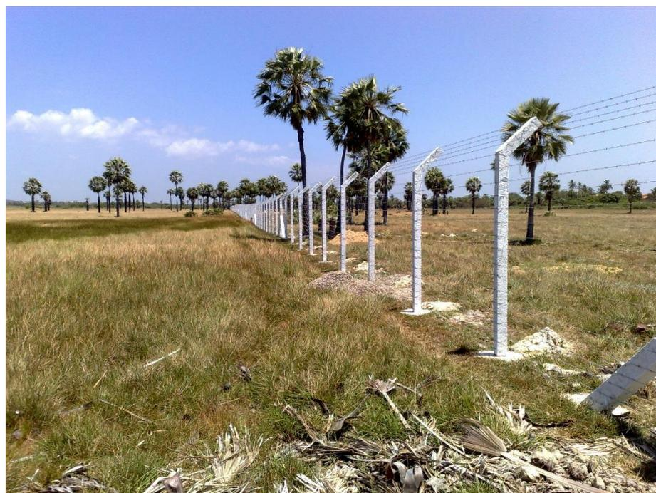
**Figura 5. Cerca com estacas de concreto**
