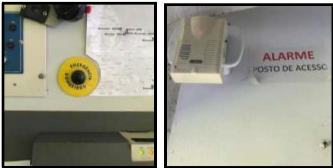
**Figura 47. Sistema de alarme manual de acionamento dos bombeiros**
