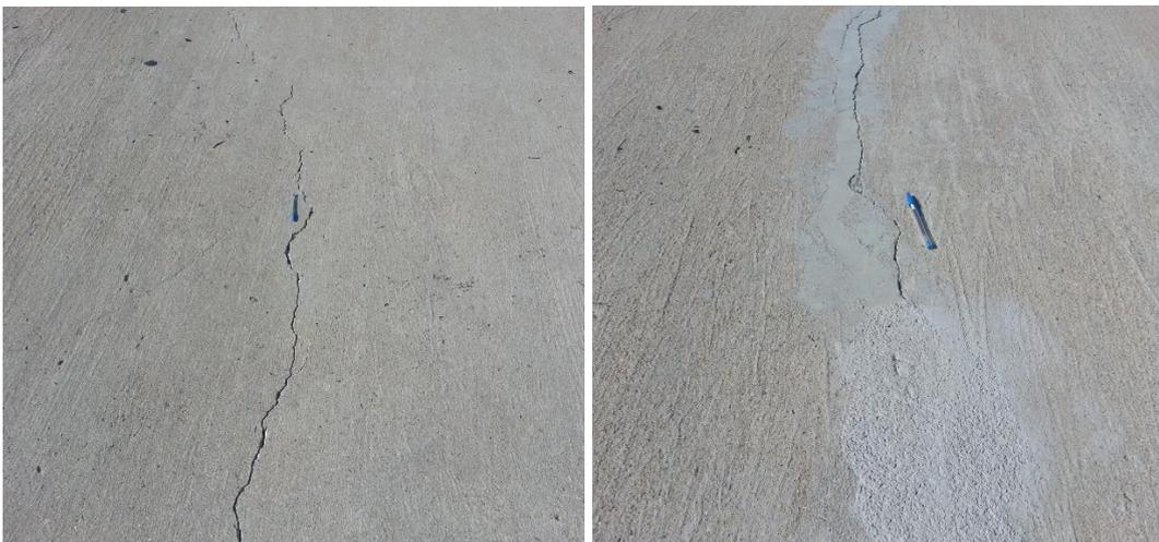
**Figura 15. Fissuras e trincas no pátio de estacionamento**
