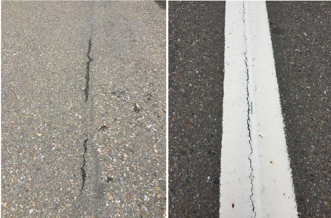
**Figura 10. Fissuras observadas na PPD**
