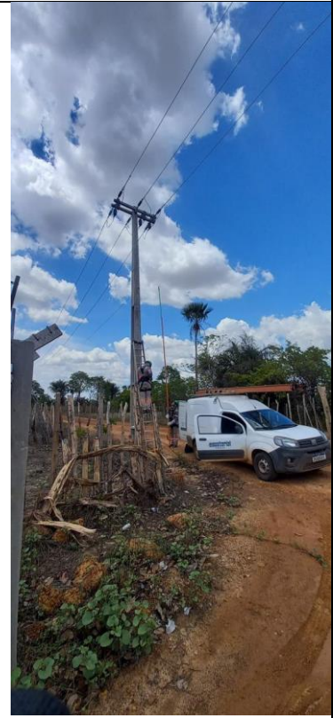
3. Realização de troca de TP
