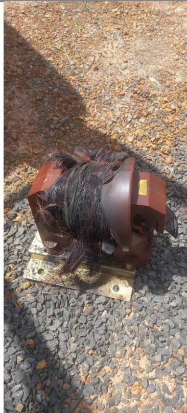
3. Realização de troca de TP
