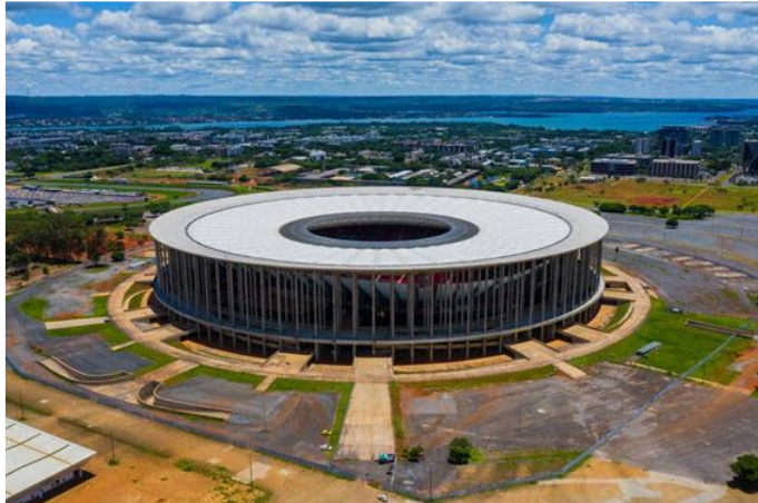
Figura 33: Estádio Mané Garrincha
