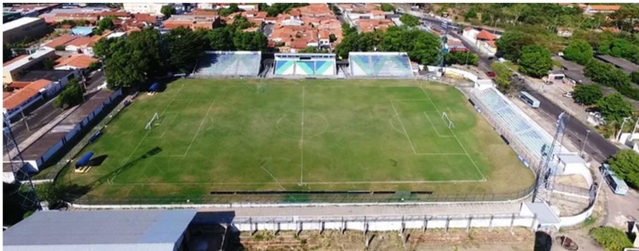
Figura 6: Estádio Lindolfo Monteiro
