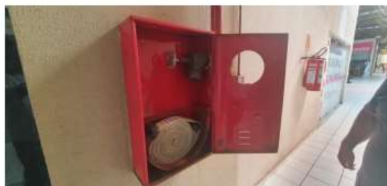
Foto 44 - Área de apoio
