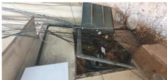
Foto 43 - Área de apoio
