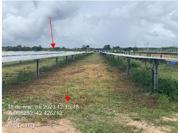
Figura 11 - No horário de 12:15 é possível observar os módulos em uma posição horizontal.
