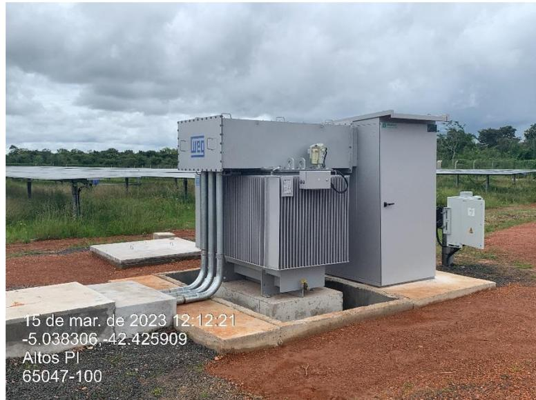
*Figura 8 - Skid com transformador a óleo.*
