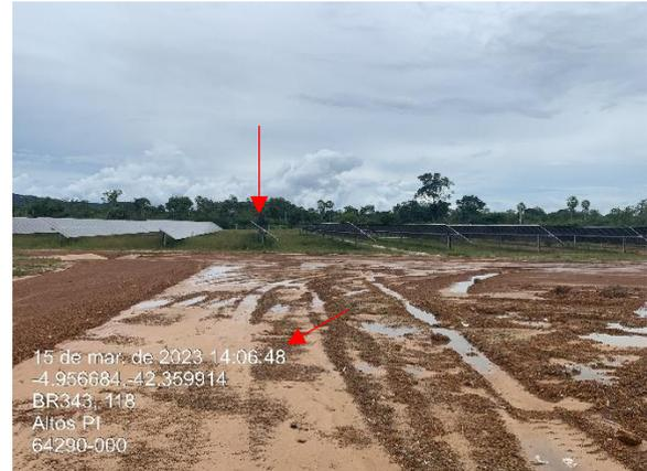
Figura 12 - No horário 14:06 é possível observar uma angulação no posicionamento dos módulos.
