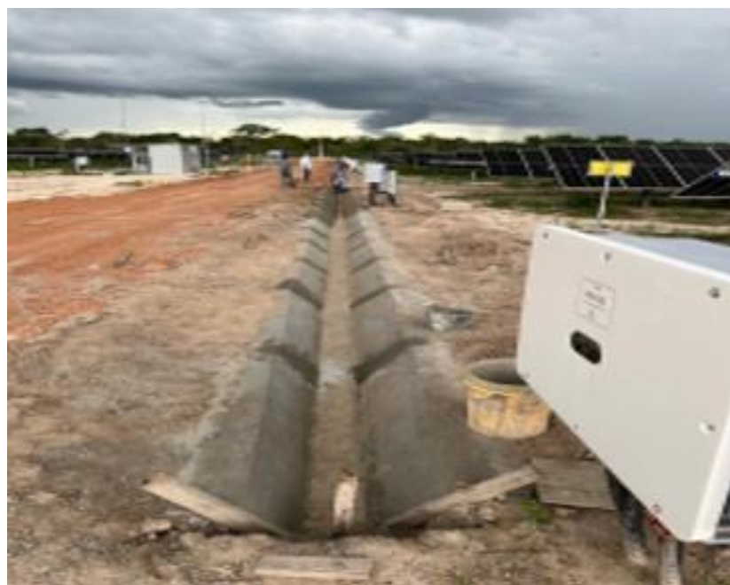
Figura 4 – Limpeza na vala de drenagem.
