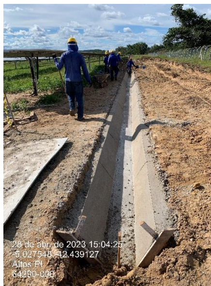
Figura 13 – Equipe técnica finalizando a vala de drenagem.
