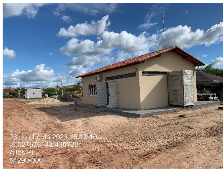
Figura 14 - Edificação de O&M da GD Nova Longá concluída.
