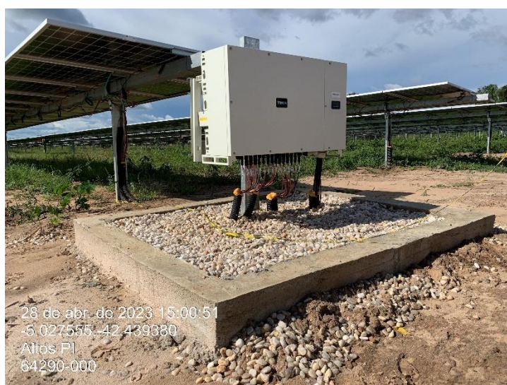
Figura 8 – Acabamento final da instalação dos inversores. A imagem a esquerda foi registrada em março, e a imagem a direita foi registrada em abril.
