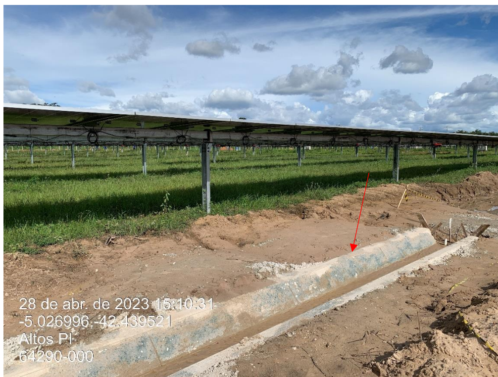
Figura 9 – Vegetação sob controle. Valas de drenagem na etapa conclusão (seta vermelha).
