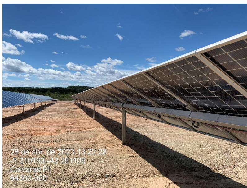
Figura 16 - Todos os módulos fixados e a vegetação completamente controlada.
