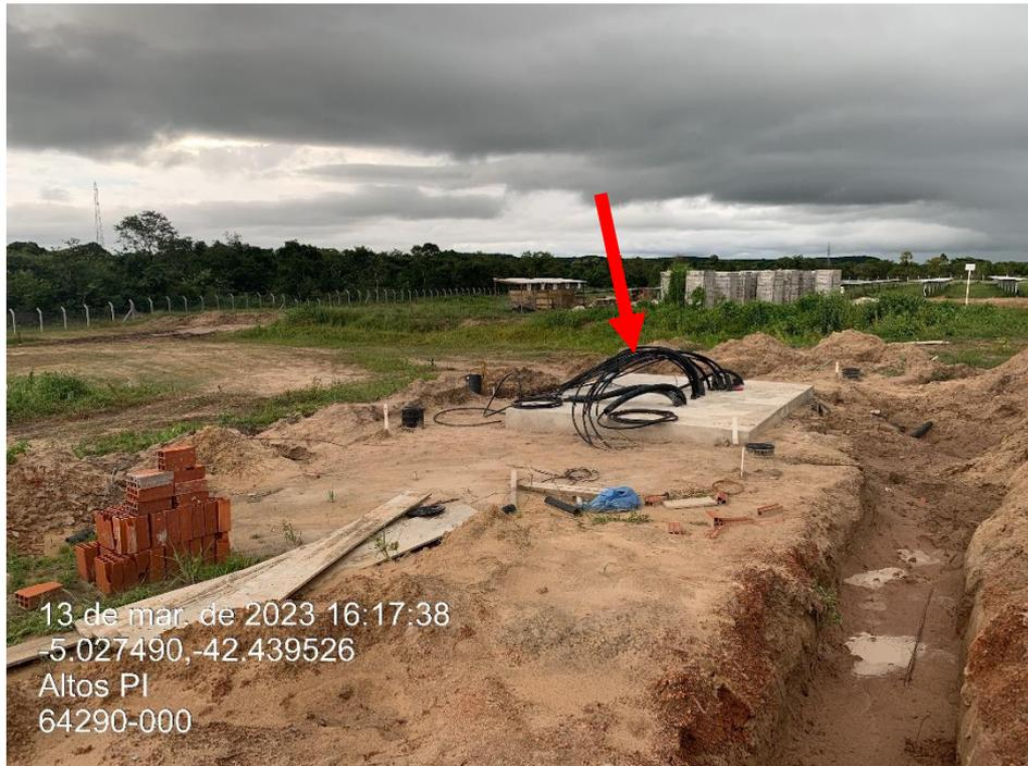
Figura 12 - Vala de passagem do eletroduto com mais de 70 cm de altura.
