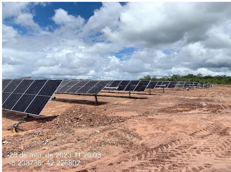
Figura 27 - Sistema do tracker. A placa menor (seta vermelha) é utilizada para alimentar o motor que rotaciona o eixo da estrutura.
