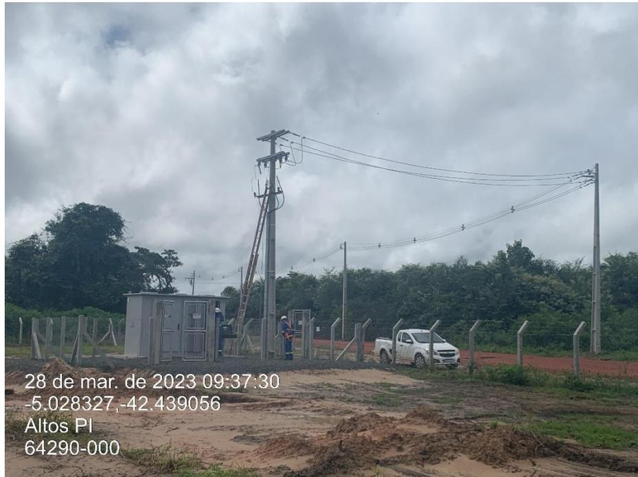
Figura 19 - Realização de testes a frio na Cabine Primária.
