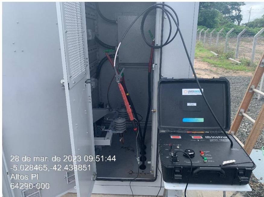
*Figura 20 - Equipe técnica finalizando a montagem do skid de transformação. O skid utiliza transformador a seco. Em comparação a visita realizada no dia 13 de março, esse equipamento está montado na base registrada na figura 11 deste relatório.*
