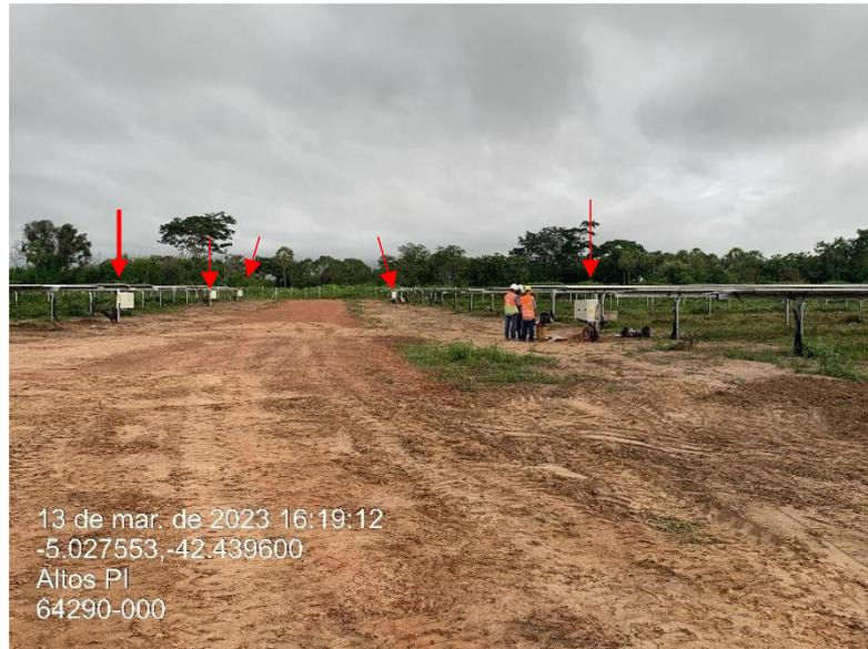
Figura 14 - Cobertura das valas do cabeamento CC concluídas.
