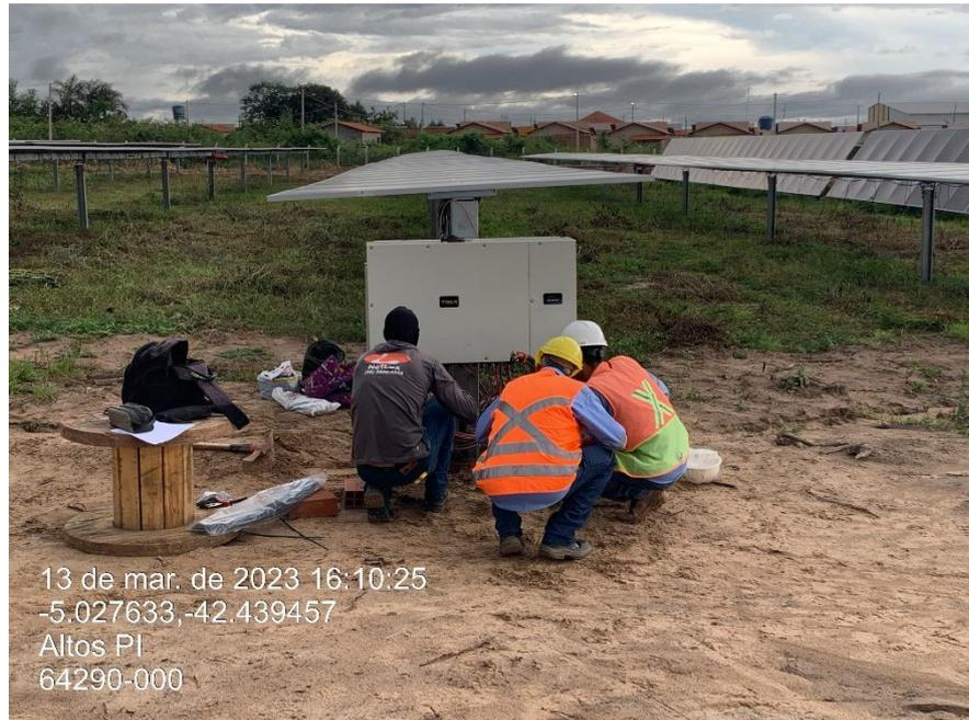
*Figura 8 – Equipe técnica preparando as conexões elétricas e realizando acabamento nos cabos e eletrodutos.*
