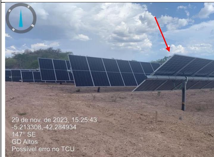
RF03\_37: A string indicada pela seta vermelha apresentava algum erro no TCU, que é o equipamento responsável pelo controle do tracker, assim é possível observar que a fileira está em uma orientação diferente das demais. A SPE informou que solicitou o reparo do equipamento junto ao fabricante.
