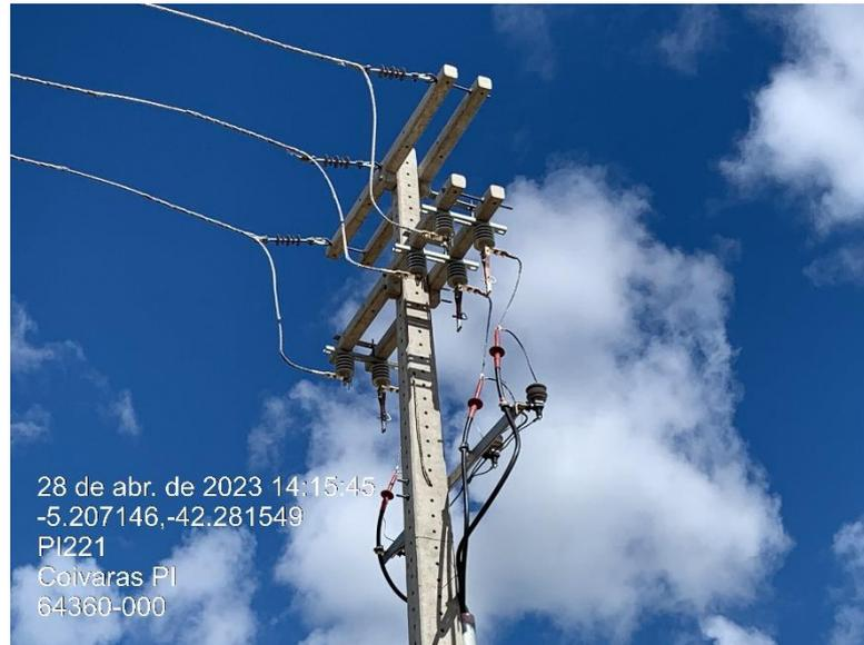
*Figura 6 - Ponto de conexão concluído, com o poste N1/N3 da Equatorial PI instalado, bem como a rede de distribuição que irá conectar a usina com a subestação da distribuidora (seta vermelha).*
