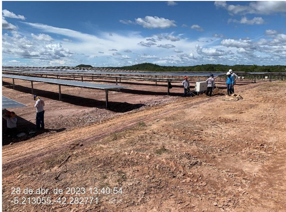
Figura 12 – Módulos fotovoltaicos fixados e em posição de defesa, reduzindo o impacto do vento nas estruturas protegidas.
