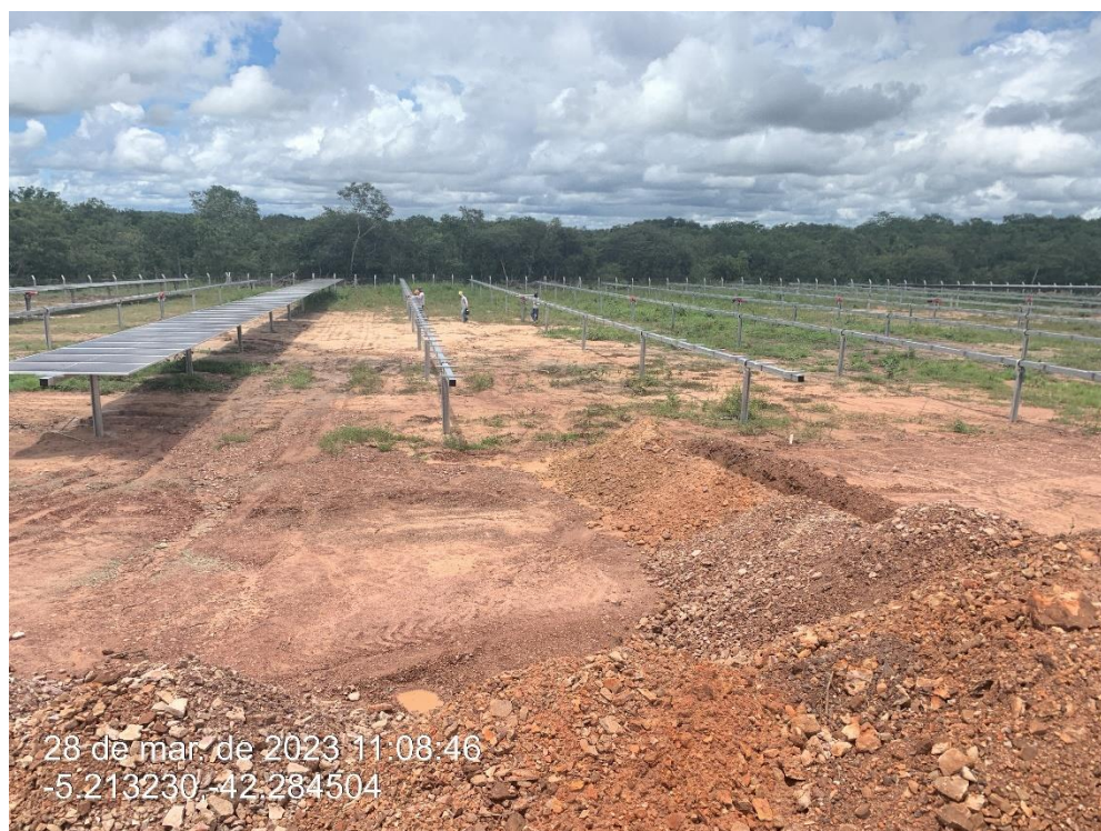
Figura 15 - Equipe construtiva conferindo o nível da estrutura para realizar a fixação dos módulos.
