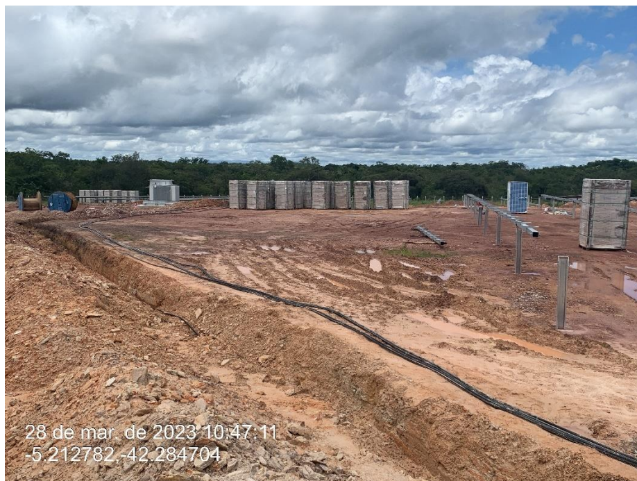
Figura 19 - Mobilização dos módulos e cabeamento. Fixação das estruturas.
