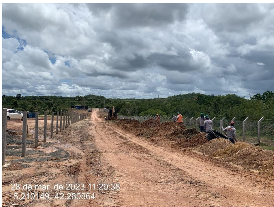
Figura 9 - Estrada de acesso.
