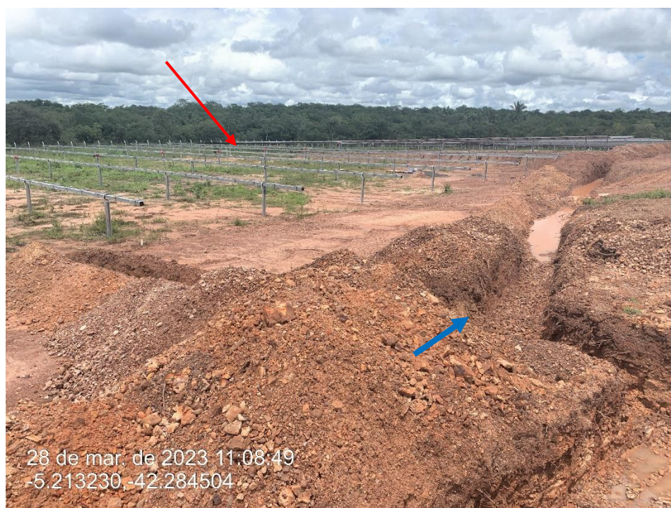
Figura 13 - No ultimo platô fotovoltaico as estruturas de fixação (setas vermelhas) e as valas para a passagem do cabeamento CC (seta azul) foram concluídas.
