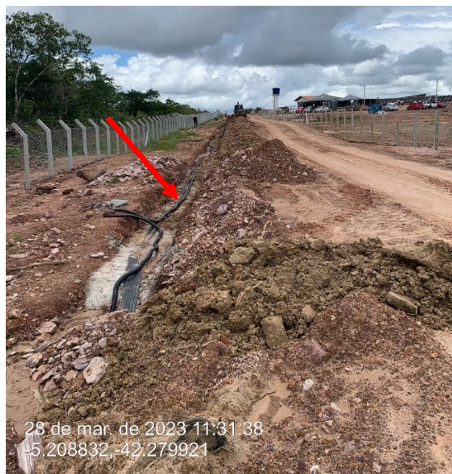
Figura 6 - Finalização da vala de passagem dos cabos AC, que conectam a Cabine Primário aos Skids.
