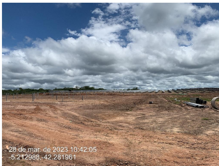
Figura 24 - Fixação das últimas estacas.
