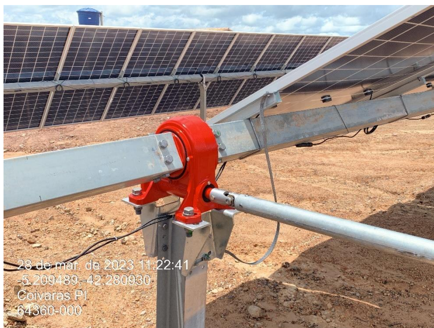
Figura 11 - Motor de rotação do tracker da marca Solplanet.
