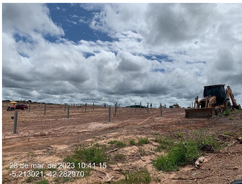
Figura 23 - Fixação das últimas estacas.
