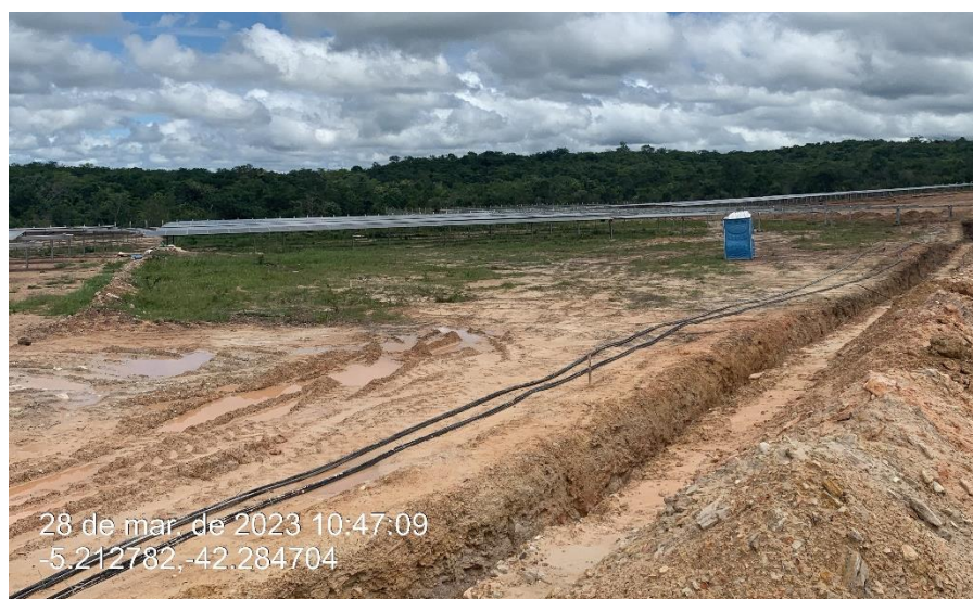
Figura 20 - Passagem de cabeamento.
