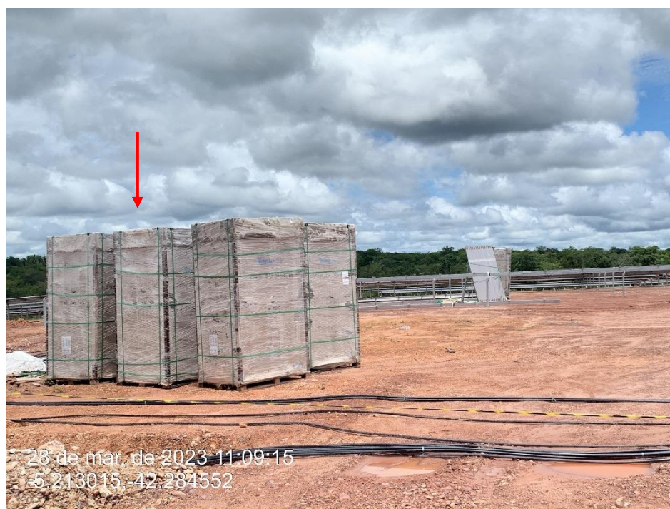
Figura 12 - Mobilização dos módulos para a fixação. As caixas indicadas na seta vermelha contém os módulos.
