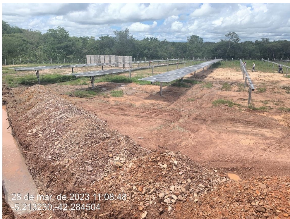
Figura 14 - Equipe construtiva conferindo o nível da estrutura para realizar a fixação dos módulos.
