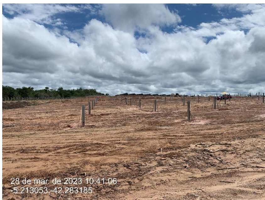
Figura 22 - Fixação das últimas bases de estrutura. Em algumas estacas foi necessário a realização do processo de concretagem, visto que as brocas de perfuração encontraram estruturas rochosas abaixo da terra.
