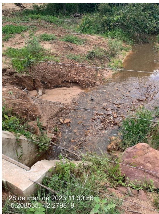
Figura 8 - Entrada do corredor de água de um riacho que corta a parte frontal do imóvel. Foram adotada as técnicas construtivas para emitir a vazão correta.
