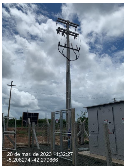
Figura 4 - Ponto de conexão concluído.
