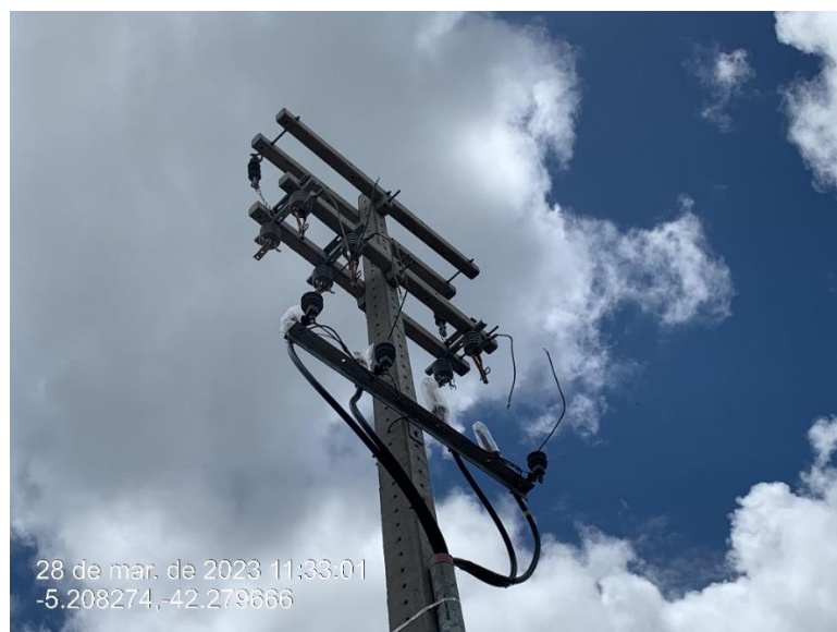
Figura 3 - Pontos de conexão fria concluídos.
