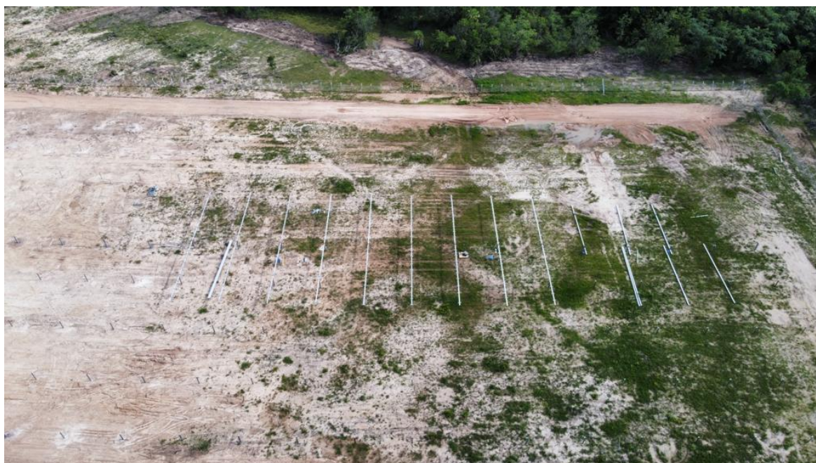
Figura 7 - Imagem aérea da fixação das estruturas da GD Altos
