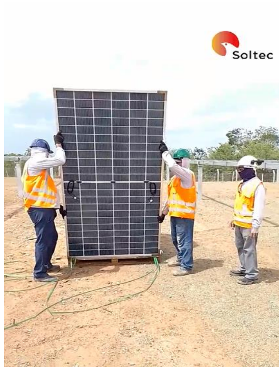
Figura 12 - Montagem dos módulos fotovoltaicos
