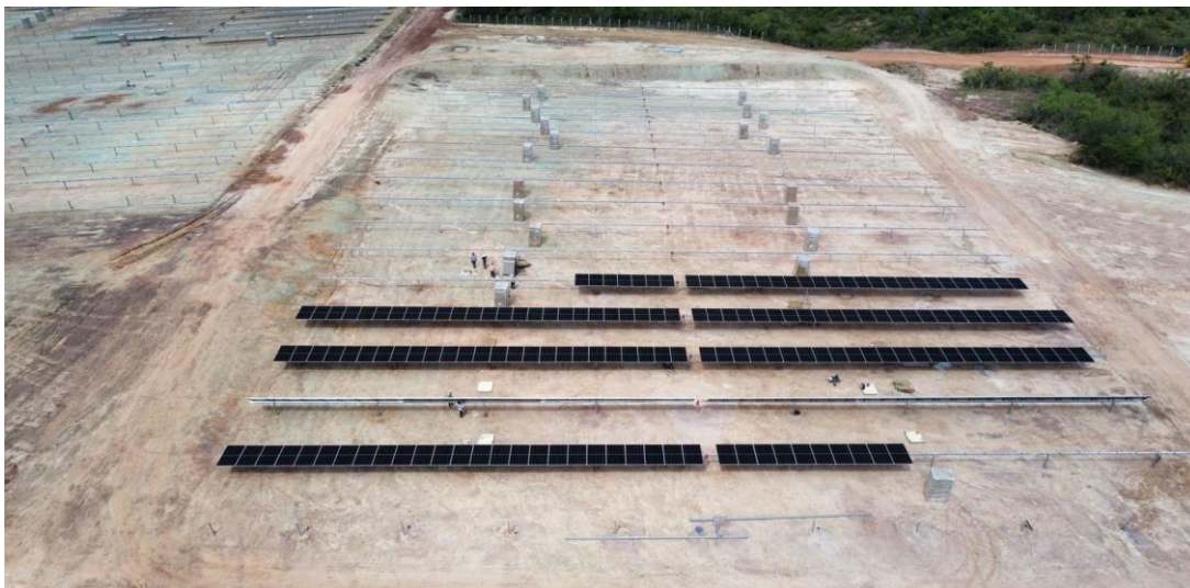
Figura 11 - Montagem de estrutura dos módulos fotovoltaicos
