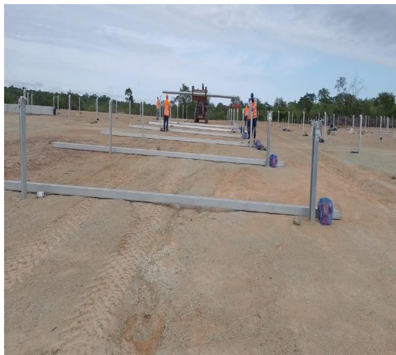
Figura 4 - Montagem Mecânica das estacas
