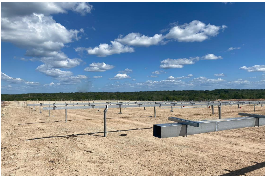
Figura 11 - Montagem de estrutura dos módulos fotovoltaicos
