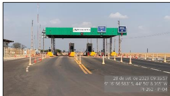
Figura 134 - Praça P4 em operação - SH-08
