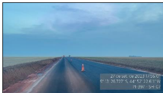
Figura 30 – TSD em execução – SH-07
