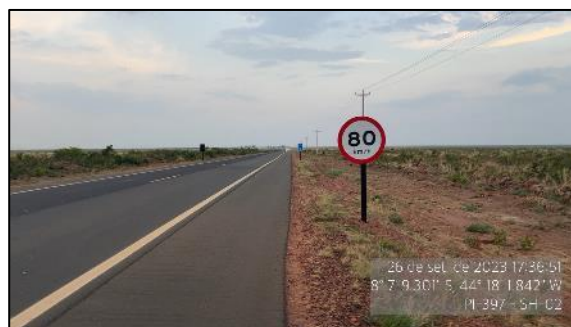
Figura 72 - Placa em bom estado - SH-02
