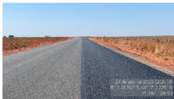
Figura 14 - TSD executado em agosto/23 - SH-03
