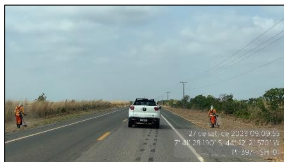
Figura 55 – Serviços de roçada em execução – SH-01
