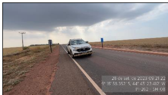
Figura 130 - Talude em bom estado - SH-08
