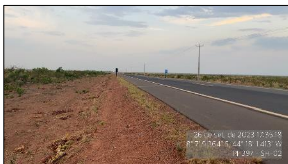
Figura 86 - Talude em bom estado - SH-02
