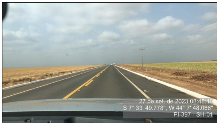
Figura 52 - Caiação do meio-fio – SH-01
