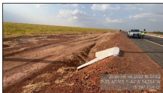
Figura 49 – Bueiro desobstruído no km 0.1 – SH-01
