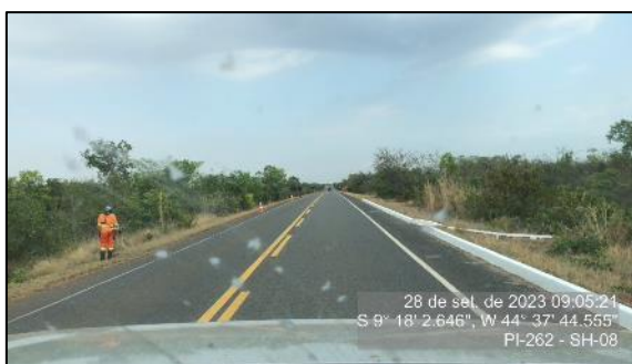
Figura 123 – Roçada de cerca a cerca em execução - SH-08
