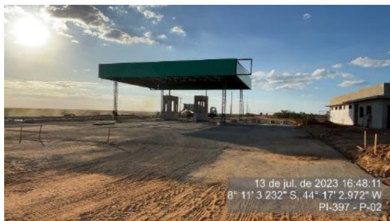
Figura 3 - Estado da obra da P2 - julho/23
