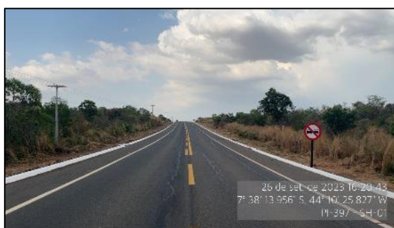
Figura 39 - condição geral do pavimento - SH-01
