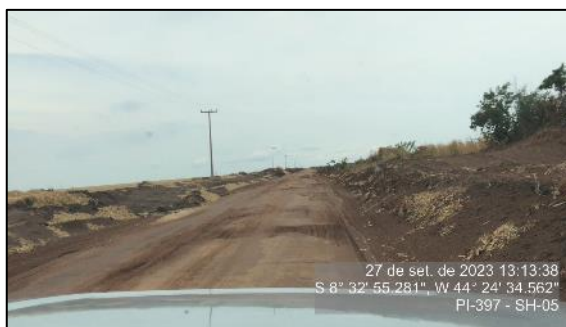
Figura 101 - Irregularidade no leito estradal - SH-05
