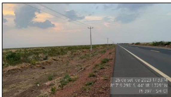
Figura 60 - Talude em bom estado - SH-01
