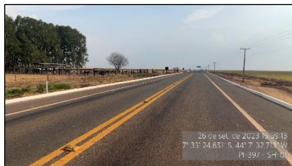
Figura 63 - Tachas refletivas em bom estado - SH-01
