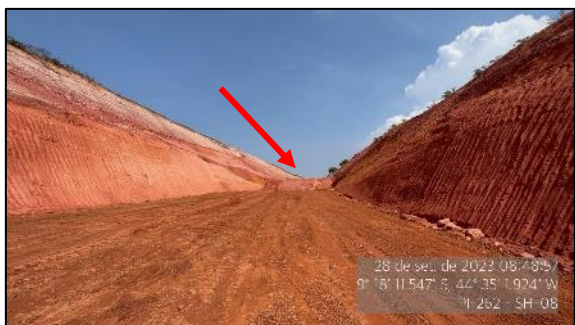
Figura 135 – Trecho no qual houve preparo para detonação – SH-08
