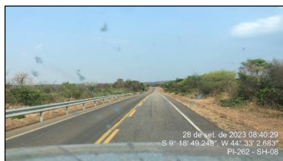
Figura 128 - Defensas laterais implantadas - SH-08
