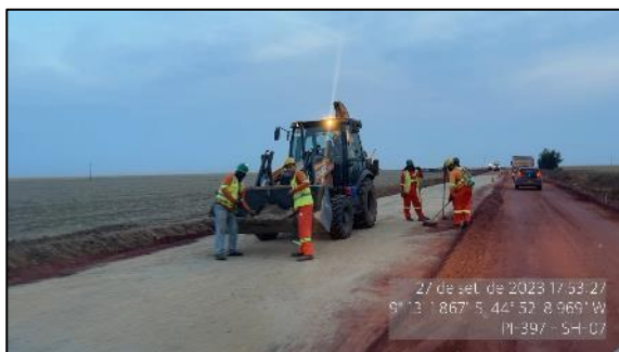
Figura 29 – TSD em execução – SH-07
