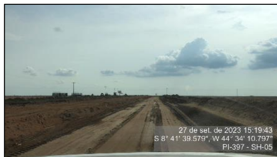
Figura 105 – Serviços de Terraplenagem da P3 - SH-05
