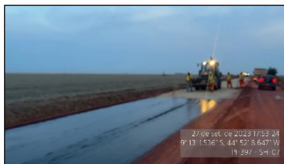
Figura 28 – TSD em execução – SH-07
