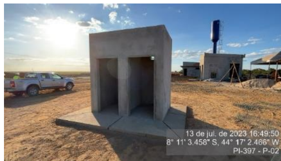
Figura 4 - Estado da obra da P2 - julho/23
