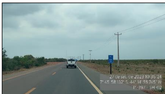
Figura 71 - Placa em bom estado - SH-02
