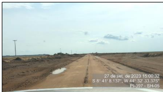
Figura 19 – Serviço de desmatamento executado nas proximidades da P3 – SH-05
