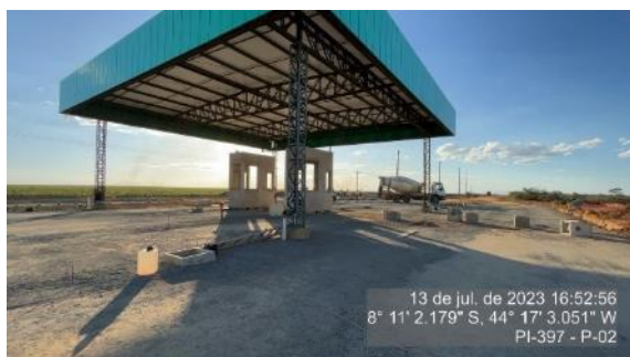
Figura 1 - Estado da obra da P2 - julho/23
