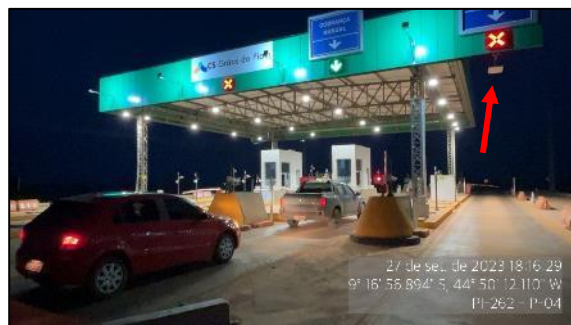
Figura 166 – Pista automática inoperante – P4
