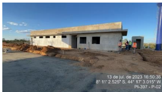
Figura 2 - Estado da obra da P2 - julho/23
