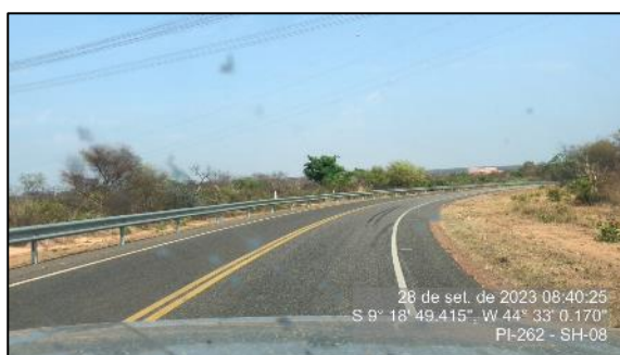
Figura 127 - Defensas laterais implantadas - SH-08
