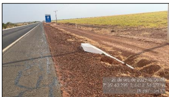
Figura 48 – Bueiro desobstruído no km 0.1 – SH-01
