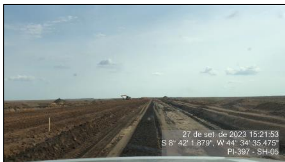
Figura 104 – Serviços de Terraplenagem da P3 - SH-05
