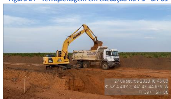
Figura 26 - Terraplenagem em execução - SH-06
