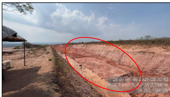
Figura 136 – Trecho no qual houve preparo para detonação – SH-08
