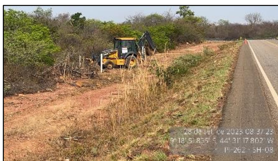
Figura 124 – Roçada de cerca a cerca em execução - SH-08
