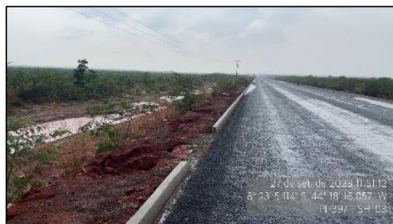
Figura 93 - Espaçamento para descida d'água - SH-03
