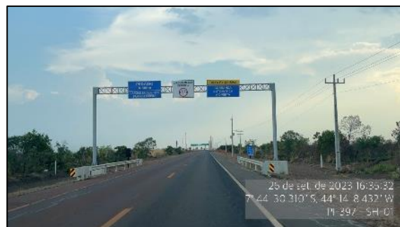
Figura 59 - Defesa lateral do pórtico da P1 - SH-01
