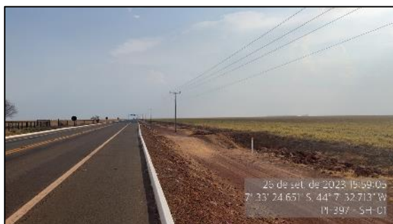
Figura 61 - Talude em bom estado - SH-01
