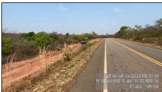
Figura 129 - Talude em bom estado - SH-08
