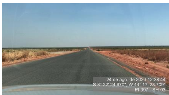
Figura 13 - TSD executado em agosto/23 - SH-03
