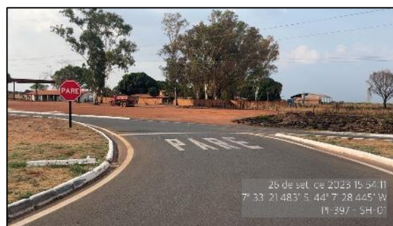
Figura 45 – Placa em bom estado - SH-01
