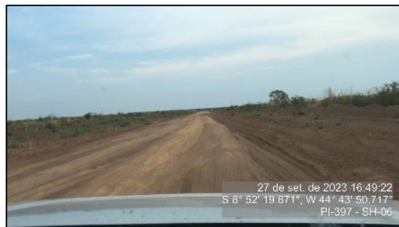
Figura 20 – Serviço de desmatamento executado – SH-06
