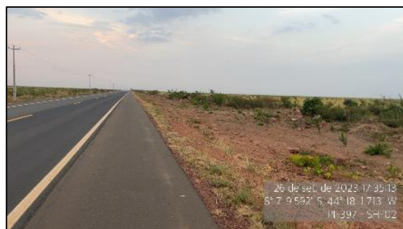
Figura 87 - Talude em bom estado - SH-02
