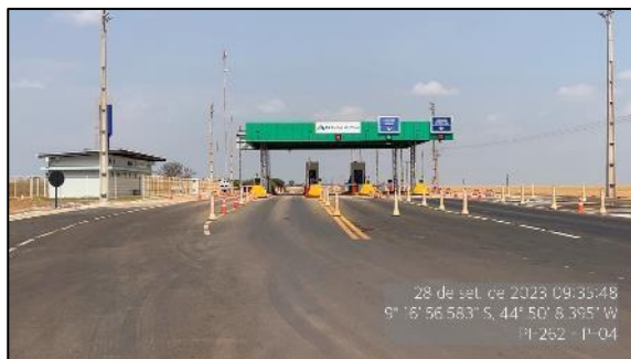
Figura 133 - Praça P4 em operação - SH-08
