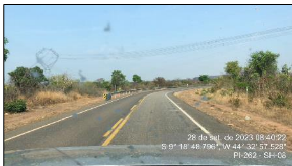
Figura 125 - Defensas laterais implantadas - SH-08
