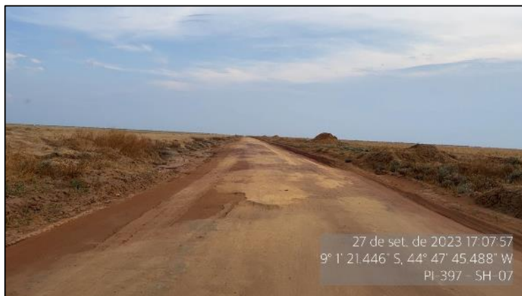
Figura 108 - Pista de rolamento em bom estado - SH-07
