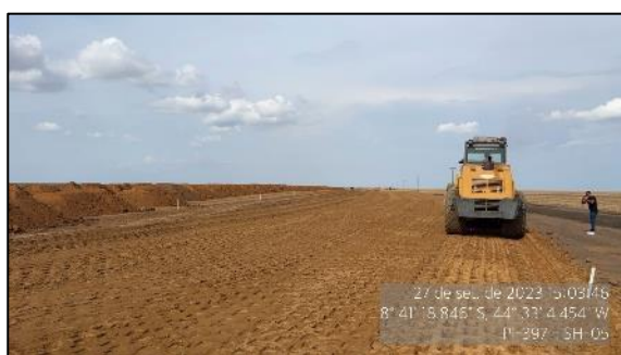
Figura 23 - Terraplenagem em execução - SH-05
