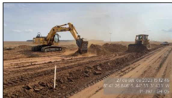
Figura 22 - Terraplenagem em execução - SH-05
