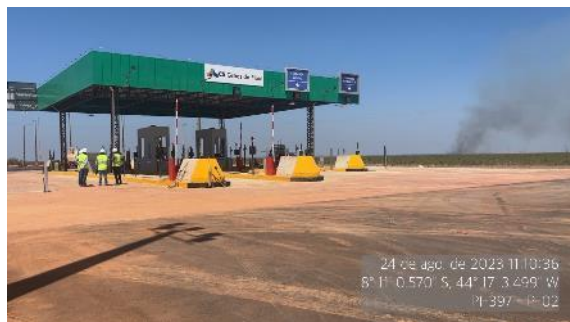
Figura 75 – Estado geral da P2 - SH-02 – ago/23
