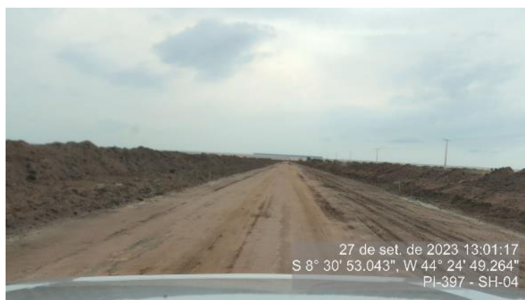
Figura 99 – Trecho em obra com serviço de limpeza executado - SH-04
