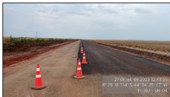
Figura 32 - TSD em execução - SH-04
