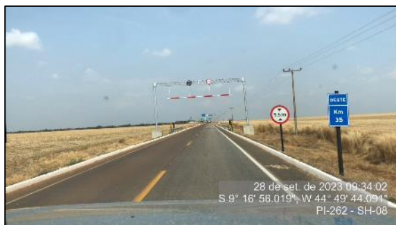
Figura 121 - Caiação executada - SH-08
