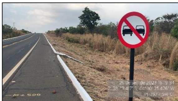
Figura 46 - Placa em bom estado – SH-01
