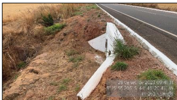
Figura 119 – Bueiro km 28 limpo e desobstruído - SH-08
