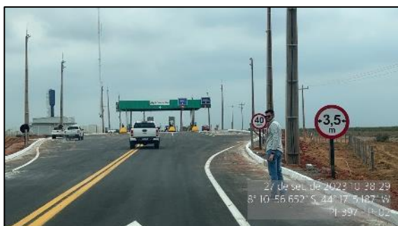
Figura 79 – Sinalização horizontal na P2 - SH-02
