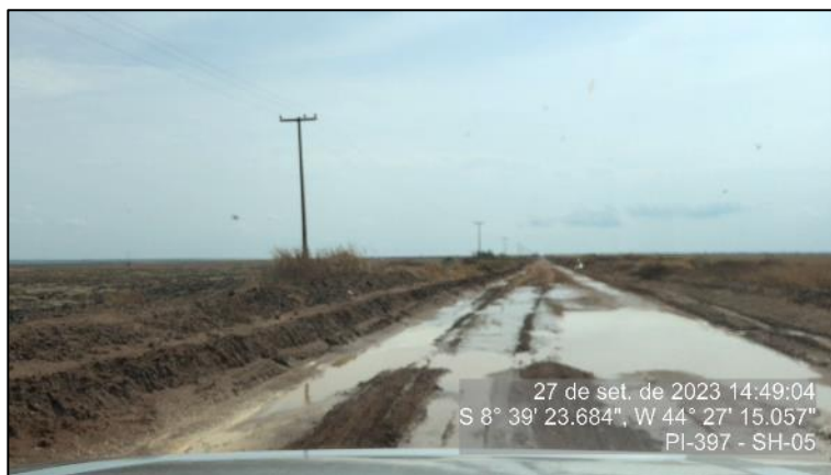
Figura 102 - Ponto com acúmulo de água - SH-05
