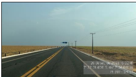
Figura 62 - Tachas refletivas em bom estado - SH-01
