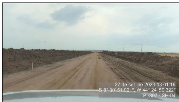
Figura 21 - Terraplenagem executada - SH-04
