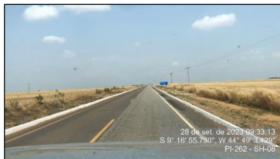
Figura 122 - Caiação executada - SH-08
