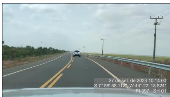
Figura 56 - Defesa lateral implantada - SH-01
