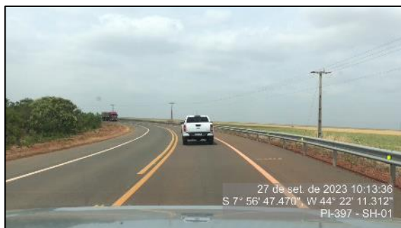
Figura 58 - Defesa lateral do pórtico implantada - SH-01
