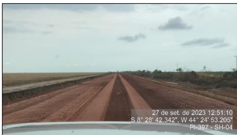
Figura 98 - Pista de rolamento em bom estado - SH-04
