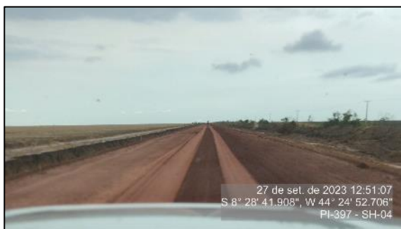
Figura 31 - Camada de base em execução - SH-04
