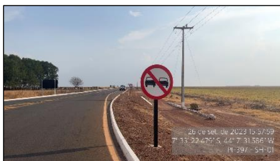
Figura 44 – Placa em bom estado - SH-01
