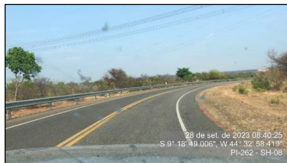
Figura 126 - Defensas laterais implantadas - SH-08
