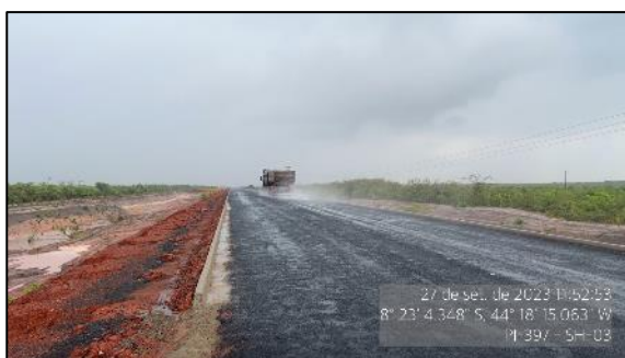
Figura 90 - Meio-fio implantado - SH-03
