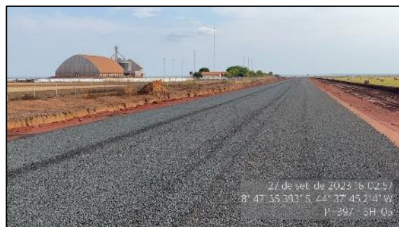
Figura 34 – TSD em execução - SH-05
