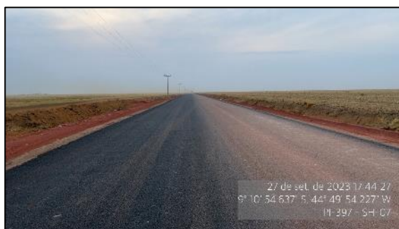
Figura 27 – TSD em execução – SH-07
