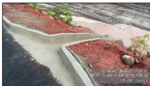
Figura 91 - Descida d'água implantada - SH-03
