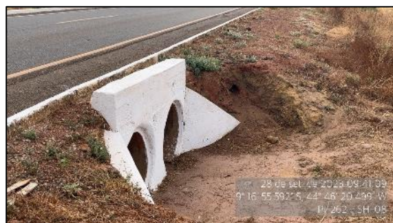
Figura 120 - Bueiro km 28 limpo e desobstruído - SH-08
