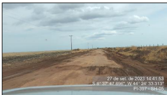
Figura 100 - Irregularidade no leito estradal - SH-05
