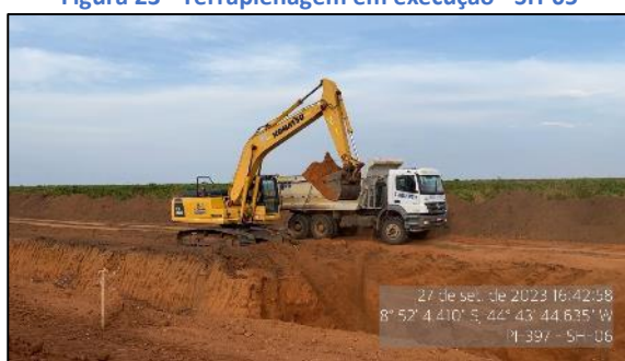
Figura 25 - Terraplenagem em execução - SH-06
