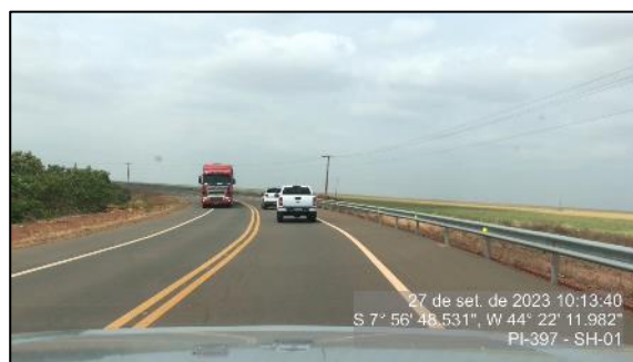
Figura 57 - Defesa lateral implantada - SH-01
