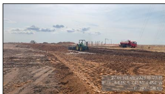
Figura 24 - Terraplenagem em execução na P3 - SH-05
