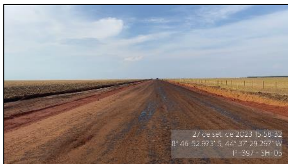
Figura 33 – Base executada - SH-05
