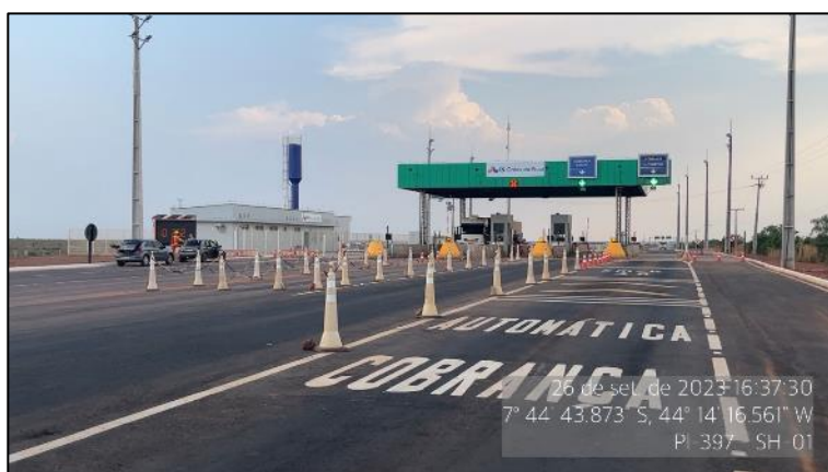
Figura 53 - Praça P01 em operação - SH-01
