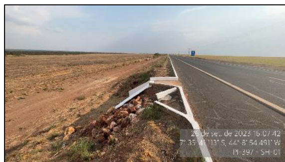
Figura 51 – Bueiro limpo implantado no km 5 – SH-01
