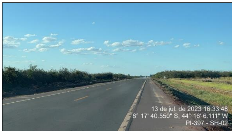
Figura 75 - Talude em bom estado - SH-02
