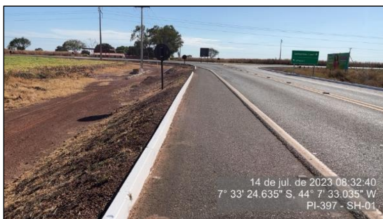
Figura 58 - Talude em bom estado - SH-01
