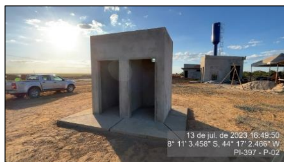
Figura 69 – Edificação de apoio da P2 - SH-02
