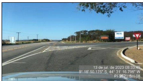
Figura 106 - Sinalização horizontal em bom estado - SH-08
