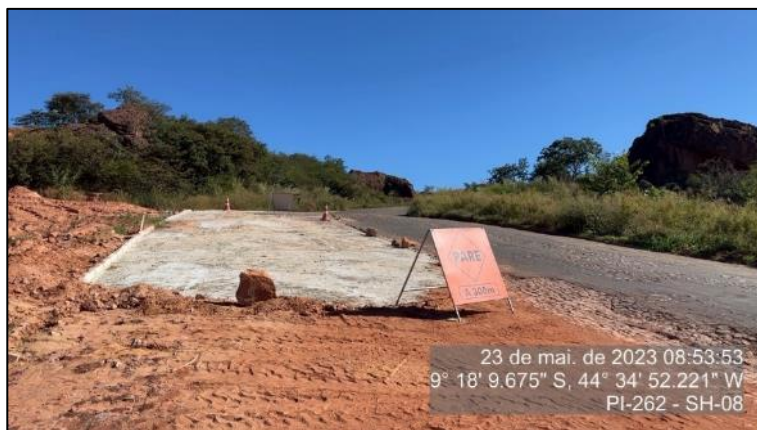
Figura 144 - Serviço de reparo do pavimento executado pela Concessionária - SH-08
