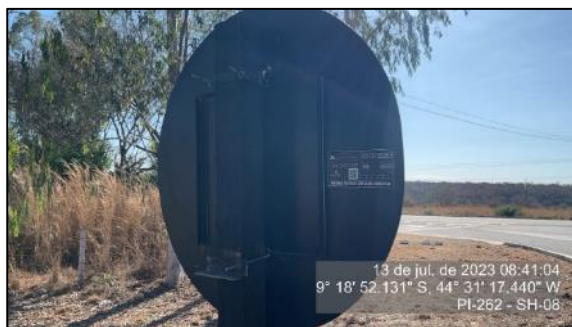
Figura 110 - Placa de regulamentação em bom estado - SH-08
