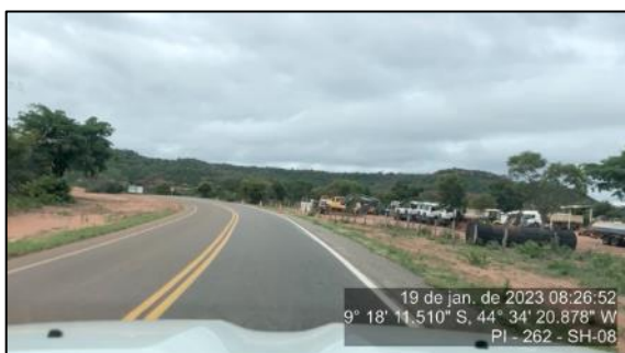
Figura 126 - Canteiro de obra da Serra do Quilombo - jan/23
