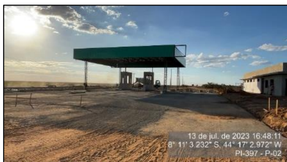
Figura 70 - Pavimento em implantação na P2 - SH-02
