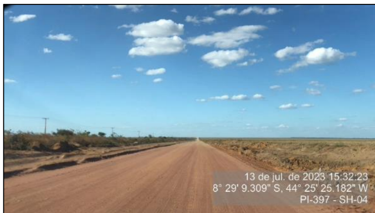
Figura 15 - Trecho com serviços de terraplenagem - SH-04
