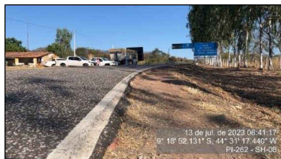
Figura 107 - Sinalização horizontal em bom estado - SH-08
