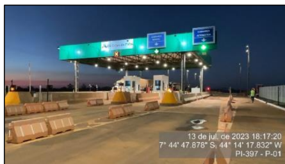
Figura 51 - Praça P1 em operação - SH-01
