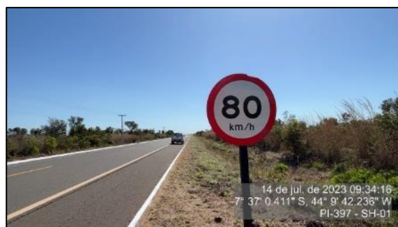
Figura 38 – Placa danificada – km 7,9 – SH-01
