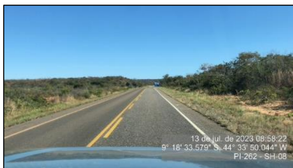
Figura 102 - Pavimento em bom estado - SH-08
