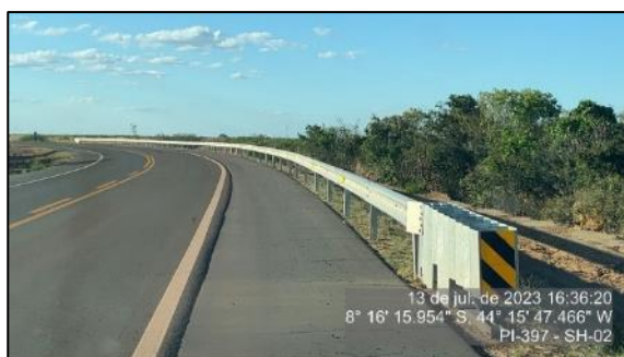
Figura 73 - Defesa lateral em bom estado - SH-02
