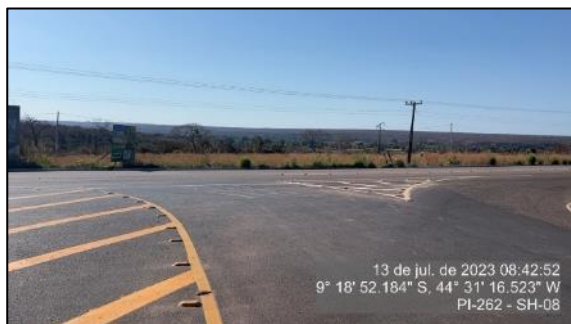
Figura 104 - Sinalização horizontal em bom estado - SH-08
