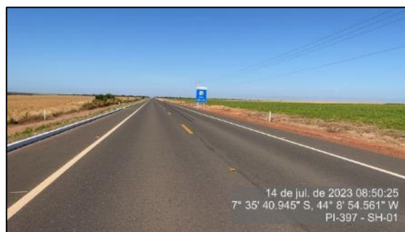
Figura 34 – Pavimento em bom estado – SH-01
