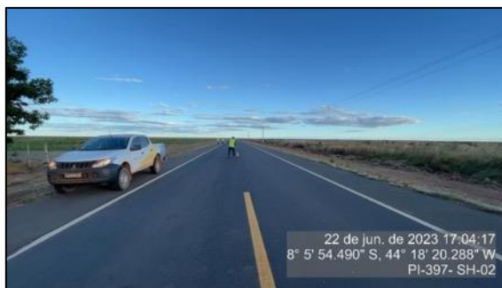
Figura 64 - Pintura da pista em bom estado - SH-02
