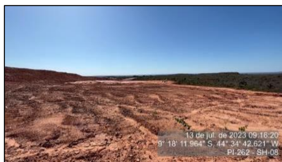
Figura 131 - Bota-fora localizado no lado esquerdo da rodovia, sentido crescente do S.R.E.
