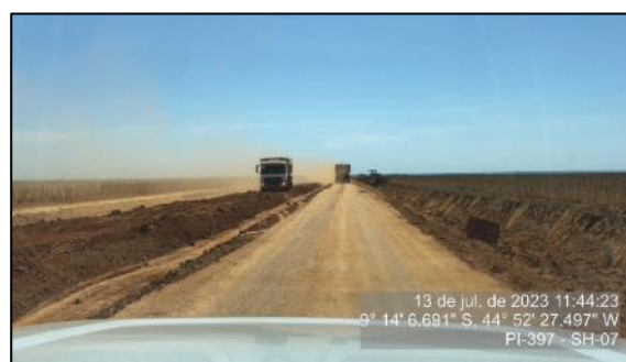
Figura 31 – Terraplenagem em execução – SH-07
