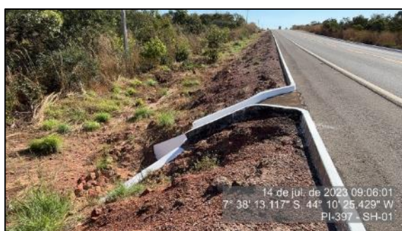
Figura 43 – Bueiro limpo implantado no km 10,5 – SH-01
