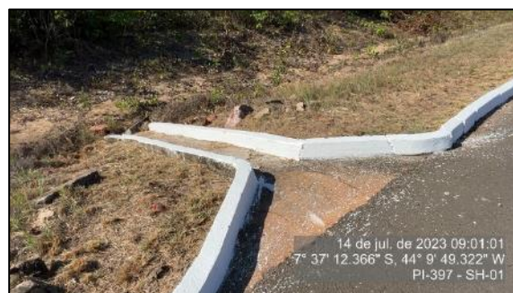
Figura 49 - Descida d'água reparada no km 8,3 – jul/23 - SH-01
