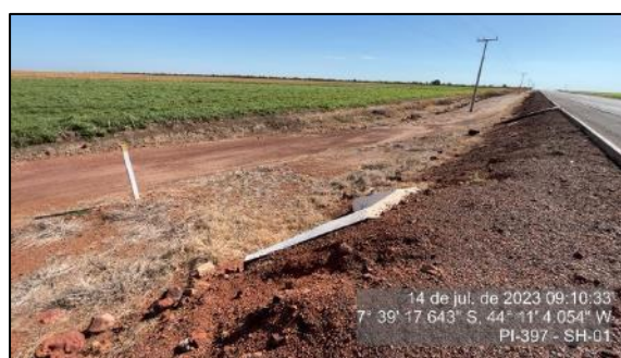
Figura 44 – Bueiro limpo implantado no km 12,8 – SH-01
