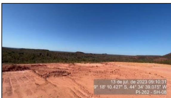
Figura 130 – Bota-fora localizado no lado esquerdo da rodovia, sentido crescente do S.R.E.
