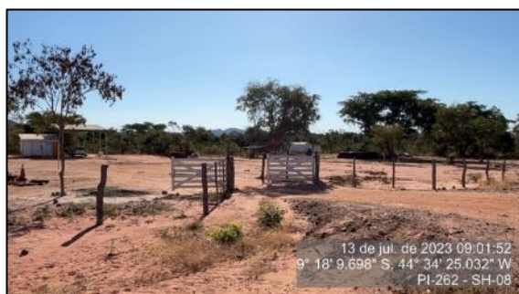
Figura 127 - Canteiro de obra da Serra do Quilombo - jun/23
