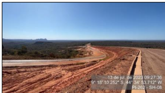
Figura 133 – Sarjeta e descida d'água
