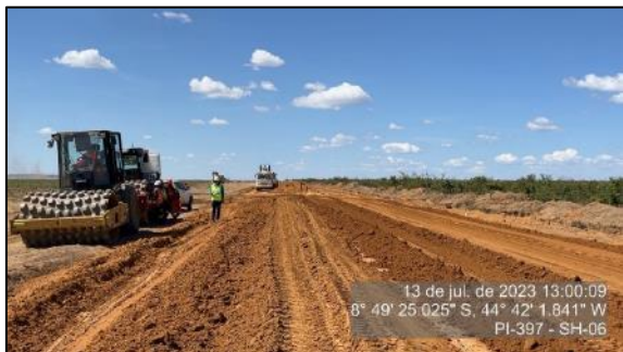
Figura 20 - Terraplenagem em execução - SH-06
