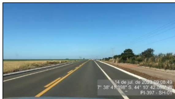
Figura 36 – Sinalização horizontal em bom estado – SH-01
