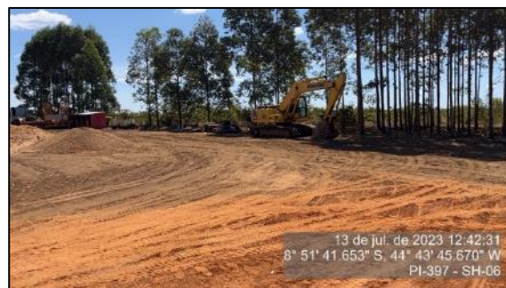
Figura 23 - Canteiro de obra - SH-06
