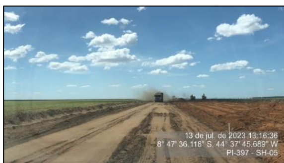
Figura 16 - Terraplenagem em execução - SH-05
