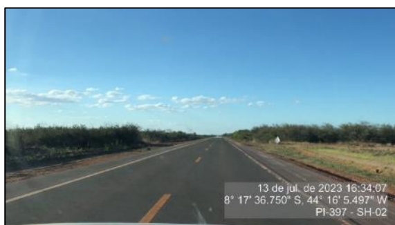
Figura 61 - Pavimento em bom estado - SH-02
