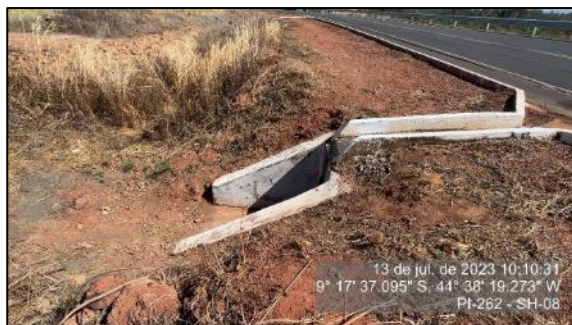
Figura 112 - Bueiro km 14 limpo e desobstruído - SH-08
