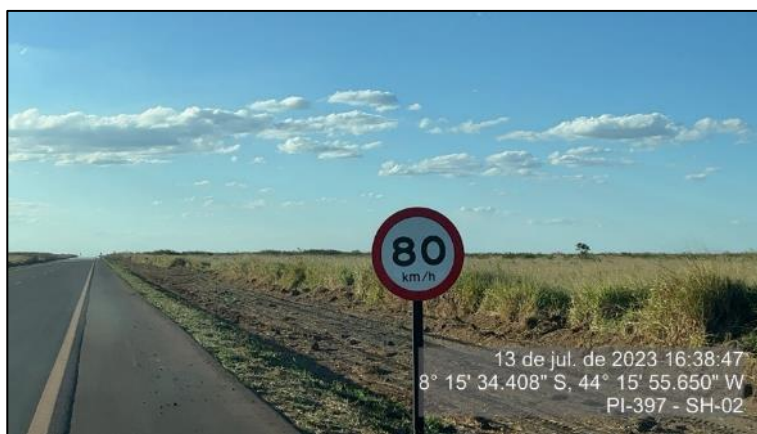
Figura 65 - Placa em bom estado - SH-02
