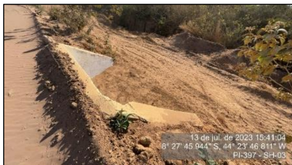
Figura 78 - Bueiro implantado no km 116 - SH-03
