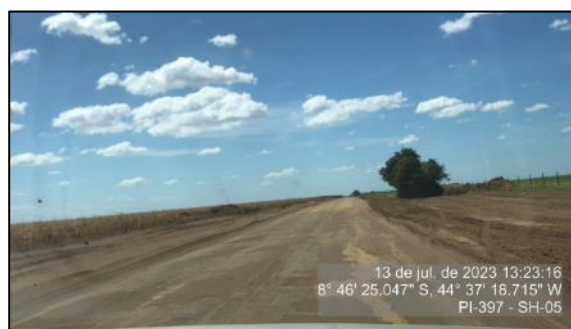
Figura 87 - Pista de rolamento em bom estado - SH-05
