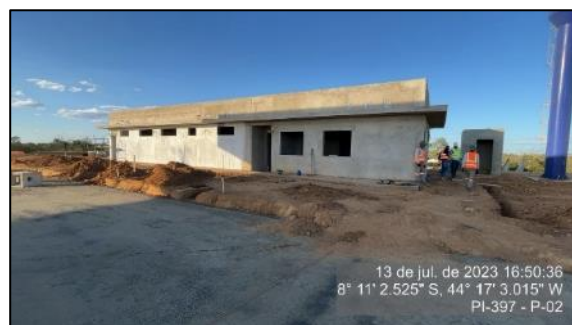
Figura 67 – Edificação de apoio da P2 - SH-02
