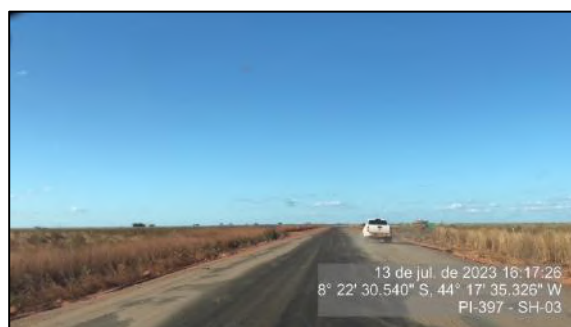
Figura 14 - Imprimação executada - SH-03
