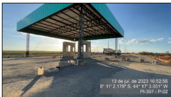
Figura 66 - Cobertura da P2 - SH-02
