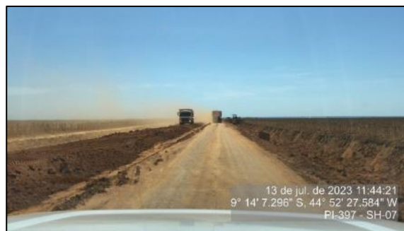
Figura 97 - Pista de rolamento em bom estado - SH-07
