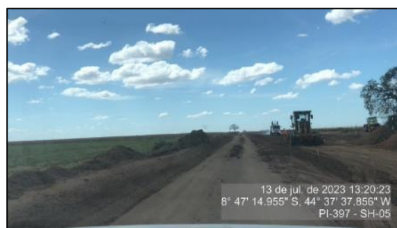
Figura 17 - Terraplenagem em execução - SH-05
