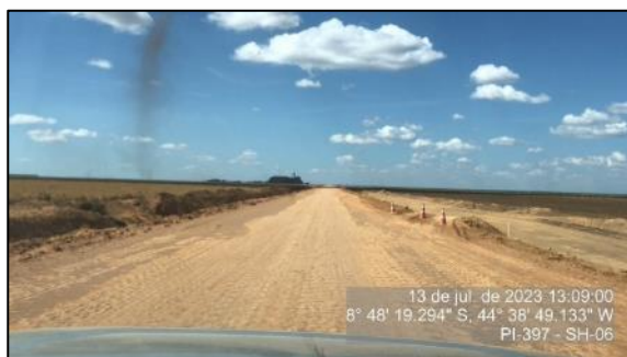
Figura 92 - Pista de rolamento em bom estado - SH-06
