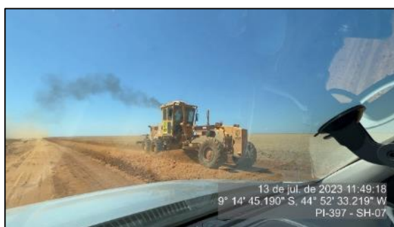
Figura 30 – Terraplenagem em execução – SH-07
