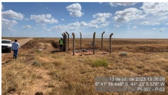
Figura 89 - Local de implantação da P3 - SH-05
