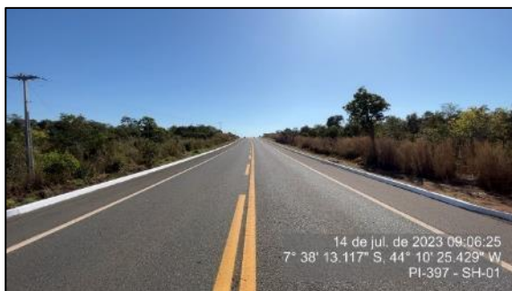
Figura 35 – Sinalização horizontal em bom estado – SH-01
