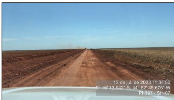
Figura 96 - Pista de rolamento em bom estado - SH-07
