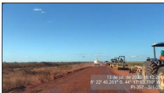
Figura 11 – Camada de base em execução - SH-03
