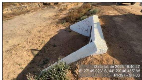
Figura 79 - Bueiro implantado no km 116 - SH-03
