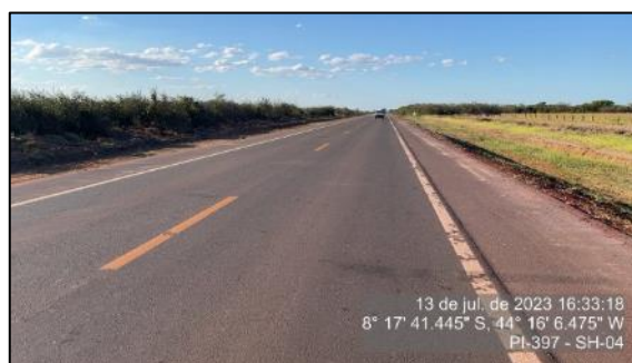
Figura 62 - Pavimento em bom estado - SH-02
