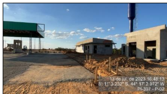
Figura 71 - Pavimento em implantação na P2 - SH-02
