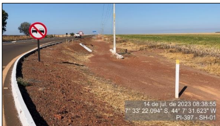
Figura 60 - Delimitador da faixa de domínio implantado - SH-01
