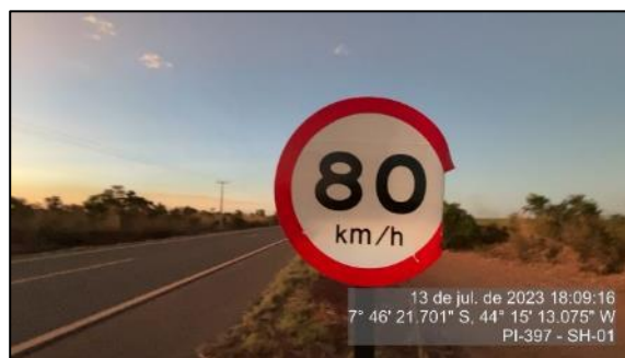
Figura 40 – Placa danificada – km 27,70 – SH-01
