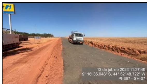
Figura 27 – Imprimação em execução – SH-07
