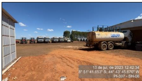
Figura 22 - Canteiro de obra - SH-06
