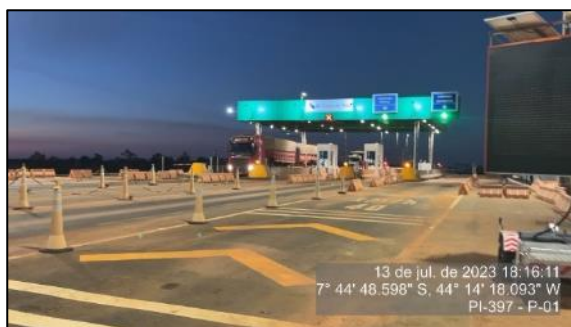
Figura 50 - Praça P1 em operação - SH-01
