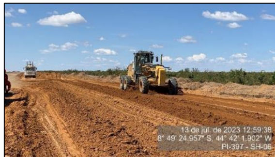
Figura 21 - Terraplenagem em execução - SH-06
