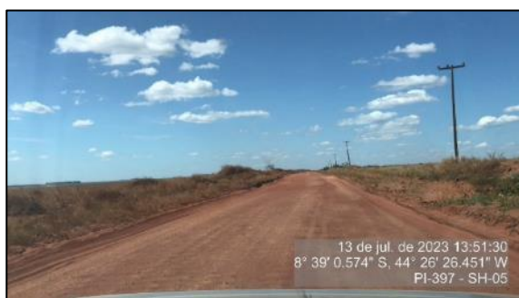
Figura 86 - Pista de rolamento em bom estado - SH-05
