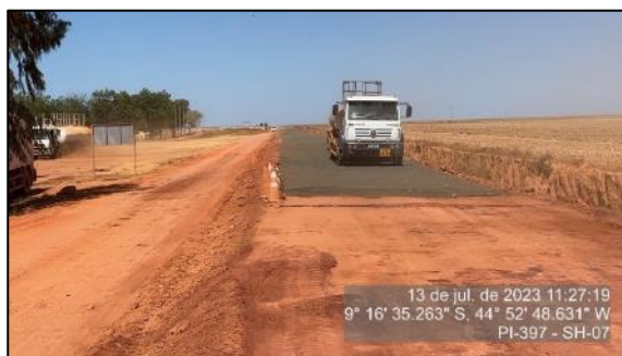
Figura 26 – Imprimação em execução – SH-07
