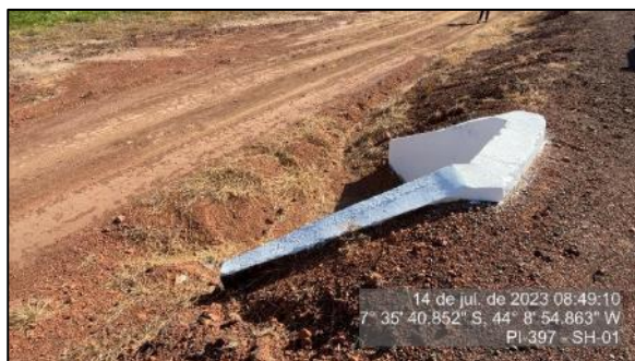
Figura 41 – Bueiro desobstruído no km 0.1 – SH-01
