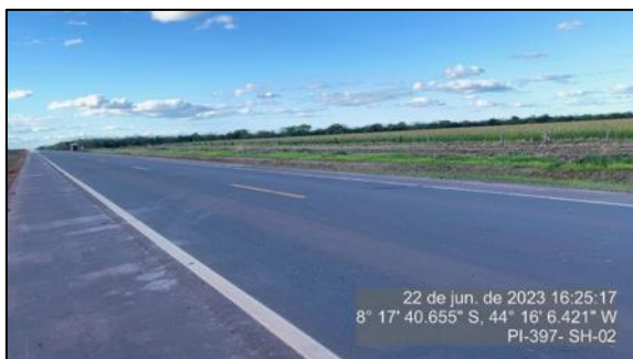
Figura 63 - Pintura da pista em bom estado - SH-02
