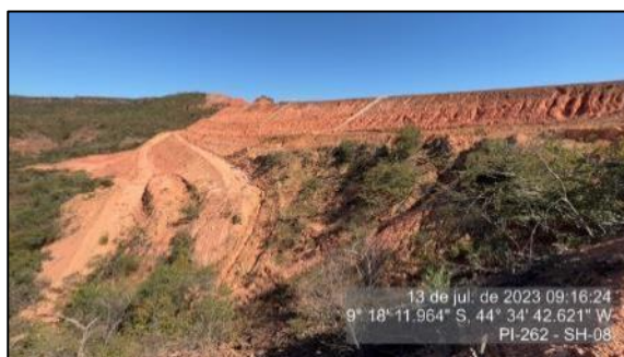
Figura 136 – Trecho em aterro
