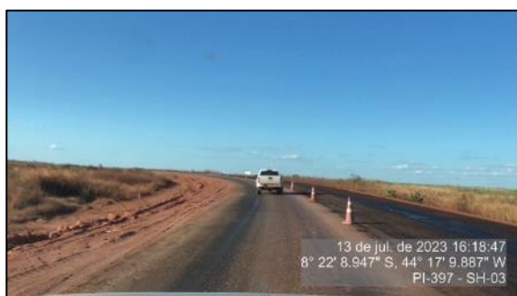
Figura 13 - Imprimação executada - SH-03
