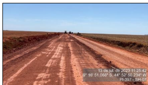
Figura 29 – Base em execução – SH-07
