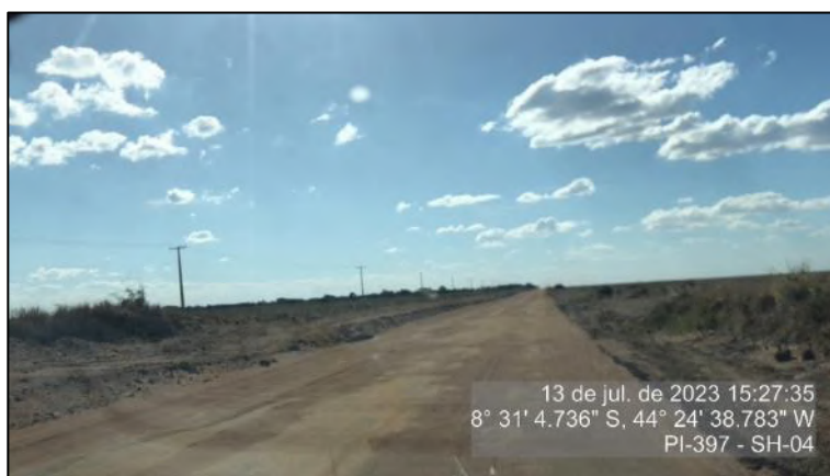
Figura 83 - Pista de rolamento em bom estado - SH-04
