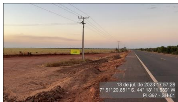
Figura 181 - Ponto de fuga fechado - km 38,80 - SH-01
