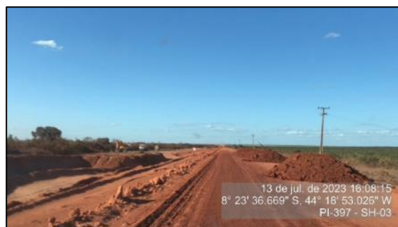
Figura 12 – Camada de base em execução - SH-03
