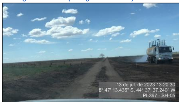
Figura 18 - Terraplenagem em execução - SH-05
