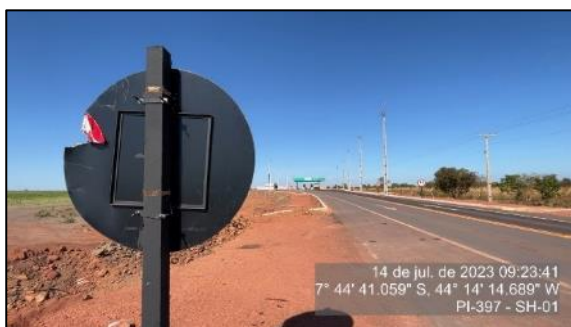
Figura 39 – Placa danificada – km 24,80 – SH-01
