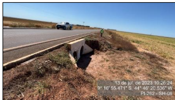
Figura 113 - Bueiro km 28 limpo e desobstruído - SH-08
