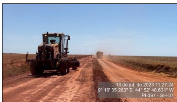
Figura 28 – Base em execução – SH-07
