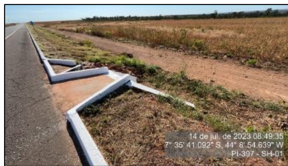
Figura 42 – Bueiro desobstruído no km 05 – SH-01
