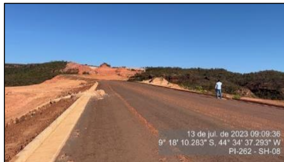
Figura 129 – Imprimação deteriorada
