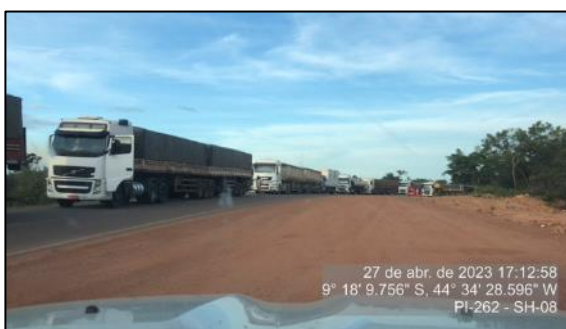
Figura 143 – Interrupção de Tráfego devido à deterioração do pavimento – Serra do Quilombo
