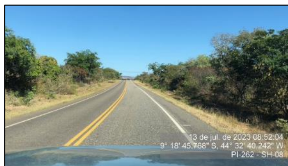
Figura 103 - Pavimento em bom estado - SH-08
