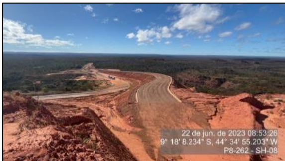
Figura 128 – Trecho imprimado na subida da Serra do Quilombo
