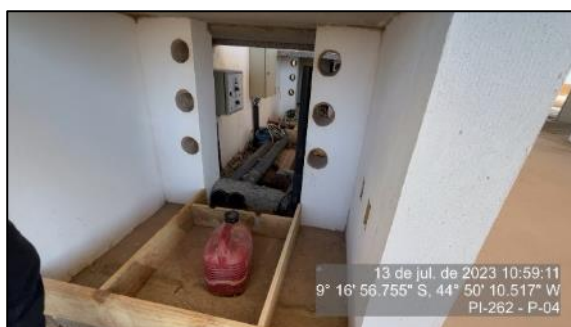
Figura 122 – Instalações em execução – P4
