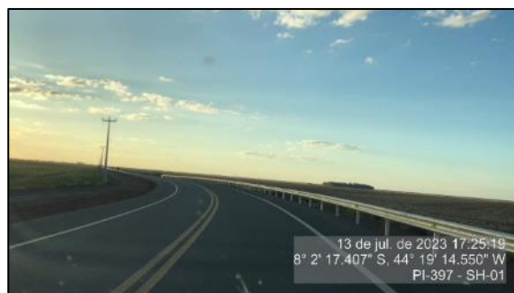
Figura 57 - Defesa lateral implantada - SH-01
