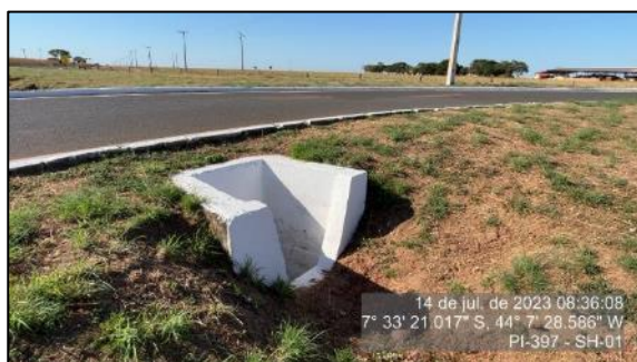
Figura 45 – Bueiro limpo implantado na interseção – SH-01
