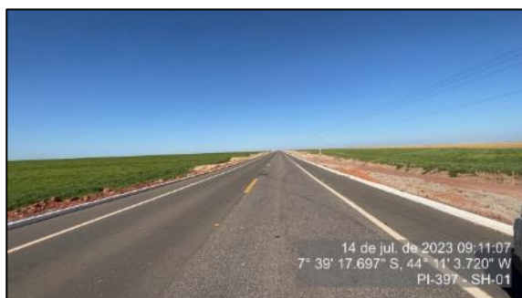
Figura 33 – Pavimento em bom estado – SH-01
