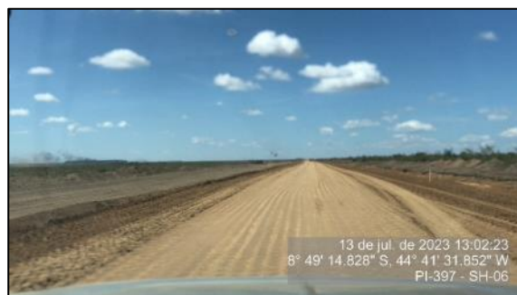
Figura 93 - Pista de rolamento em bom estado - SH-06
