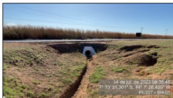
Figura 46 – Bueiro limpo implantado na interseção – SH-01
