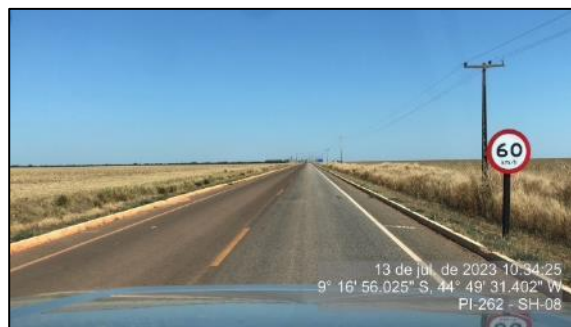
Figura 111 - Placa de regulamentação em bom estado - SH-08
