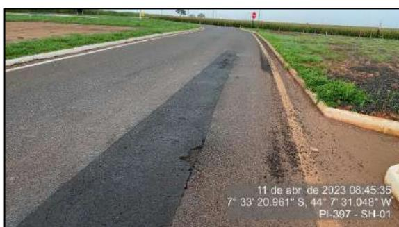
Figura 14 - Remendo executado - Vistoria Conjunta 02 - SH-01
