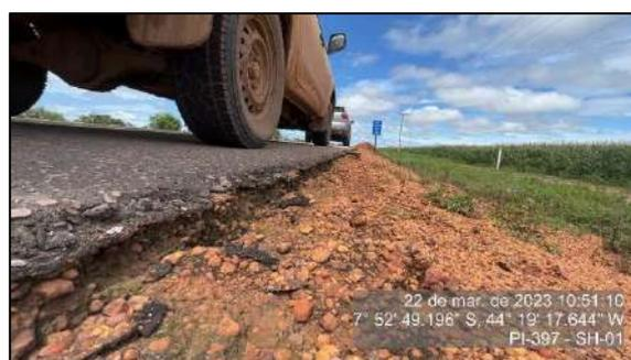
Figura 36 - Talude com risco e baixa cobertura vegetal - SH-01
