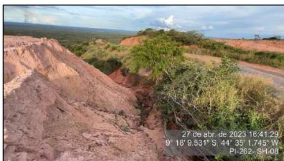
**Figura 118 – Processo erosivo nos taludes do bota-fora e da rodovia existente**
