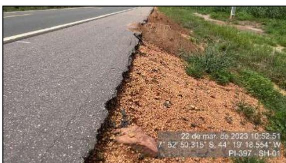
Figura 35 - Talude com risco e baixa cobertura vegetal - SH-01
