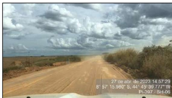
**Figura 88 - Trecho com boa trafegabilidade após intervenções - SH-06**
