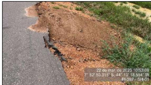
Figura 38 - Material depositado para reforço do talude - SH-01
