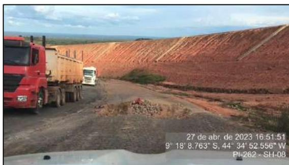
Figura 113 – Pavimento deteriorado na descida da Serra do Quilombo - 2
