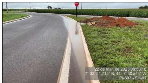
Figura 34 - Solução de drenagem provisória implantada na interseção - SH-01
