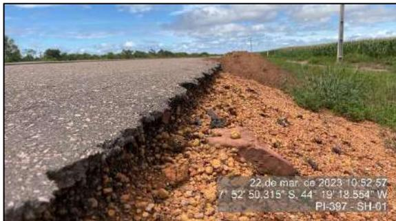
Figura 37 - Material depositado para reforço do talude - SH-01
