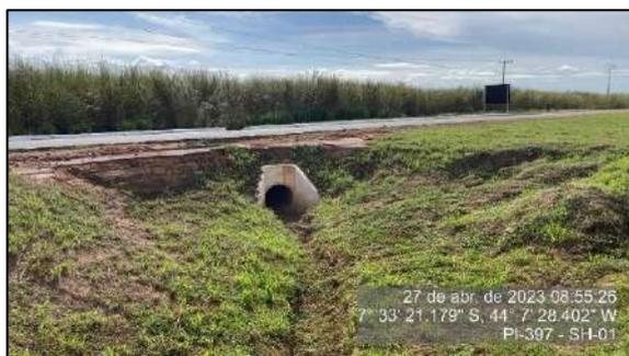
Figura 29 - Bueiro implantado na interseção - SH-01
