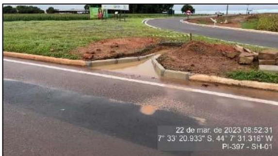
Figura 33 - Solução de drenagem provisória implantada na interseção - SH-01
