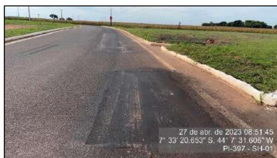
Figura 17 - Remendo executado - Vistoria Conjunta 03 - SH-01
