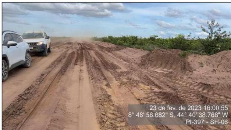
Figura 83 - Ponto com material solto na faixa de rolamento - SH-06
