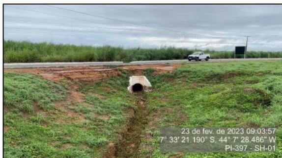
Figura 20 - Bueiro implantado na interseção - SH-01
