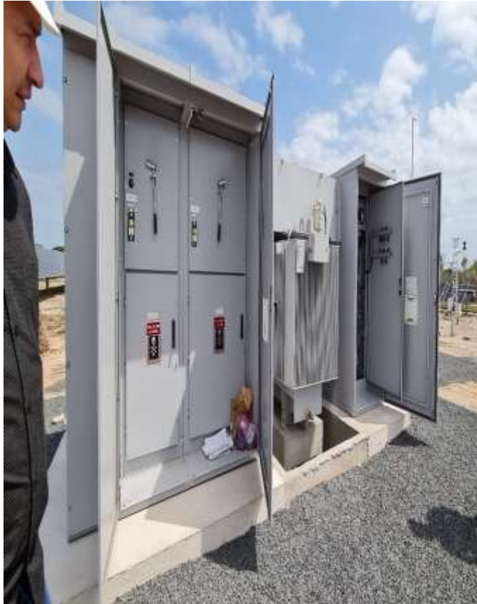
Foto 09 - Subestação 1.5 MVA
