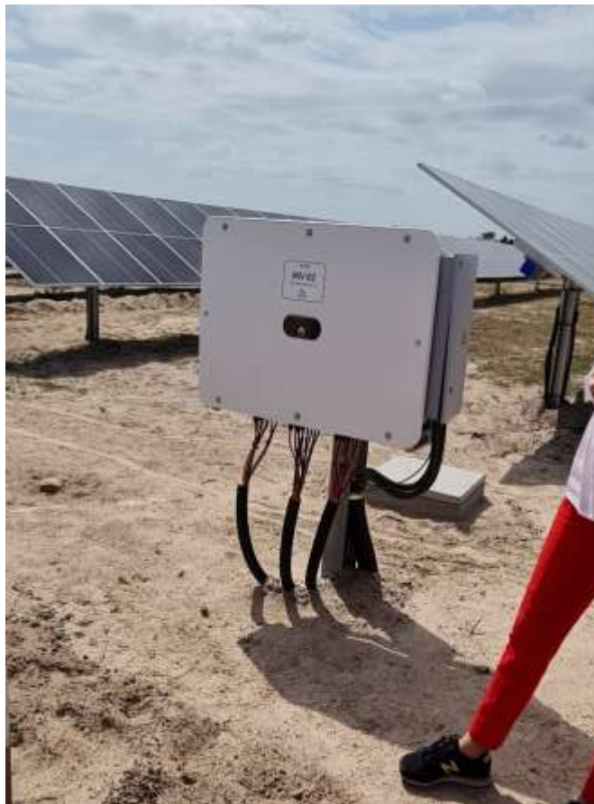
Foto 05 - Inversores 250 KW
