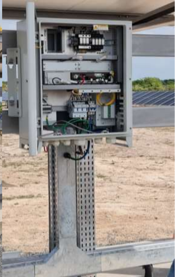
Foto 12 - Disposição de Placas e Inversores
