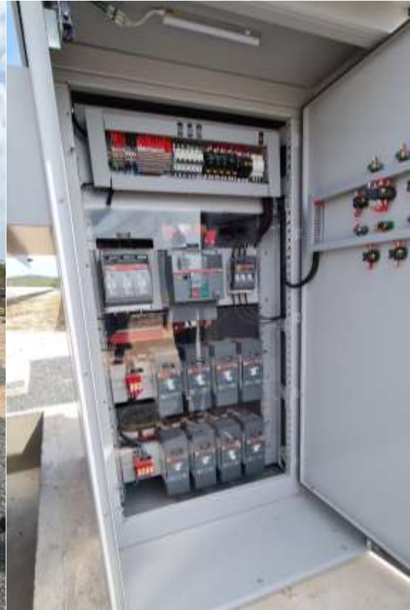
Foto 10 - Quadro geral de proteção
