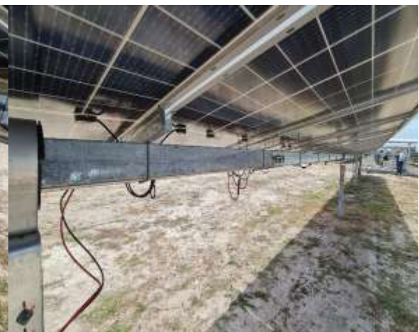
Foto 16 - Disposição das Placas
