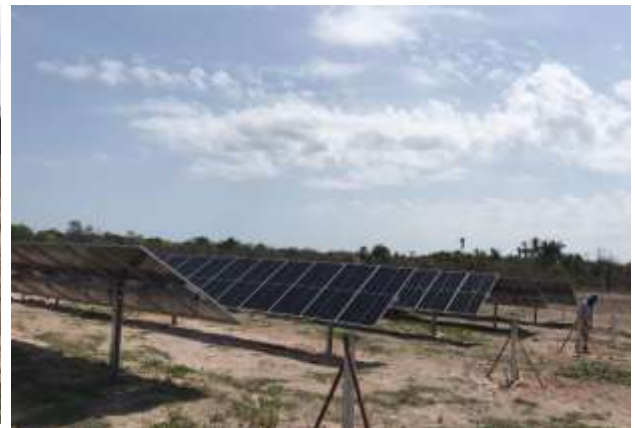
Registro da montagem dos módulos.
