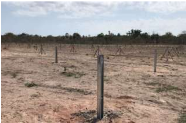
Registro da montagem dos trackers.
