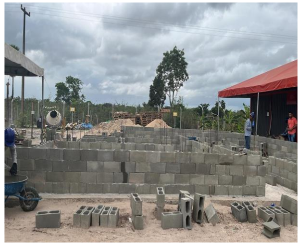
Registro do Início do Prédio O&M.
