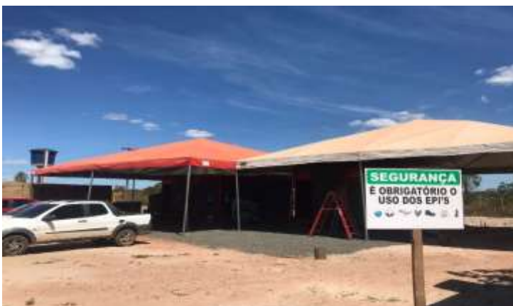
Registro do canteiro de obra.
