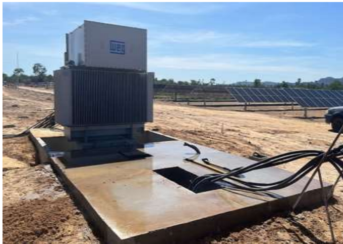
Registros dos Transformadores.
