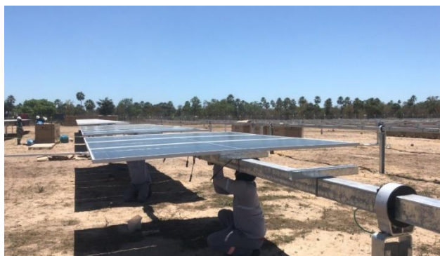
Registro da montagem dos módulos.
