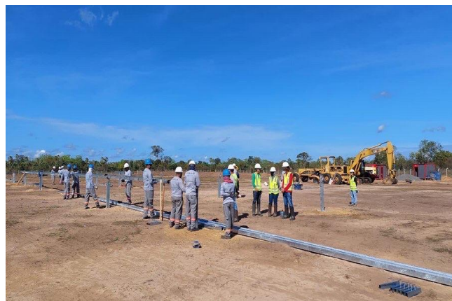
Registro da montagem do tracker .
