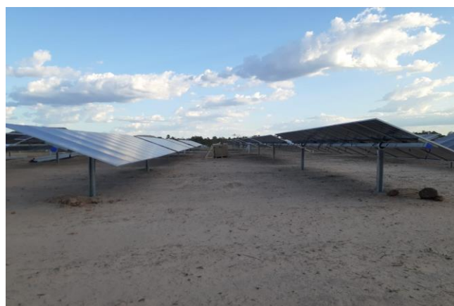
Registro da montagem dos módulos.
