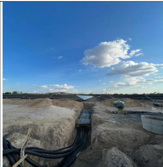
Registro da fundação dos transformadores.
