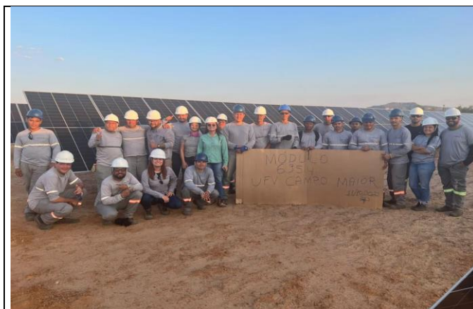
Registros da montagem dos módulos.
