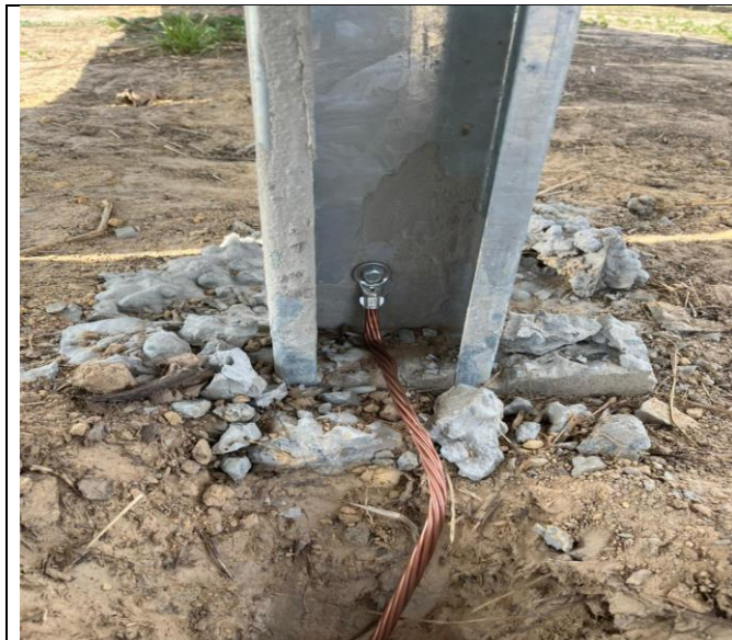
Registro do aterramento dos trackers.
