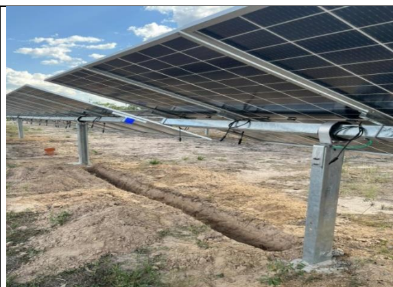
Registro da escavação das valas elétricas.
