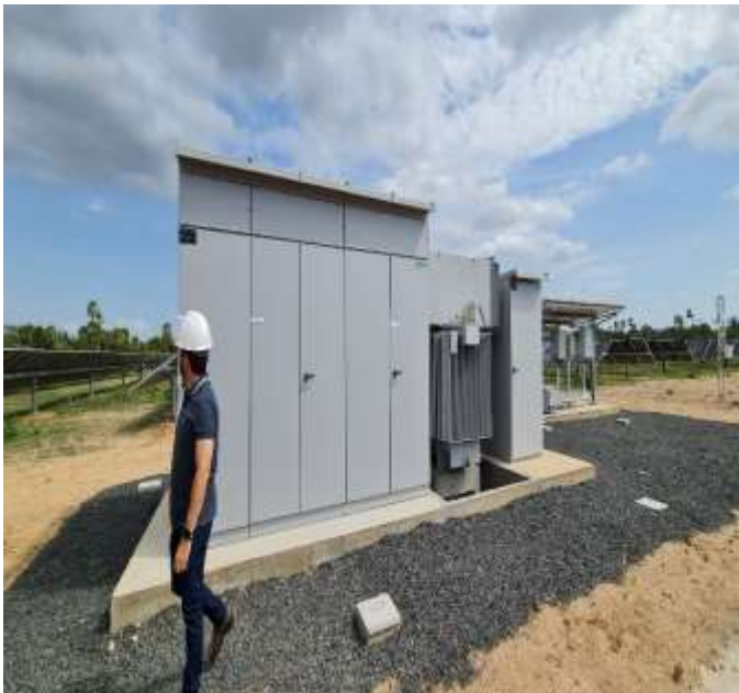
Foto 09 - Subestação 1.5 MVA
