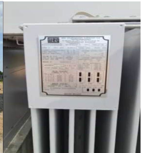
Foto 10 - Placa Trafo 1.5 MVA
