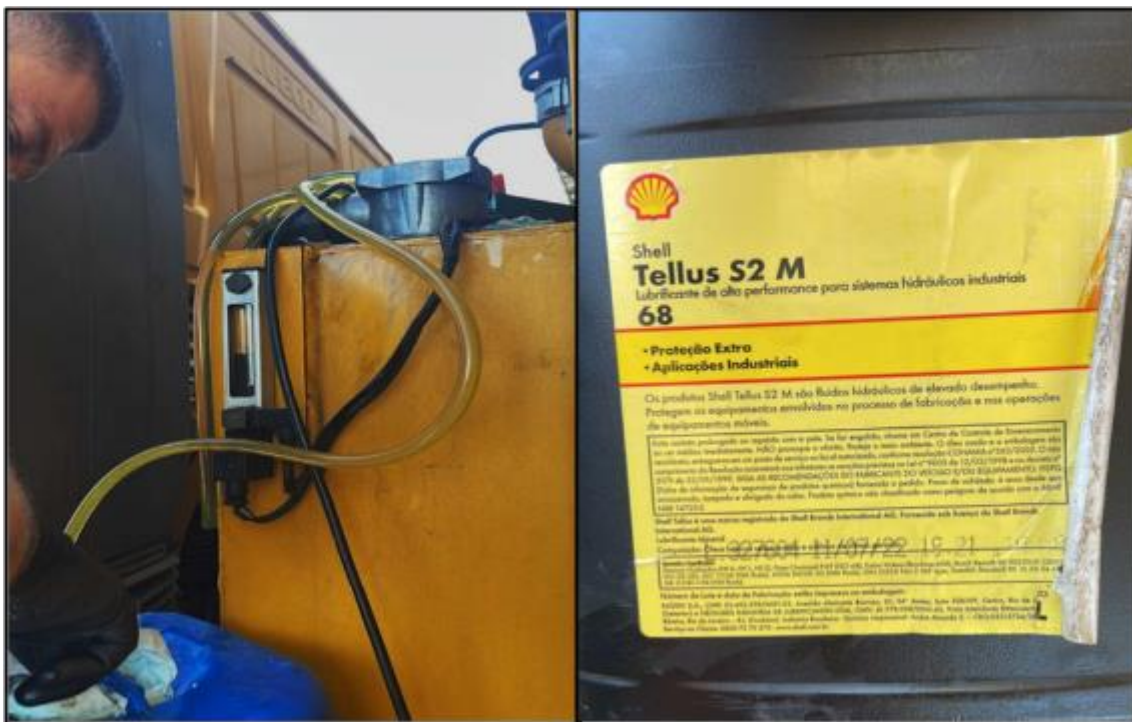
Figura 60. Higienização do sistema hidráulico
