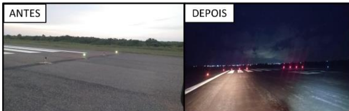
Figura 43. Manutenção das luzes de fim de pista da cabeceira 28
