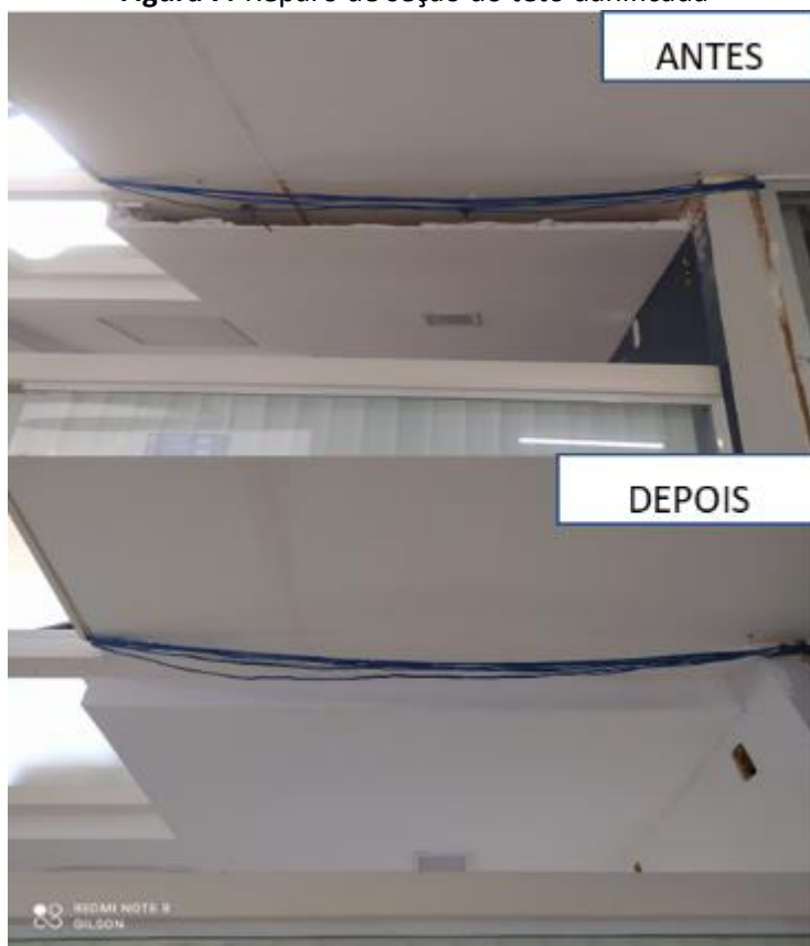
Figura 7. Reparo de seção do teto danificada
