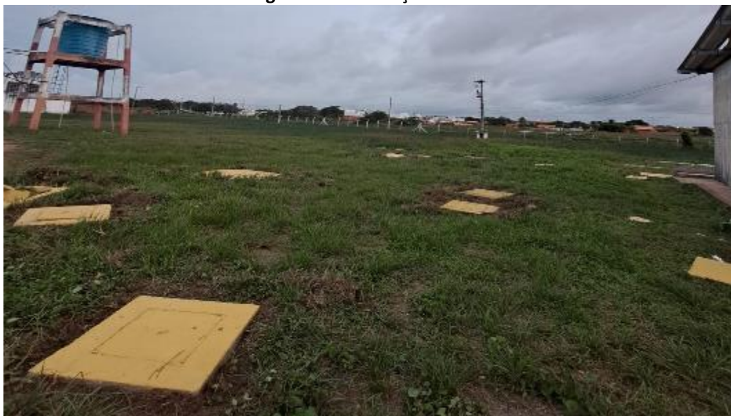
Figura 25. Sinalização de bueiros
