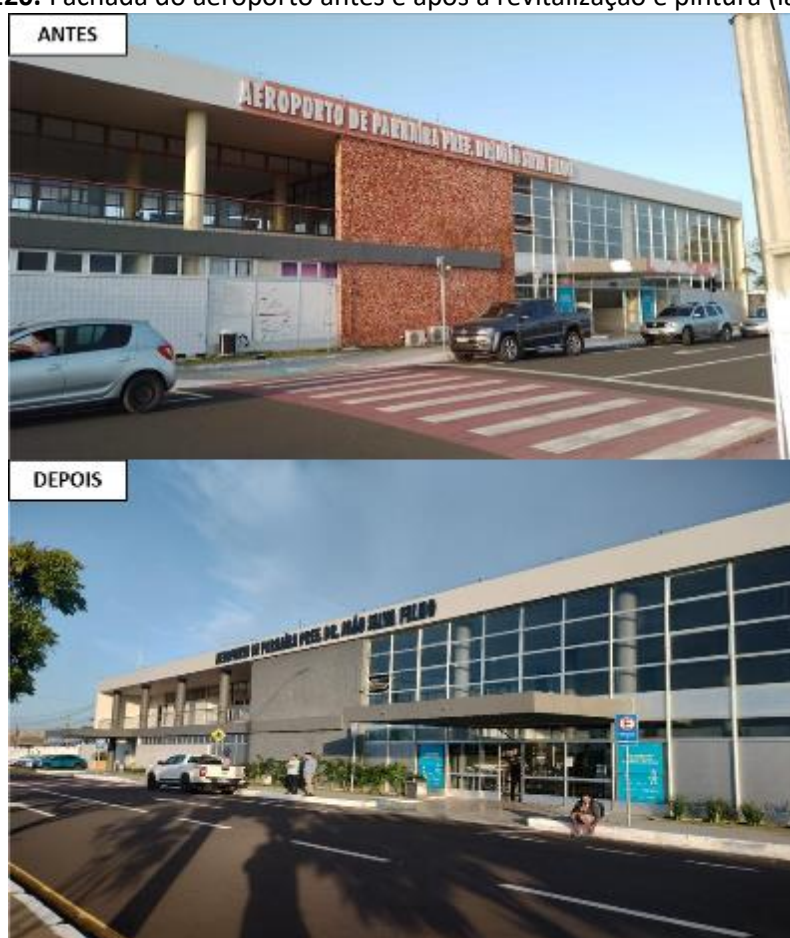
Figura 120. Fachada do aeroporto antes e após a revitalização e pintura (lado terra)
