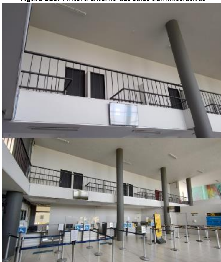
Figura 118. Pintura externa das salas administrativas
