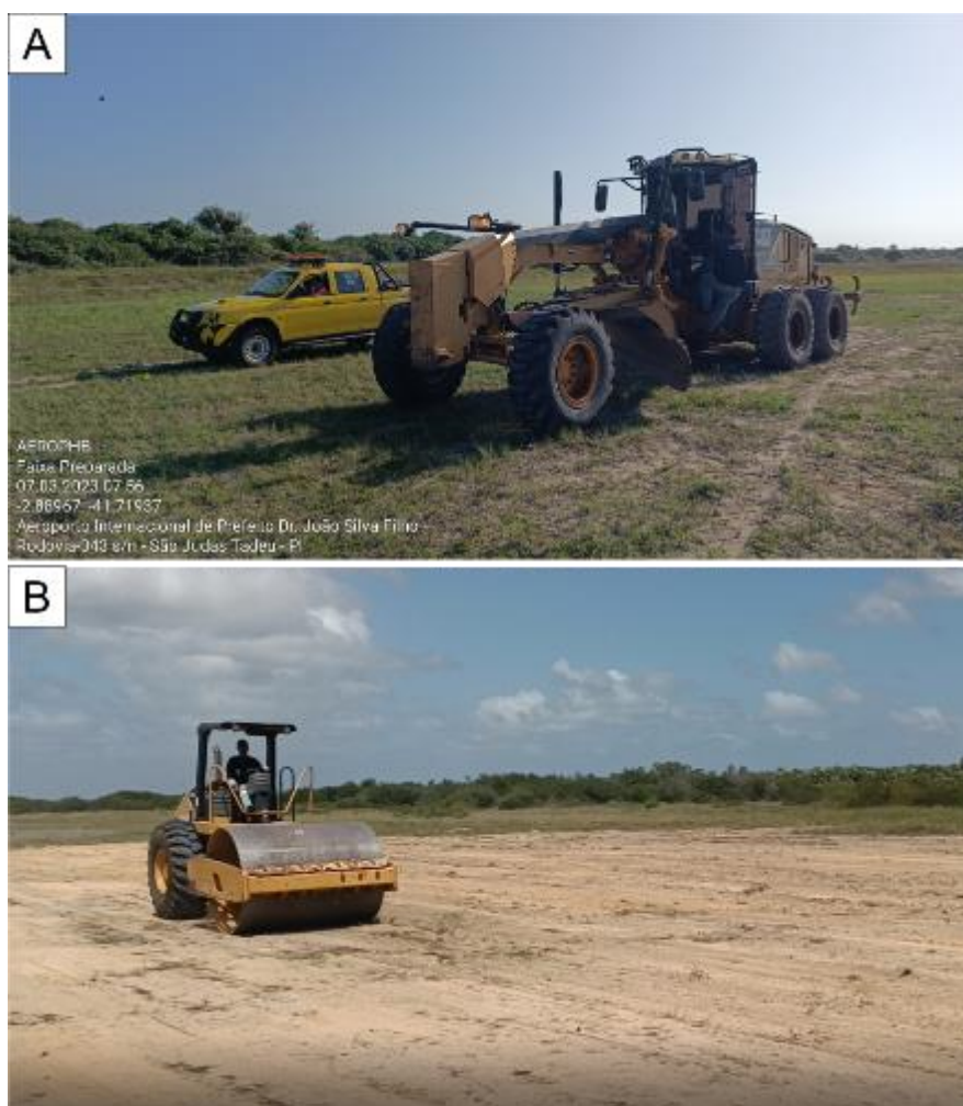
Figura 81. Maquinas utilizadas na execução do serviço de regularização da faixa preparada.
