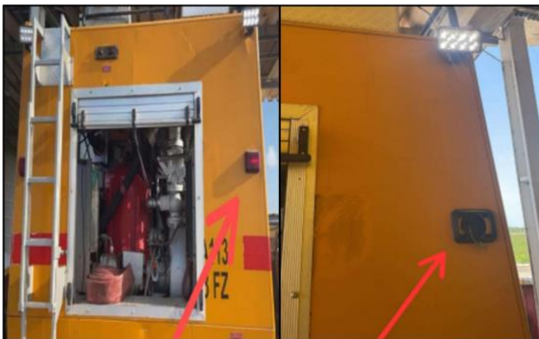
Figura 54. Substituição dos strobos
