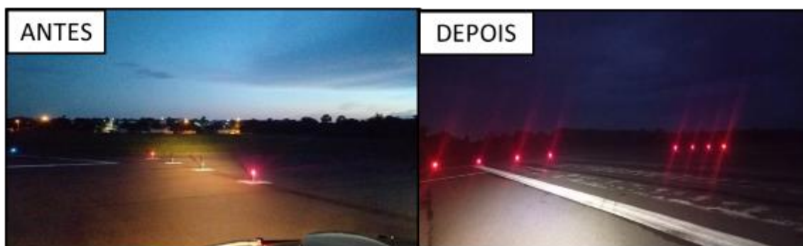
Figura 42. Manutenção das luzes de fim de pista da cabeceira 10
