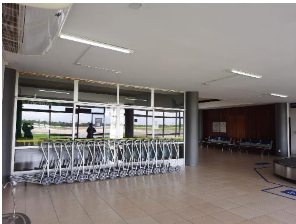
Figura 10. Pintura da área de desembarque e restituição de bagagem
