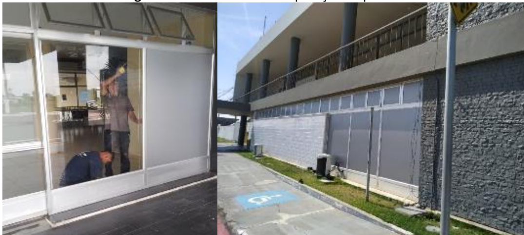
Figura 2. Troca dos vidros e aplicação da película
