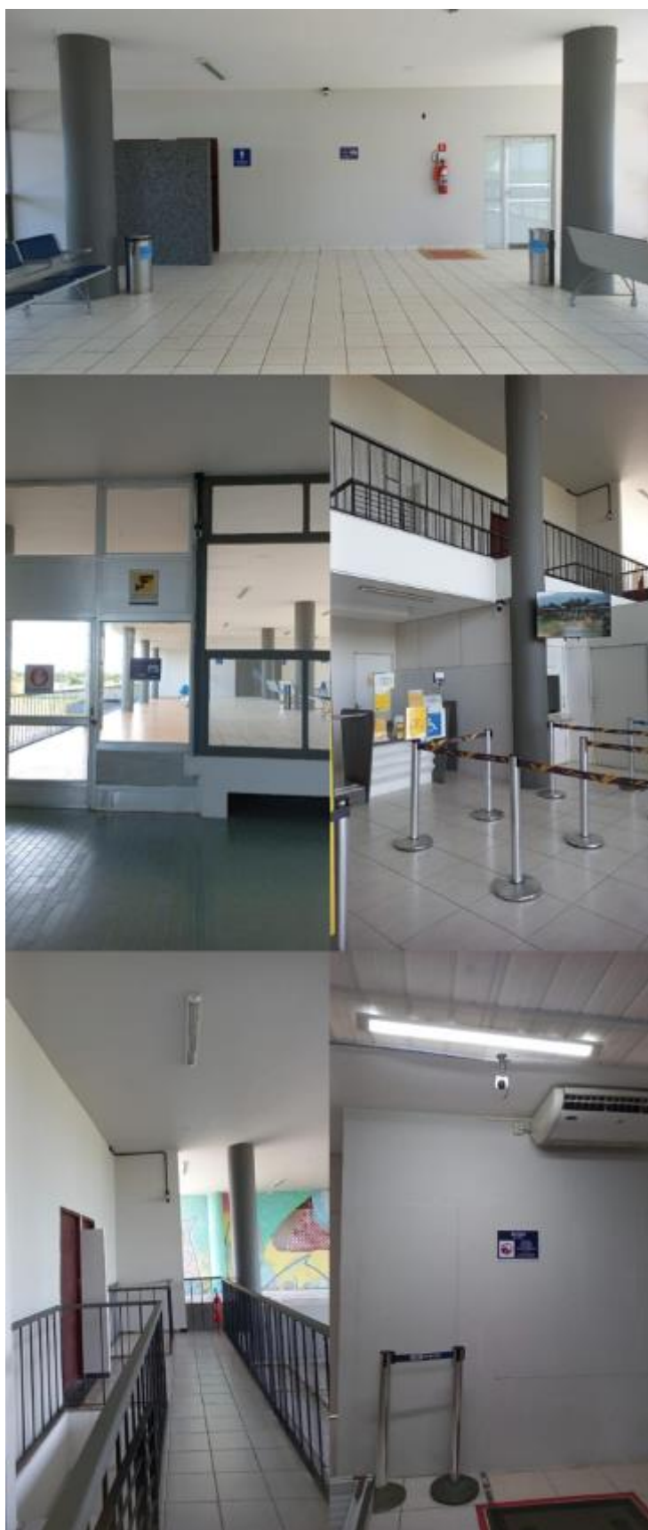
Figura 37. Algumas das câmeras de segurança instaladas no novo sistema
