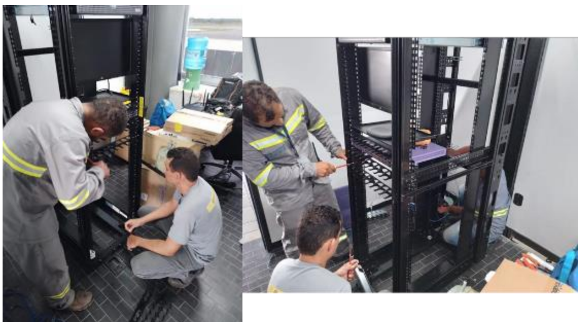
Figura 33. Instalação do NVR
