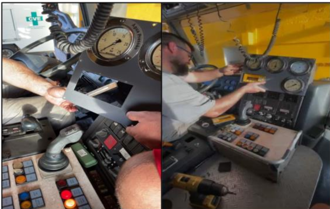
Figura 59. Substituição painel externo pelo interno
