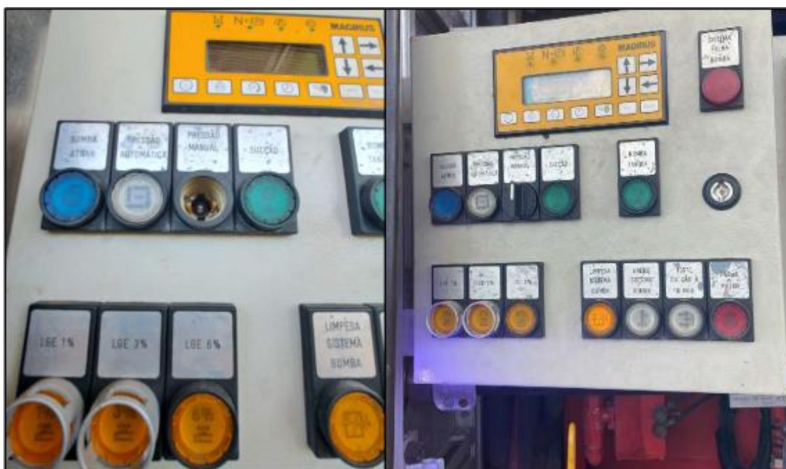
Figura 56. Substituição do botão de acelerador da bomba externa
