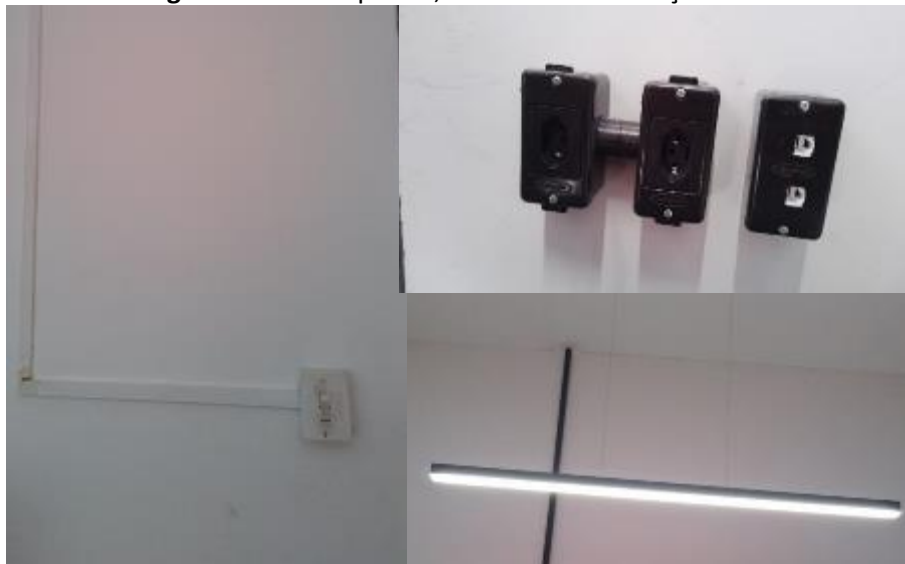
Figura 23. Interruptores, tomadas e iluminação nova
