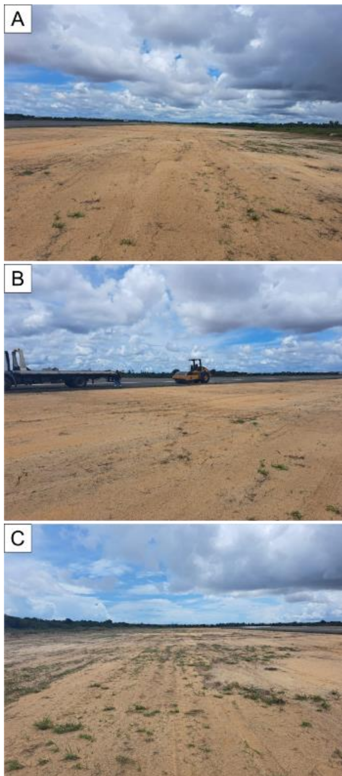
Figura 85. Registros fotográficos da área após a conclusão dos serviços de nivelamento e compactação.
