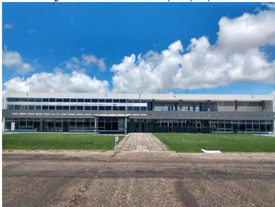
Figura 123. Fachada do lado ar do aeroporto após a pintura
