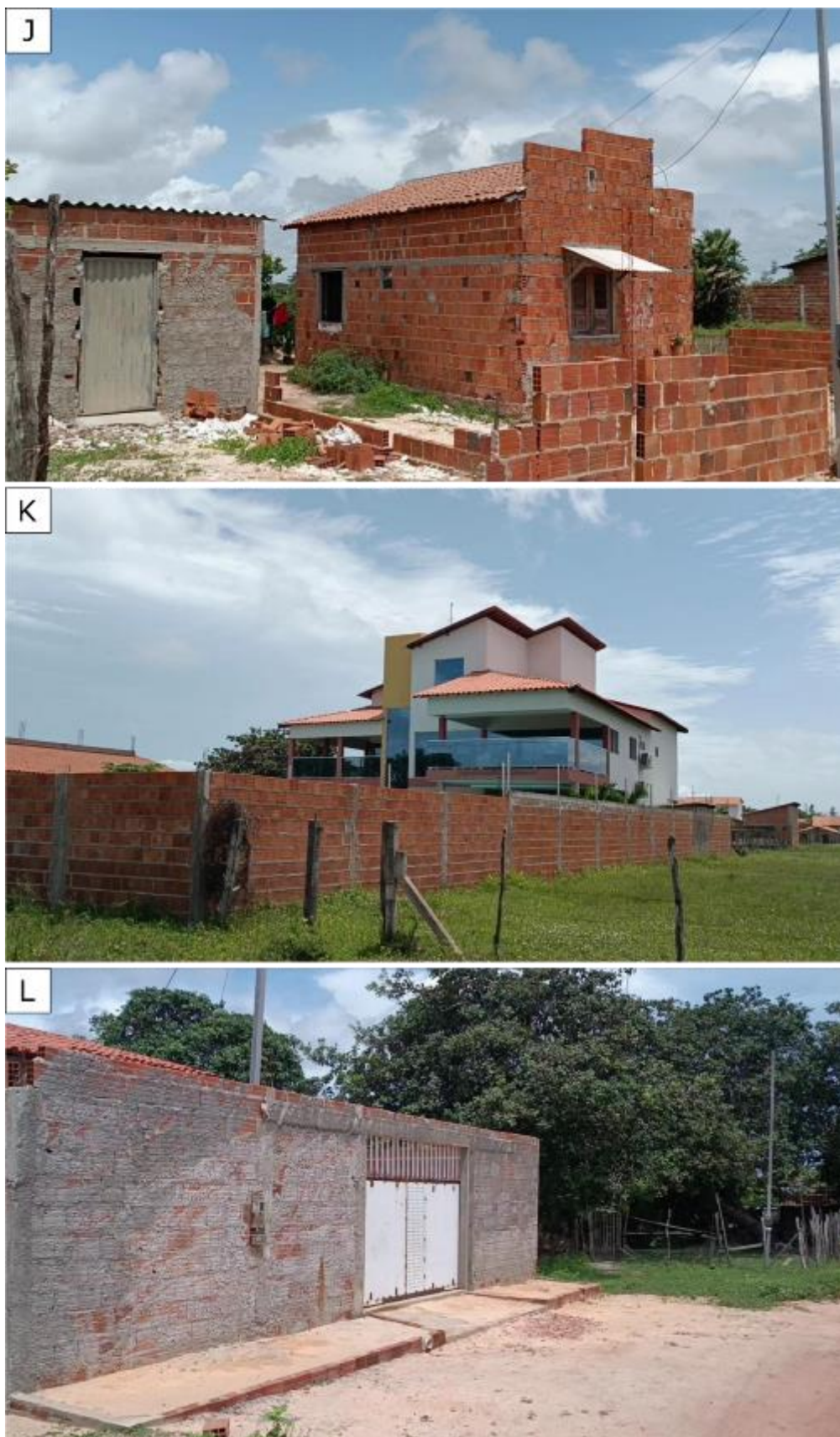
Figura 101. Residências vizinhas à cerca patrimonial da área da casa de força (continuação 3).
