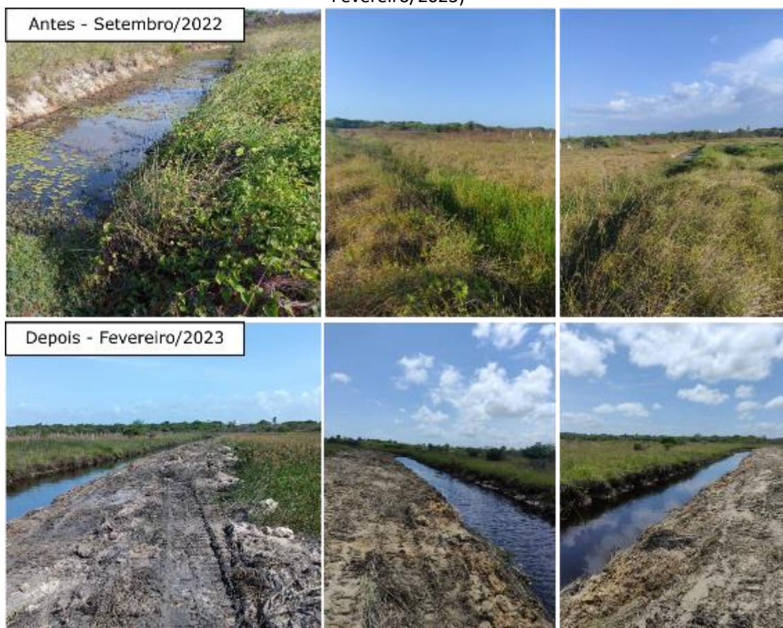
Figura 71. Antes e depois da realização dos serviços de desobstrução (Setembro/2022 versus Fevereiro/2023)
