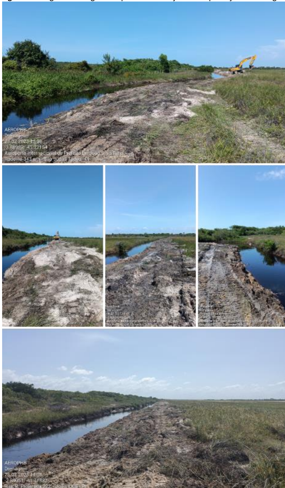
Figura 73. Registros fotográficos pós desobstrução e compactação das margens
