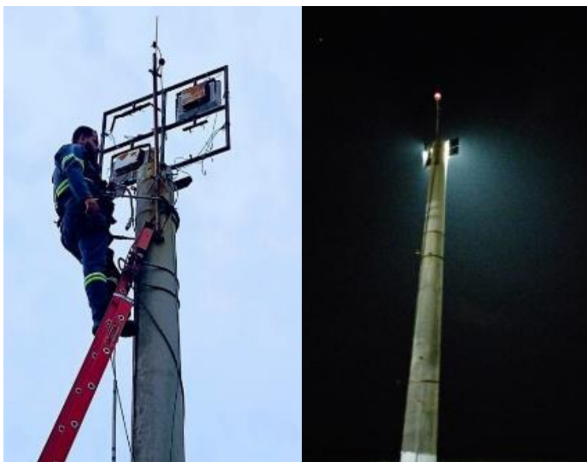
Figura 1. Instalação dos refletores
