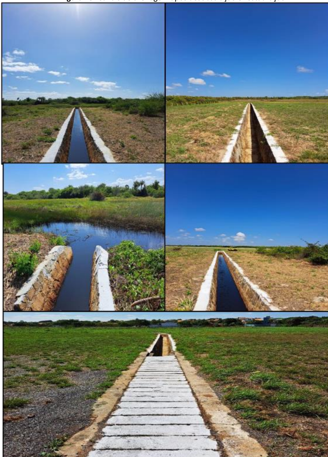
Figura 75. Canais de drenagem após desobstrução e restauração
