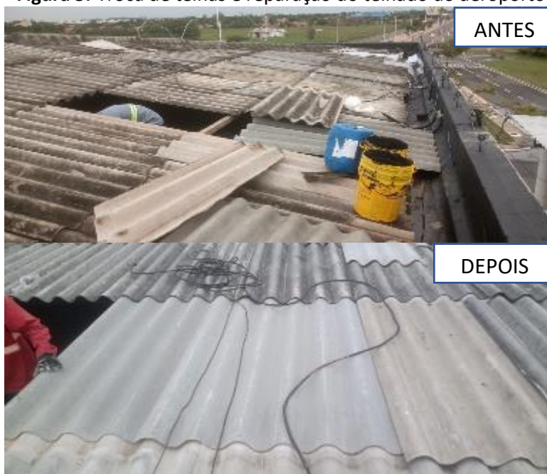
Figura 5. Troca de telhas e reparação do telhado do aeroporto
