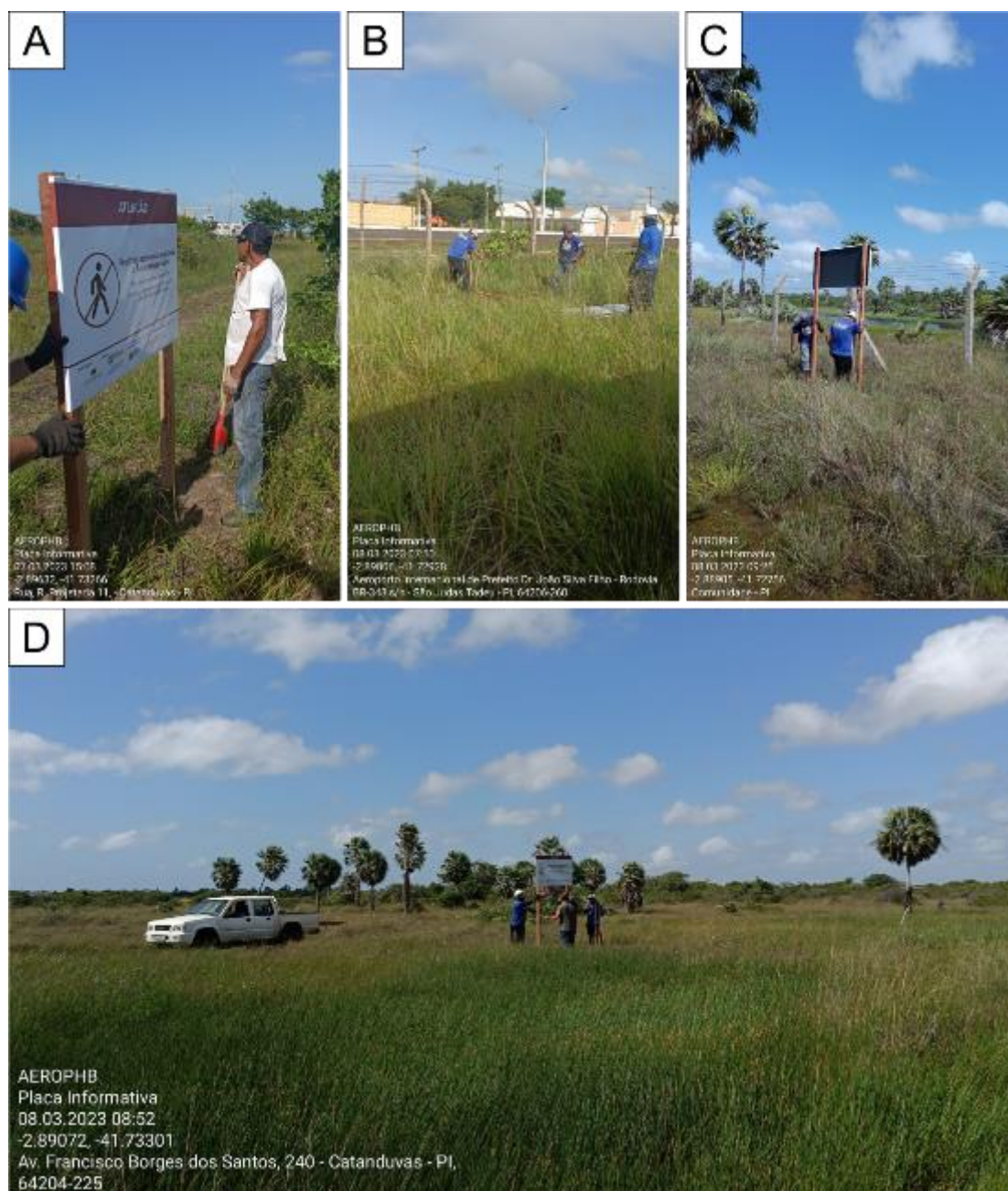
Figura 92. Instalação das placas informativas no perímetro da cerca patrimonial.
