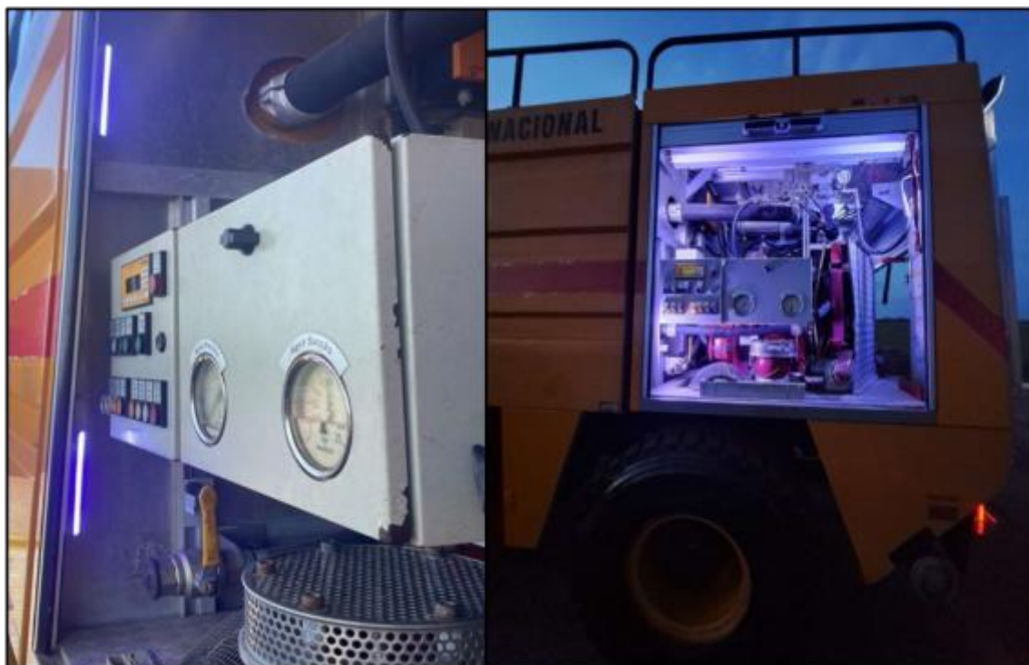
Figura 55. Substituição das luminárias traseiras
