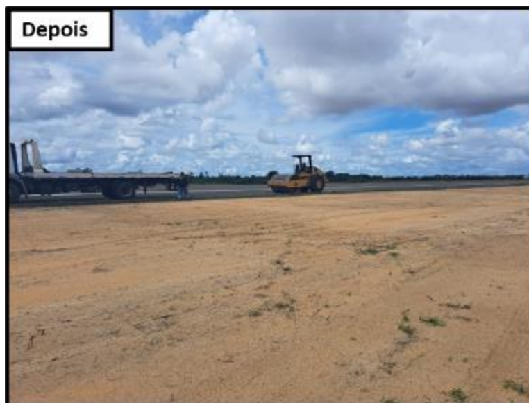
Figura 87. Resultado da regularização da faixa preparada
