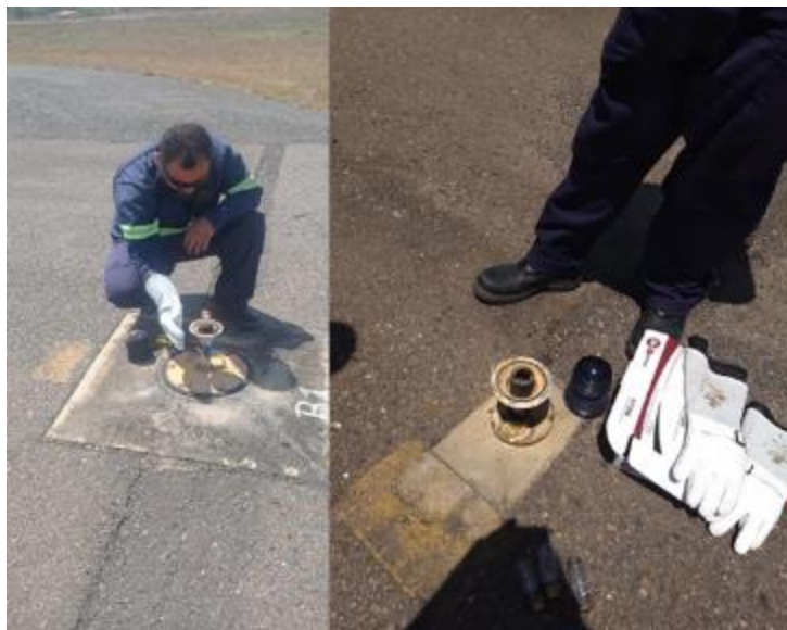
Figura 41. Trabalhos de manutenção das luzes do balizamento
