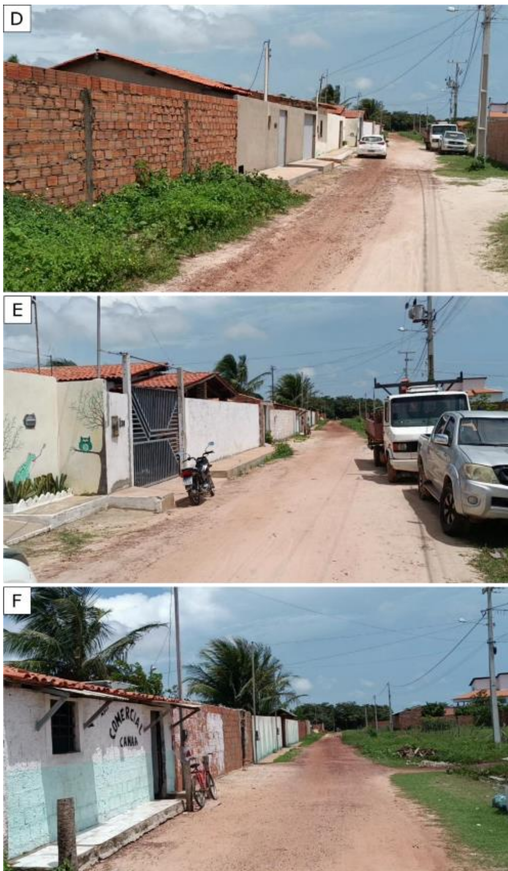
Figura 99. Residências vizinhas à cerca patrimonial da área da casa de força (continuação 1).
