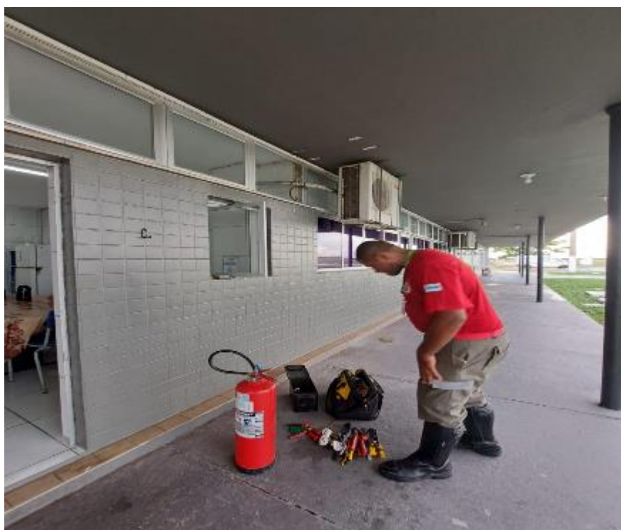
Figura 3. Colocação de nova sinalização em extintores do TPS
