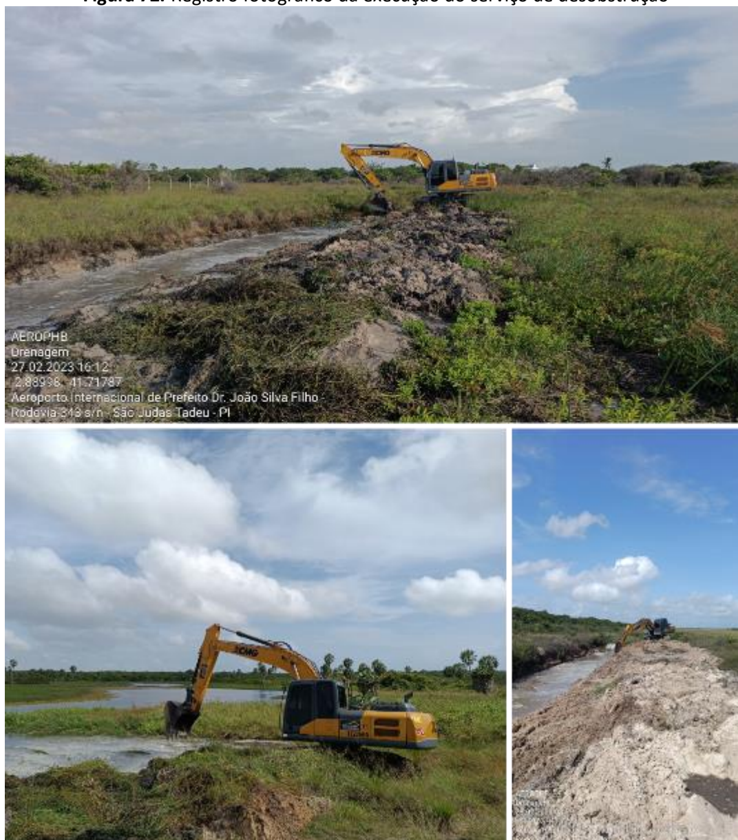
Figura 72. Registro fotográfico da execução do serviço de desobstrução
