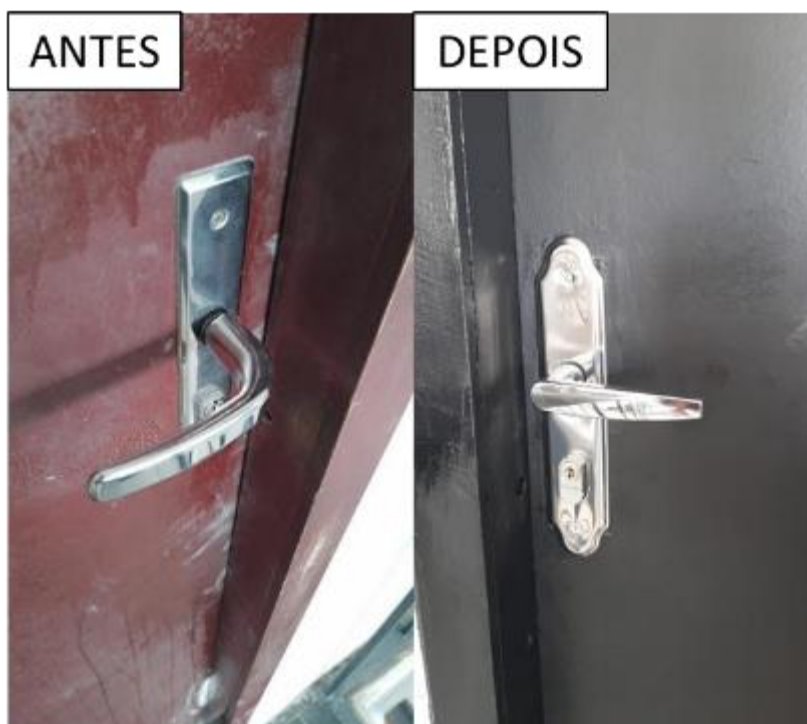
Figura 6. Troca de maçanetas das portas das salas de administração
