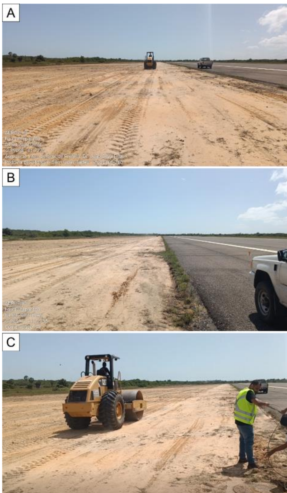
Figura 84. Registros fotográficos da área após a realização dos serviços de compactação.
