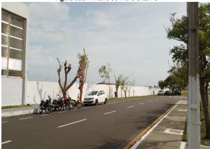
Figura 116. Pintura do muro externo
