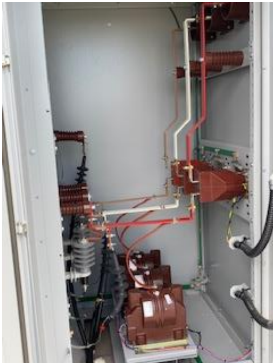
Foto 1 – Vistoria e Instalação dos Equipamentos de Medição
