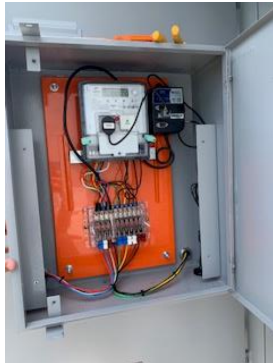
Foto 1 – Vistoria e Instalação dos Equipamentos de Medição
