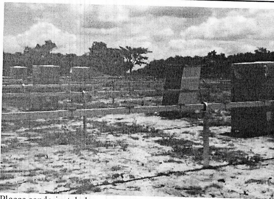
Placas sendo instaladas
