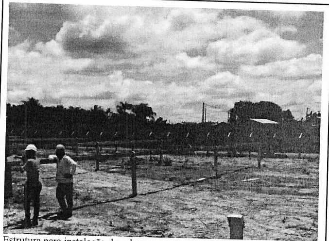
Estrutura para instalação das placas
