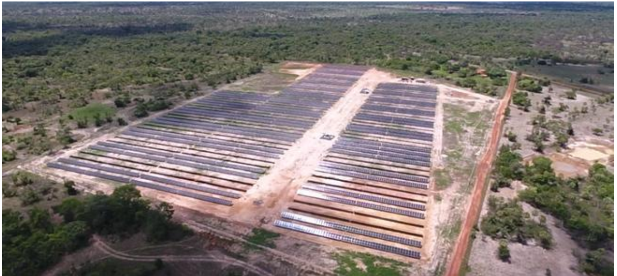
Foto 5 – Vista área da Mini-usina
