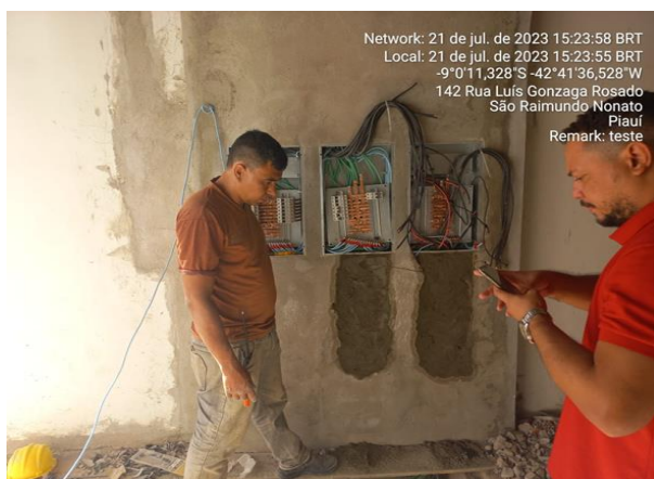
21/07/2023 – Finalização do processo de montagem dos Quadros secundários;
