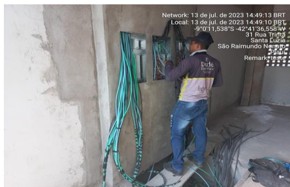
13/07/2023 - Instalação dos Quadros secundários dos corredores A, B e C;
