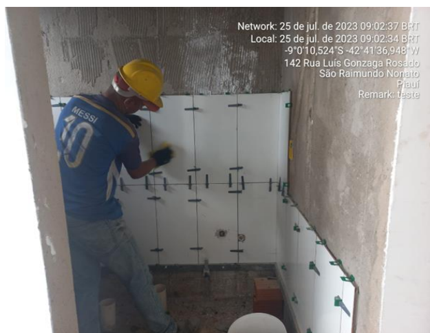
25/07/2023 – Execução de revestimento cerâmico dos banheiros da ALA C;
