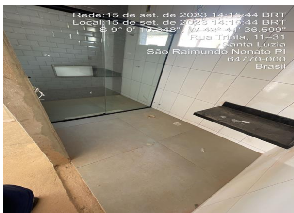
15/09/2023 – Instalação dos boxs, banheiros da ala A;
