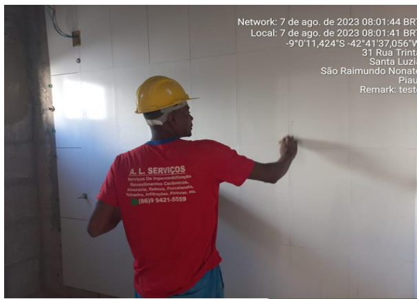
07/08/2023 - Execução de revestimento cerâmico dos banheiros da ala c;
