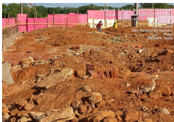
03/07/2023 - abertura de valas para locação dos pilares do restaurante;
