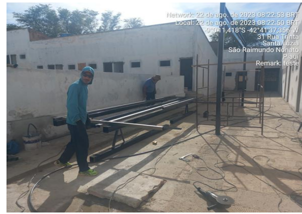
22/08/2023 – Execução de cobertura dos halls de circulação, ala A;
