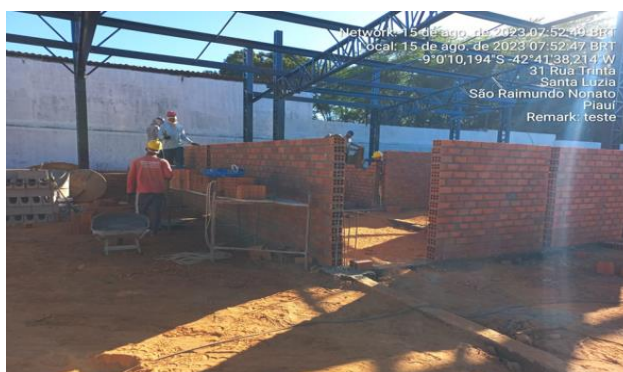
15/08/2023 – Execução de alvenaria de vedação no restaurante;
