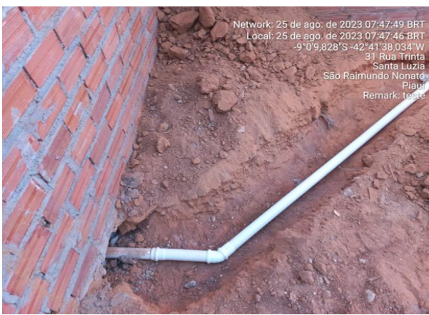
25/08/2023 – Execução de rede de esgoto do restaurante;
