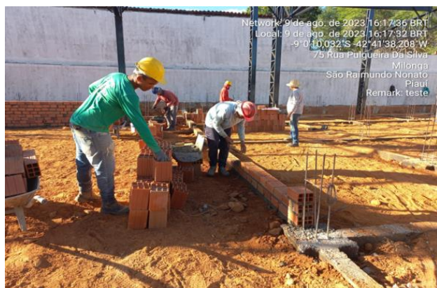
09/08/2023 – Execução de alvenaria de vedação no restaurante;
