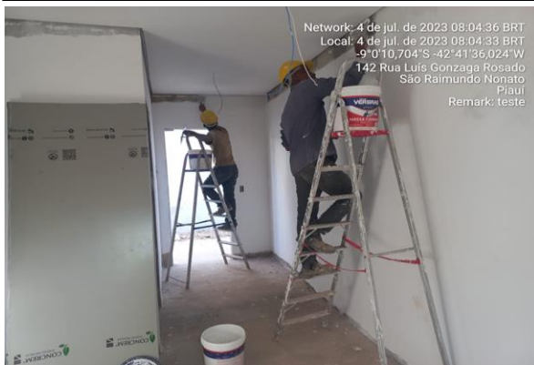
04/07/2023 - Emassamento do forro e paredes dos quartos;
