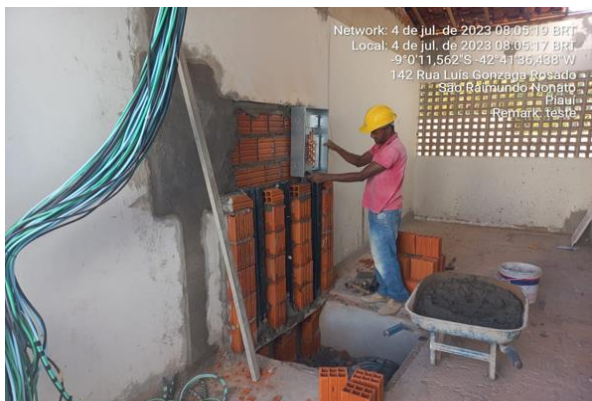
04/07/2023 - instalação de quadros de distribuição;
