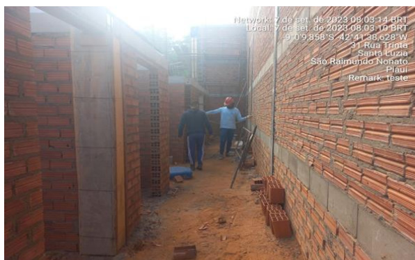
07/09/2023 – Execução de alvenaria de vedação do restaurante;
