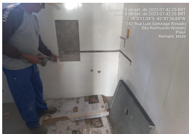
08/09/2023 – Execução de revestimento cerâmico nos banheiros da ala D;
