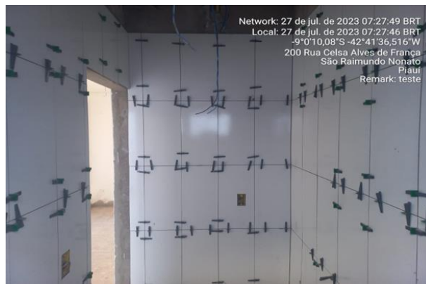
27/07/2023 – Execução de revestimento cerâmico, dos banheiros da ALA D;
