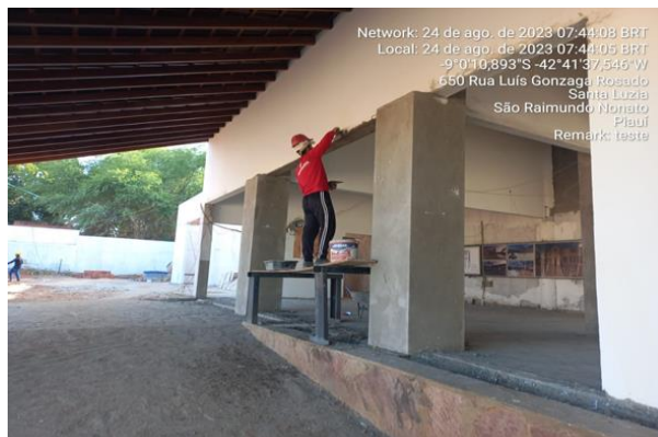
24/08/2023 – Execução de emassamento da superfície das paredes da recepção e estrutura de madeira;
