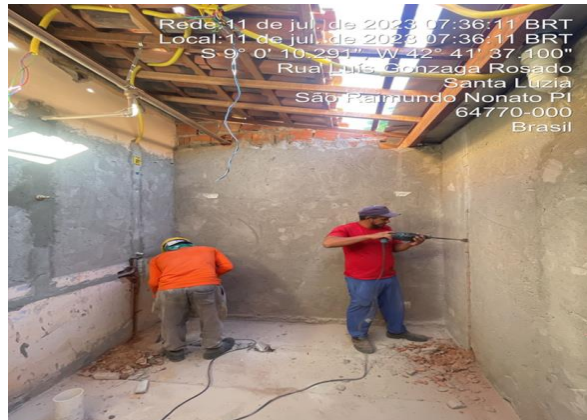
11/07/2023 - Processo de adequação dos pontos de hidráulica nos banheiros do corredor D;
