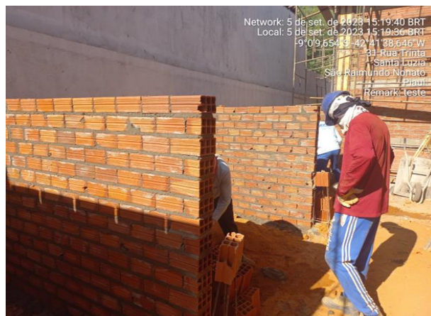
05/09/2023 – Execução de alvenaria de vedação nos banheiros masc e fem dos funcionários do restaurante;
