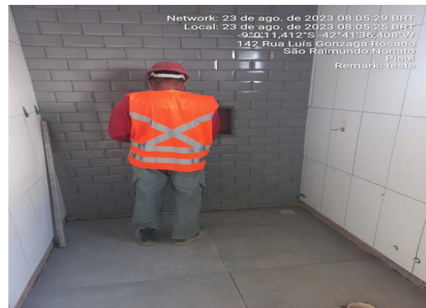
23/08/2023 – Execução de revestimento cerâmico nos banheiros da ala C;
