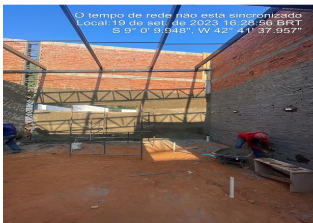
18/09/2023 – Execução de reboco das paredes do restaurante;
