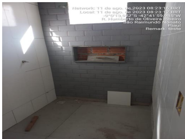
11/08/2023 - Execução de revestimento cerâmico banheiros da ala C;
