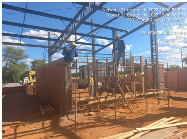
21/08/2023 – Execução de alvenaria de vedação do restaurante;
