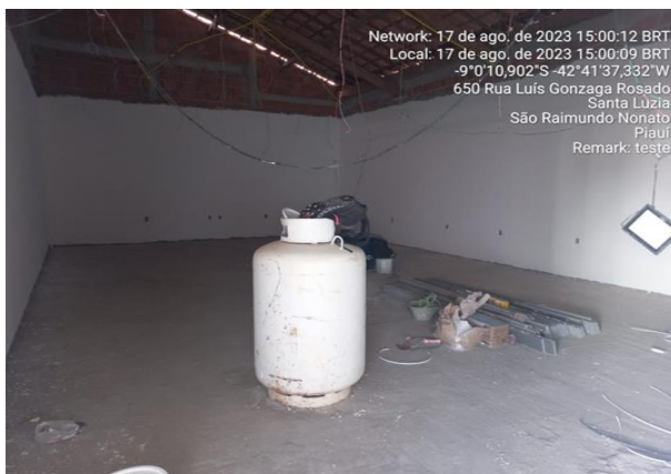
17/08/2023 – Execução de emassamento da superfície das paredes do auditório;
