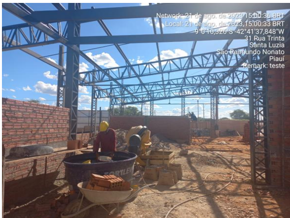
21/08/2023 – Execução de alvenaria de vedação do restaurante;
