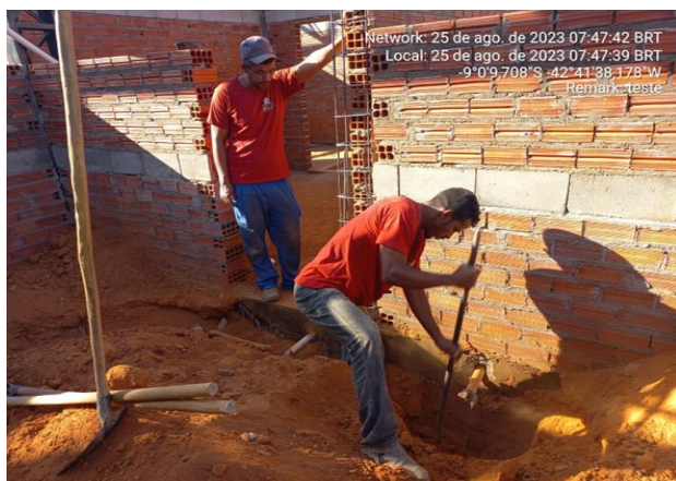
25/08/2023 – Execução de rede de esgoto do restaurante;
