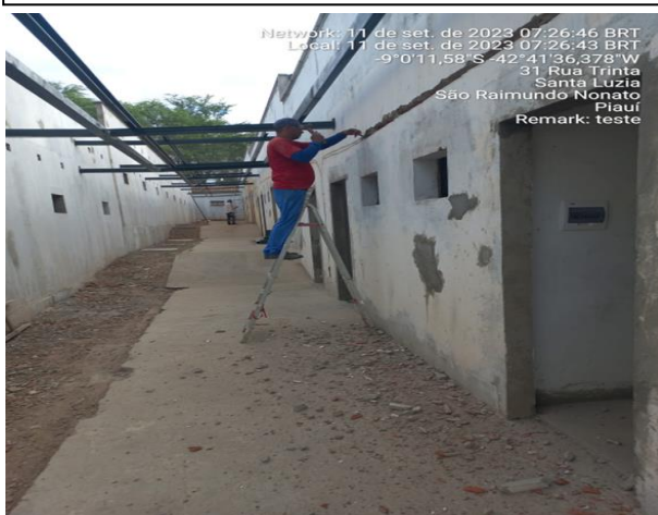
11/09/2023 – Execução de circuitos de iluminação do hall de circulação A e B;
