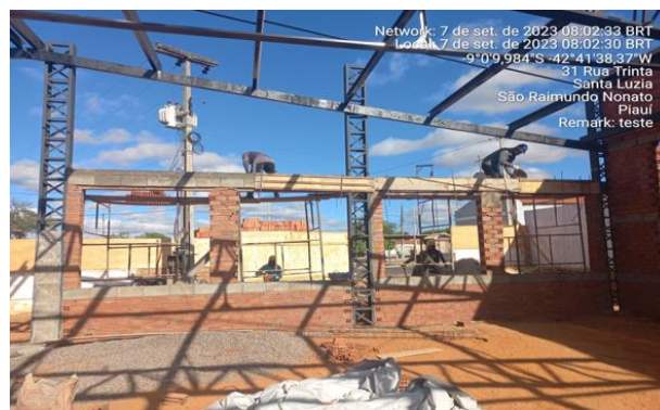
07/09/2023 – Execução de alvenaria de vedação do restaurante;
