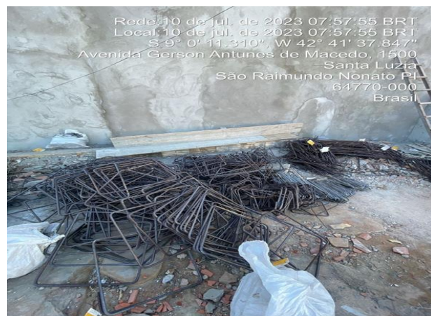
10/07/2023 – Execução de confecção dos pilares do restaurante;
