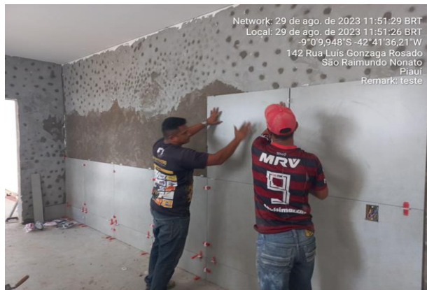
29/08/2023 – Execução de revestimento cerâmico da área de serviços;
