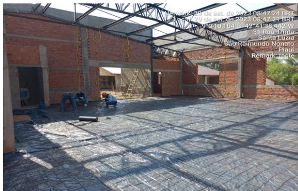
28/09/2023 – Execução de armadura transversal do piso do restaurante;
