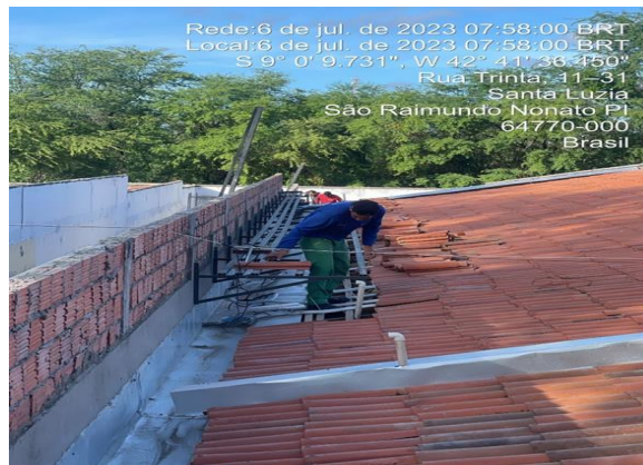
06/07/2023 - execução da plataforma metálica que acomodará todas as condensadoras dos apartamentos da ALA C;
