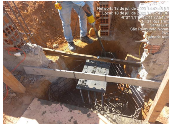
18/07/2023 – Execução de concretagem dos blocos de fundação no restaurante;
