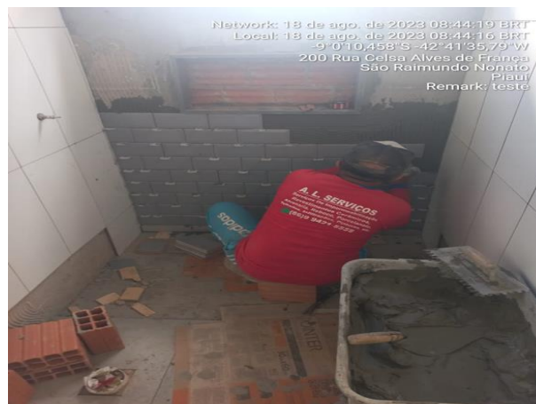
18/08/2023 – Execução de revestimento cerâmico e nicho dos banheiros da ala C;
