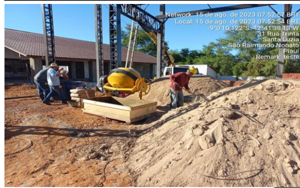
15/08/2023 – Execução de alvenaria de vedação no restaurante;
