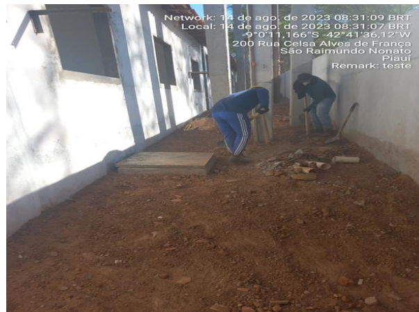
14/08/2023 – execução de compactação da superfície do solo, corredor A e B;
