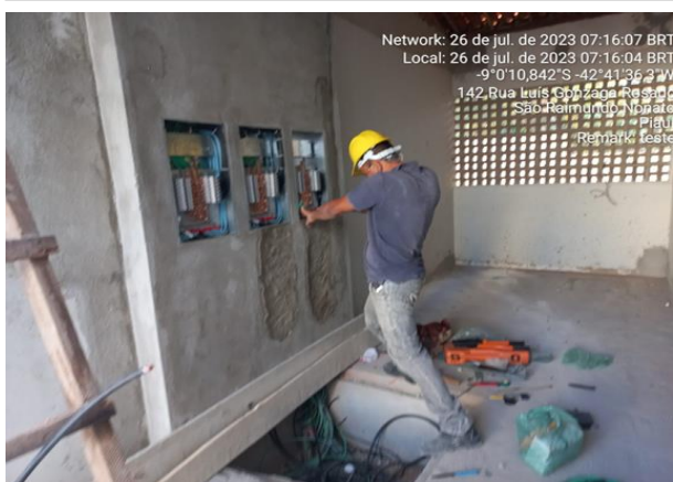
26/07/2023 – Finalização dos circuitos interno externos;
