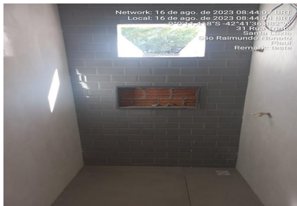
16/08/2023 – Execução de revestimento cerâmico dos banheiros da ala C;
