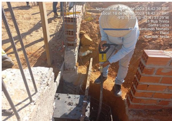
18/07/2023 – Execução de concretagem dos blocos de fundação no restaurante;
