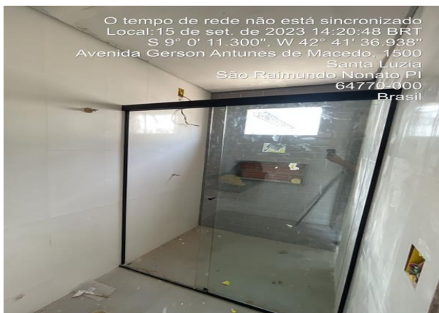
15/09/2023 – Instalação dos boxs, banheiros da ala A;
