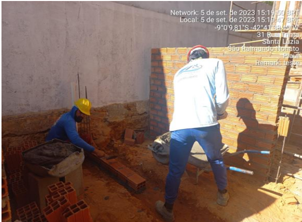
05/09/2023 – Execução de alvenaria de vedação nos banheiros masc e fem dos funcionários do restaurante;
