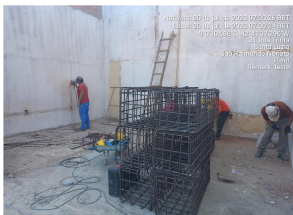
20/07/2023 - Execução de sapatas do restaurante;
