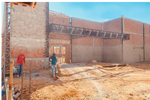
14/09/2023 – Execução de alvenaria do restaurante;
