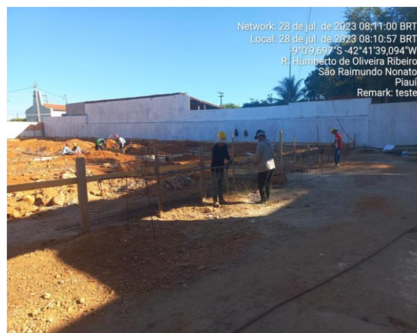
28/07/2023 – Execução de confecção das armaduras longitudinal do Restaurante;
