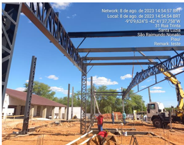
08/08/2023 – Execução de estruturas metálicas do restaurante;
