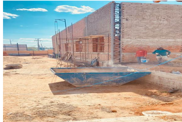
14/09/2023 – Execução de alvenaria do restaurante;
