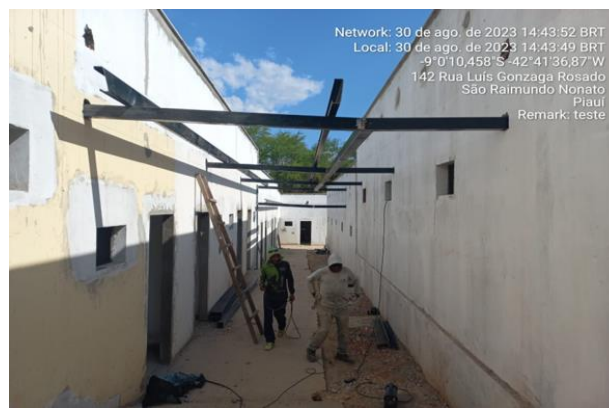
30/08/2023 – execução de estrutura metálica da cobertura do corredor da ala B;
