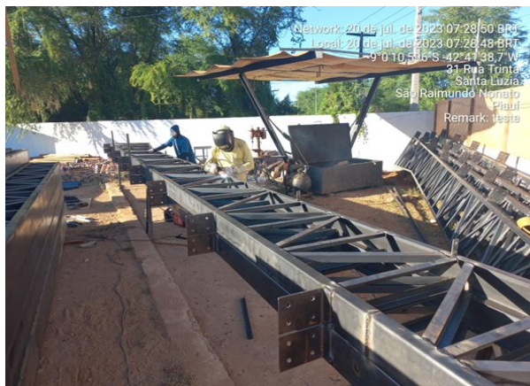
20/07/2023 - Execução de estruturas metálicas do restaurante;
