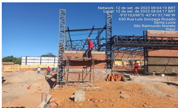
12/09/2023 – Execução de alvenaria de vedação do restaurante;
