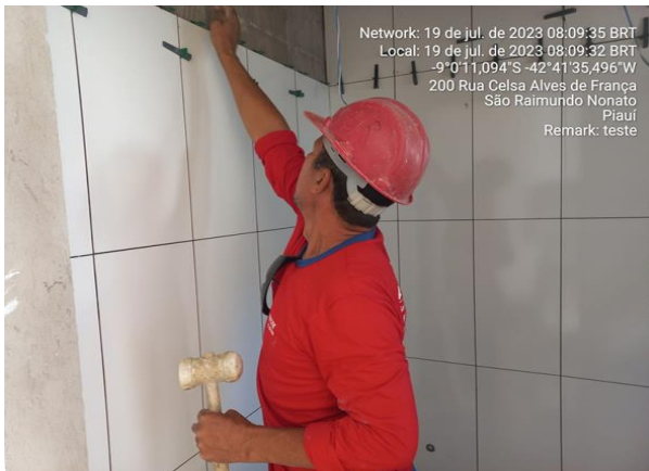
19/07/2023 – Execução do revestimento dos banheiros;
