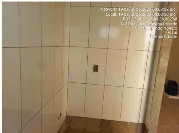
19/07/2023 – Execução do revestimento dos banheiros;
