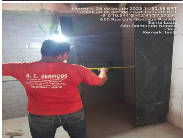
26/09/2023 – Instalação de divisórias de granito dos banheiros da ala D;
