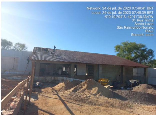
24/07/2023 - Execução de cobertura final do Auditório e Recepção;
