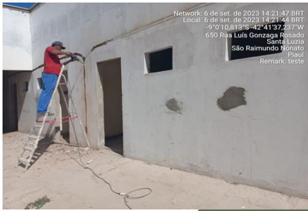
06/09/2023 – abertura de valas para infraestrutura de circuitos elétricos do hall de circulação;
