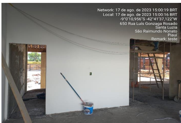
17/08/2023 – Execução de emassamento da superfície das paredes da recepção;
