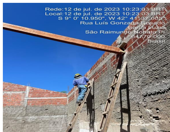
12/07/2023 - Execução de estrutura de madeira no auditório, como ilustrado na foto as vigas de madeiras;
