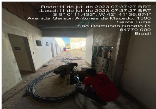
11/07/2023 - Execução processo de instalação dos quadros do corredor A, B e C;
