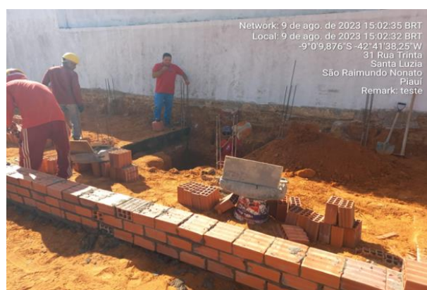
09/08/2023 – Execução de alvenaria de vedação no restaurante;
