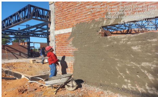
12/09/2023 – Execução de alvenaria de vedação do restaurante;
