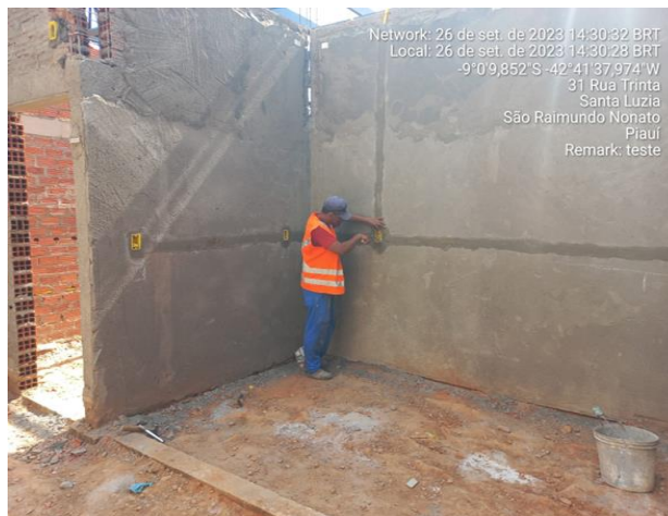
25/09/2023 – Execução de infraestrutura de tubulação das instalações elétricas do restaurante;
