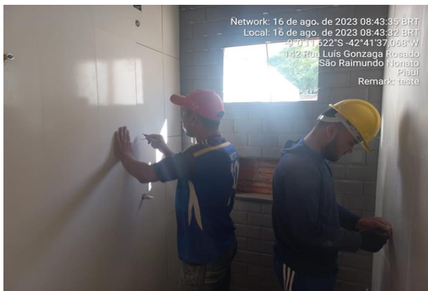
16/08/2023 – Execução de revestimento cerâmico dos banheiros da ala C;
