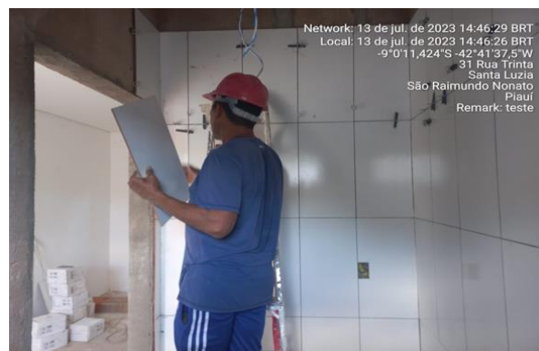
13/07/2023 - Execução de revestimento cerâmico nos banheiros do corredor A;
