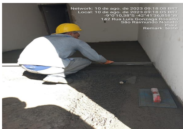
10/08/2023 - Execução de contrapiso dos apartamentos da ala C;
