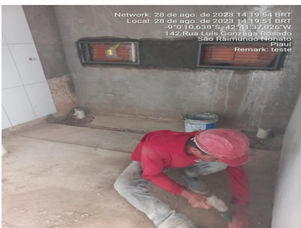
28/08/2023 – Execução de revestimento cerâmico dos quartos da ala D;
