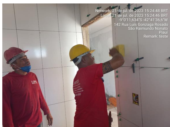
21/07/2023 – Execução de revestimento cerâmico nas paredes dos banheiros;
