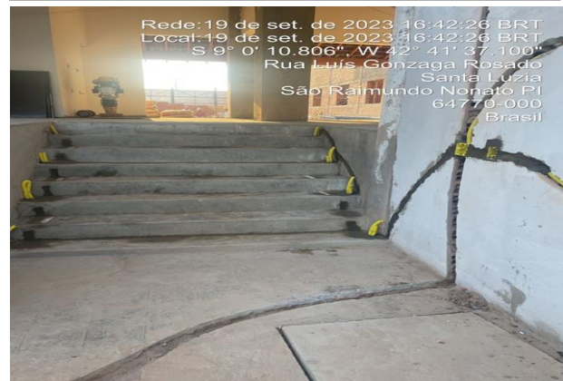
22/09/2023 – Execução de circuito de iluminação;
