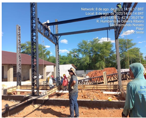
08/08/2023 – Execução de estruturas metálicas do restaurante;
