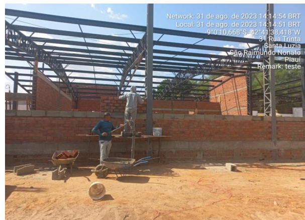
31/08/2023 – Execução de estrutura metálica da cobertura do corredor da ala B;
