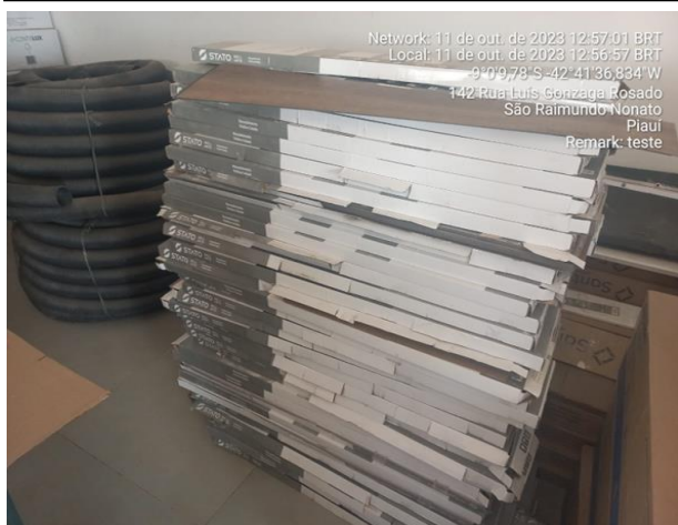
28/09/2023 – Recebimento de materiais tais como: piso de vinílico;
