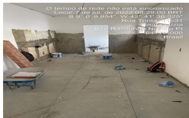
07/07/2023 - execução do piso cerâmico da área de serviços;
