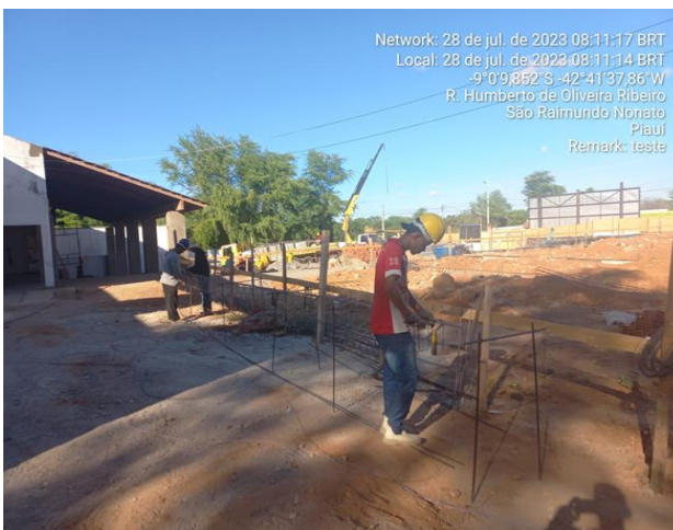
28/07/2023 – Execução de confecção das armaduras longitudinal do Restaurante;
