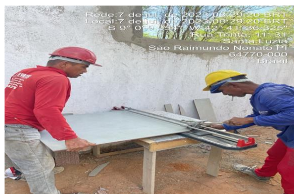
07/07/2023 - execução do piso cerâmico da área de serviços;
