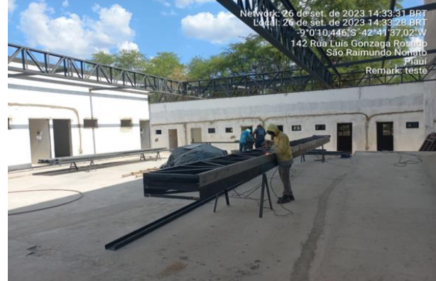
27/09/2023 – Instalação de estrutura metálica para cobertura dos corredores B e C;
