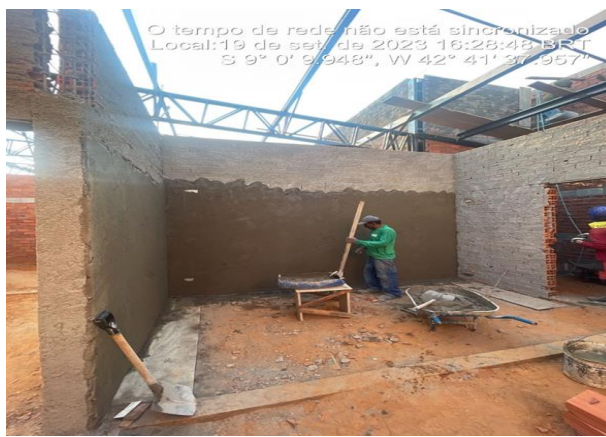
18/09/2023 – Execução de reboco das paredes do restaurante;
