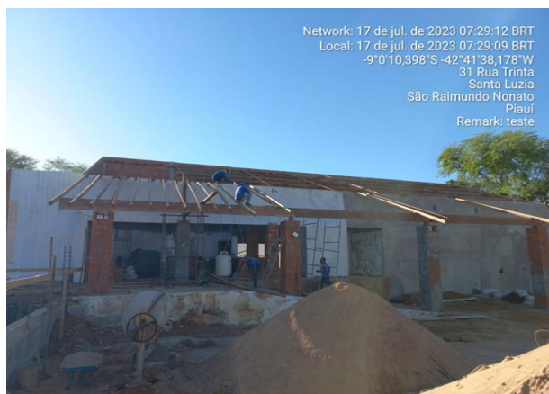
17/07/2023 - Execução de estrutura de madeira da cobertura do auditório e recepção;
