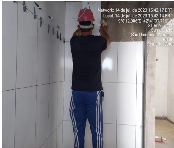
14/07/2023 – Execução de revestimento cerâmico nos banheiros do corredor A;
