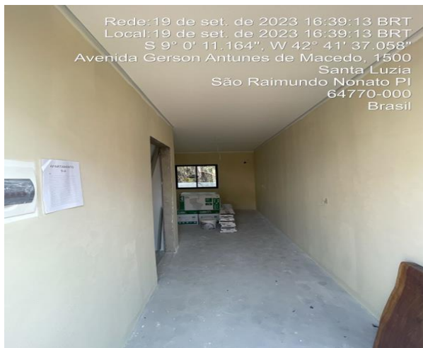
20/09/2023 – Execução de tratamento superficial das paredes internas dos apartamentos da ala A;
