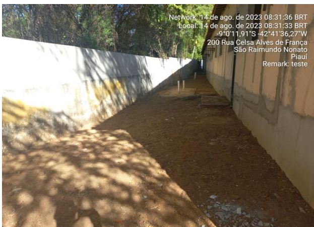
14/08/2023 – Execução de compactação da superfície do solo, corredor A e B;
