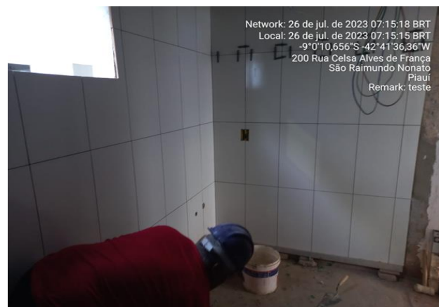
26/07/2023 – Execução de revestimento cerâmico dos banheiros da ALA C;
