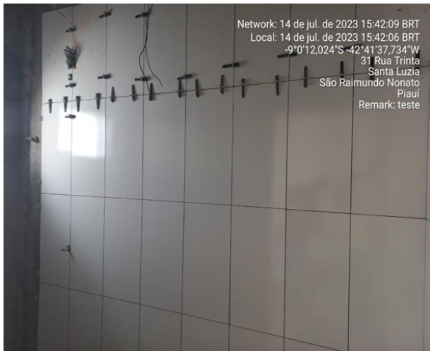
14/07/2023 – Execução de revestimento cerâmico nos banheiros do corredor A;
