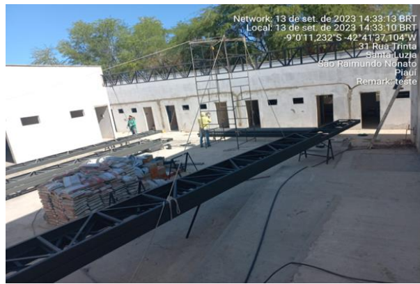
13/09/2023 – Execução de estrutura metálica para cobertura do hall de circulação;
