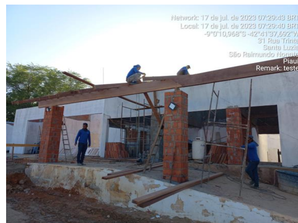
17/07/2023 - Execução de estrutura de madeira da cobertura do auditório e recepção;
