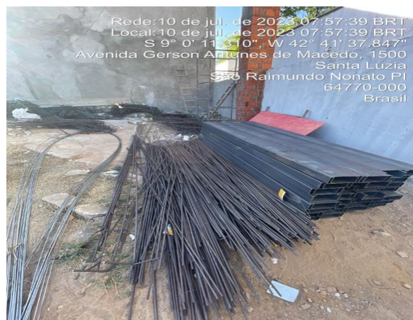
10/07/2023 – Execução de confecção dos pilares do restaurante;
