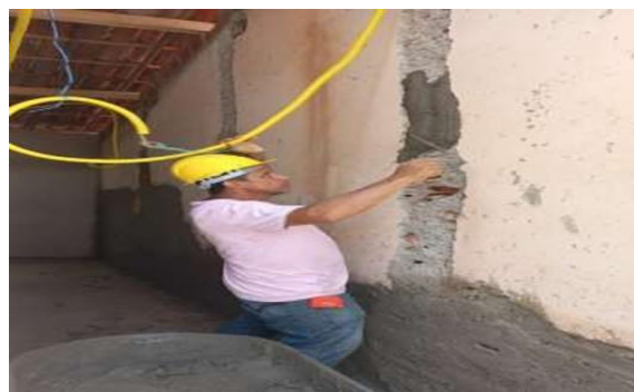
12/04/2023 - Execução de reboco nas aberturas de eletrodutos e Quadro de Distribuição, nos apartamentos do corredor C.
