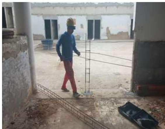
26/04/2023 - Execução de armadura de aço pilares de contenção de empuxo, no auditório;
