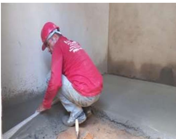
14/04/2023 - Execução de contrapiso na área de serviço;
