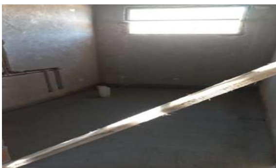
12/04/2023 - Regularização do contrapiso do banheiro corredor C.
