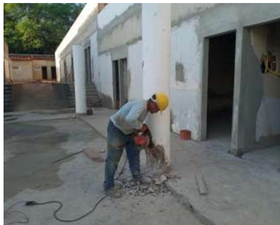
03/04/2023 - Demolição de pilar com circular no Hall de circulação;
