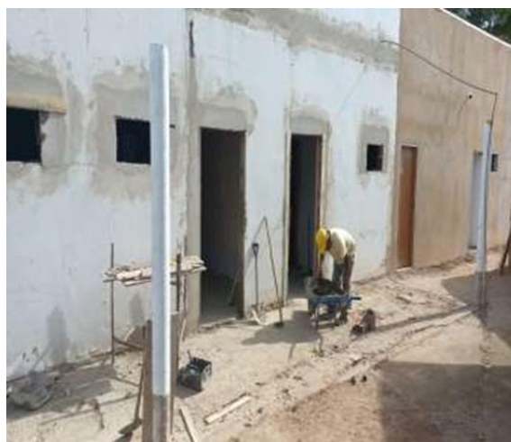
10/04/2023 - execução de reboco para acabamento das esquadrias das portas dos apartamentos do corredor A.
