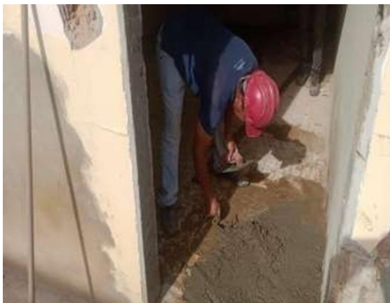
13/04/2023 - Regularização do contrapiso do banheiro do apartamento do corredor;
