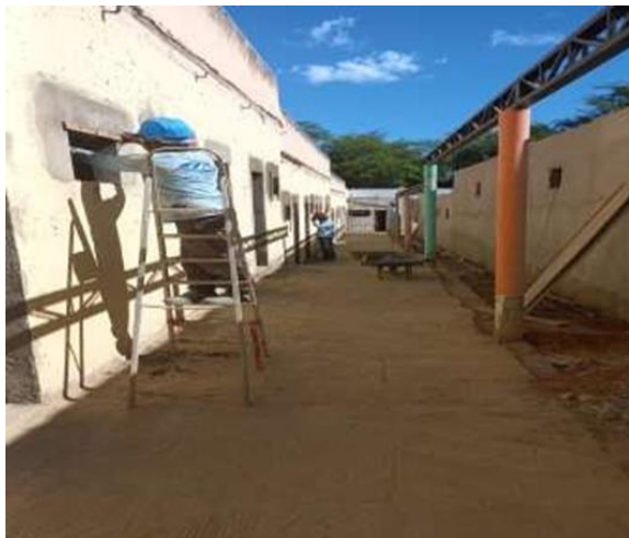
10/04/2023 - Execução de reboco para acabamento das esquadrias dos banheiros do corredor B.
