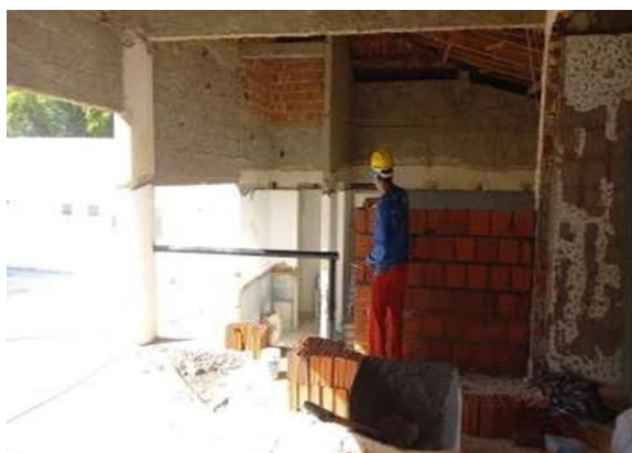
27/04/2023 - Execução de alvenaria de vedação no auditório;
