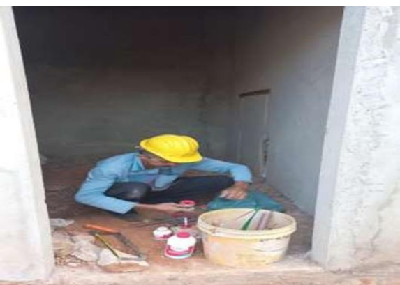
19/04/2023 - Execução de traçado de rede de água fria na área de serviços;
