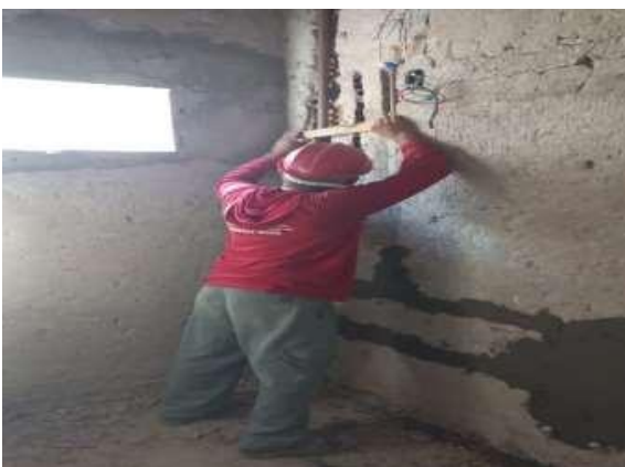
07/04/2023 - Execução de reboco nas tubulações de água fria dos apartamentos do corredor A;
