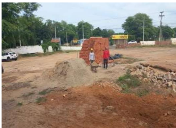
26/04/2023 - Armazenamento de Insumos Areia mista, Bloco cerâmico de 06 furos;
