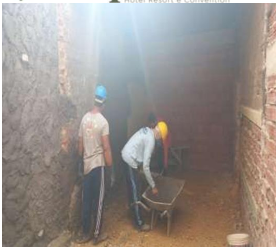
20/04/2023 - Execução de reboco nas futuras instalações da administração;
