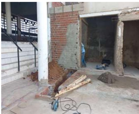
22/04/2023 - Execução de traçado de esgoto apartamentos do corredor D;
