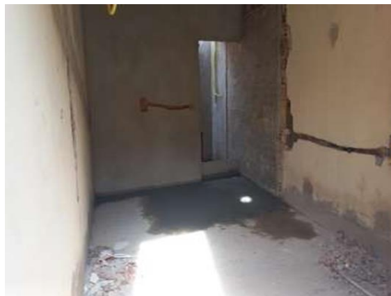
15/04/2023 - Continuidade de Execução de contrapiso e abertura de rasgo na parede na área de serviço;
