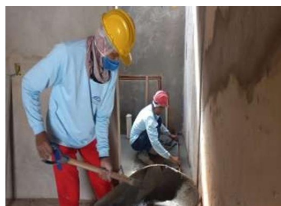
07/04/2023 - Execução de contrapiso dos banheiros dos apartamentos do corredor A;
