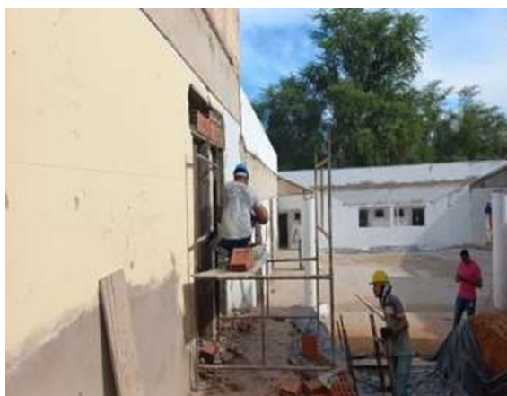
04/04/2023 - Execução de alvenaria de vedação para recebimento de esquadrias dos apartamentos corredor;
