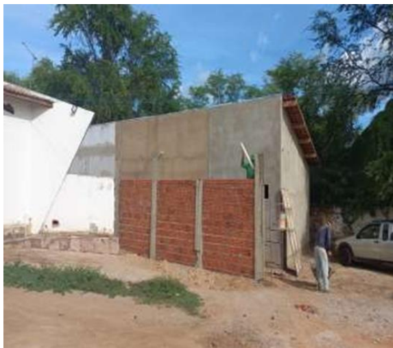
28/04/2023 - Execução de alvenaria de vedação do muro que separa corredor A e auditório;
