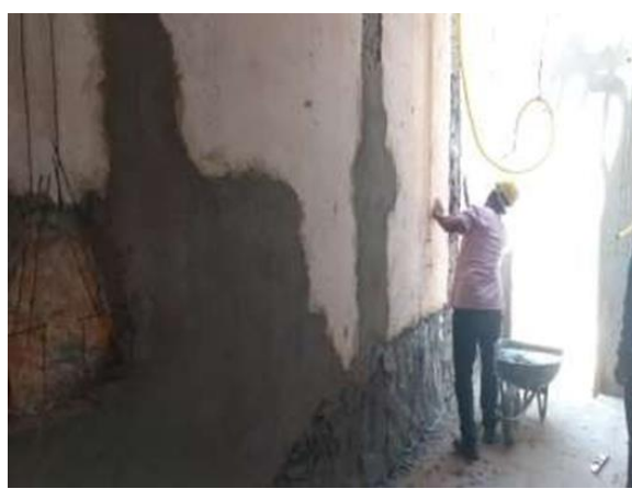
11/04/2023 - Execução de reboco nas aberturas de eletrodutos e Quadro de Distribuição, nos apartamentos do corredor C.
