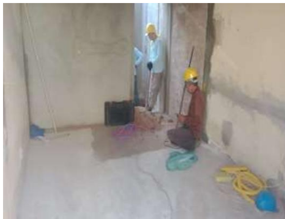
13/04/2023 - Execução de instalações hidrossanitárias do corredor C;
