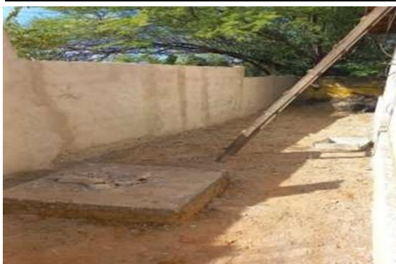
08/04/2023 - Execução de reboco no muro que delimita o perímetro do lote no qual está cravado a edificação do hotel.
