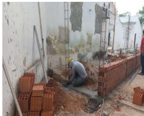
05/04/2023 - Continuidade de contenção de aterro no auditório;
