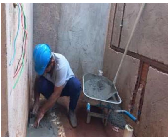
18/04/2023 - Execução de nivelamento de contrapiso no banheiro do apartamento do corredor C;
