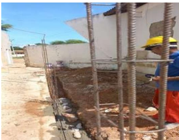
05/04/2023 – Execução de concretagem da fundação;
