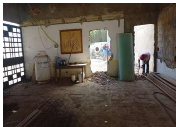
27/04/2023 - Abertura de portas dos banheiros da recepção;
