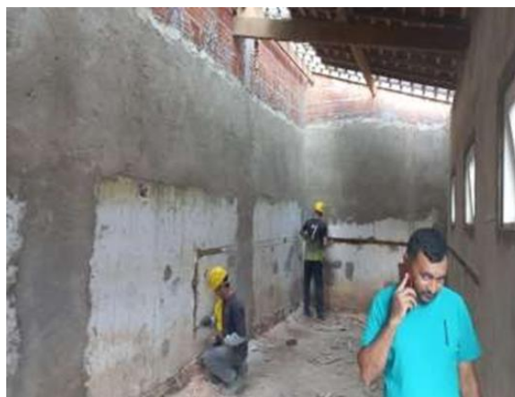
14/04/2023 - Abertura de rasgos na parede para execução de tubulação de água fria, na área de serviços;
