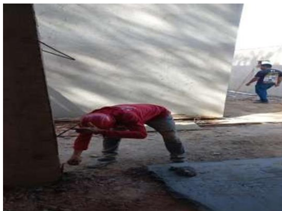
15/04/2023 - Continuidade de Execução de contrapiso na área de serviço;
