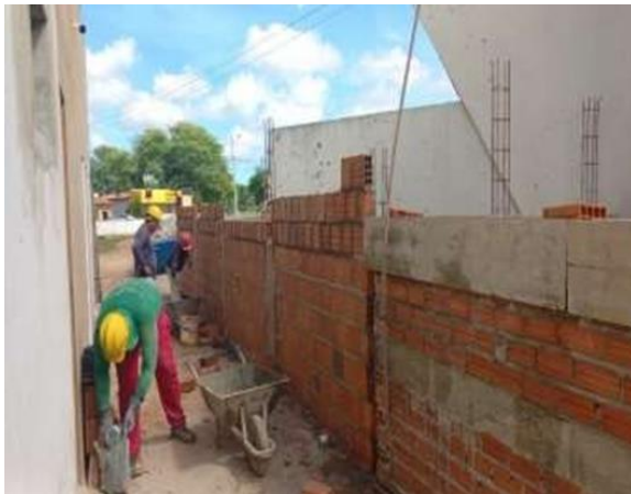
06/04/2023 - Execução de alvenaria de vedação na parede do auditório;
