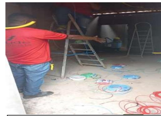
19/04/2023 - Continuidade na execução de instalações elétricas na área de serviços;
