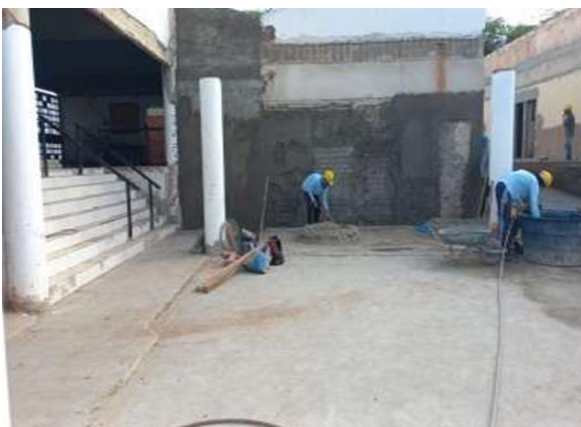
24/04/2023 - Execução de reboco externo da Administração do Hotel;
