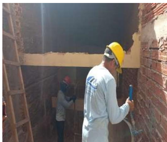
22/04/2023 - Execução de aterro das instalações da administração do hotel;
