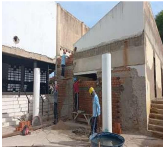
20/04/2023 - Execução de alvenaria de vedação da futura administração do hotel;
