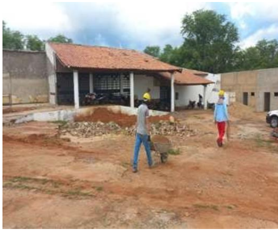
25/04/2023 - Execução de aterro na rampa de acessibilidade;
