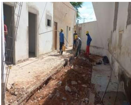
06/04/2023 - Continuidade de estrutura de contenção do auditório;
