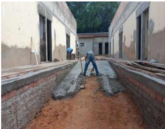
03/04/2023 - Concretagem do piso da rampa de acessibilidade;
