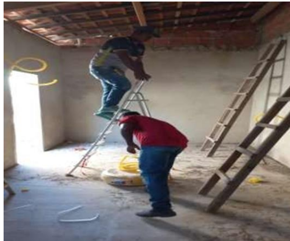
17/04/2023 - Execução de instalações elétricas na área de serviço;
