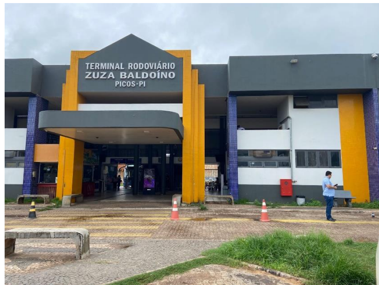
Figura 9 – Entrada do terminal sem rampa de acessibilidade
