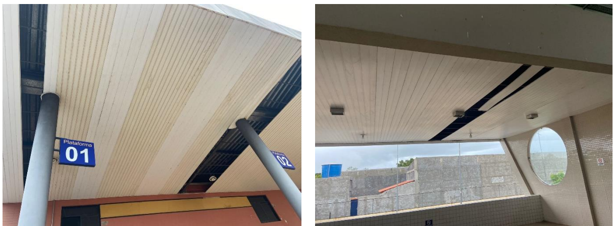
Figura 3 – Teto com infiltrações e avarias
