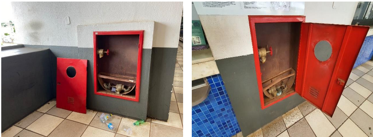
Figura 7 – Falta da instalação do projeto de gás GLP
