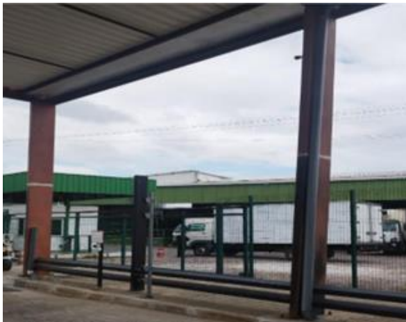
Figura 1 – Tubulação pluvial – Portaria 01
