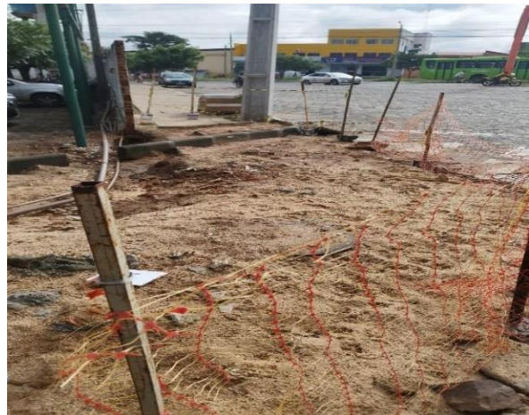
Figura 2 –Demolição da Portaria 01
