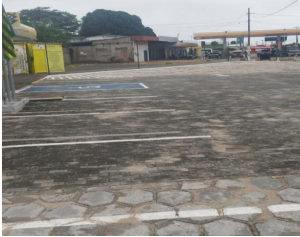
Figura 5 – Silanização Estacionamento BB
