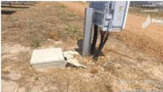
Figura 20 – Erosão na base do inversor.
