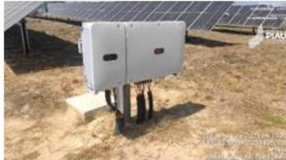
Figura 19 – Inversor com erosão na base.
