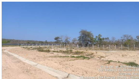
Figura 16 – Sistema de drenagem.
