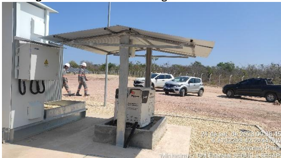
Figura 11 – Cobertura do gerador instalada.
