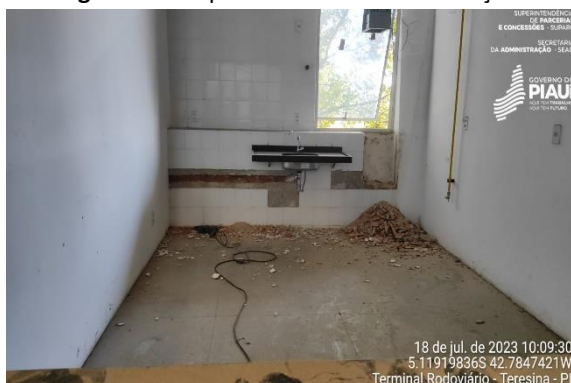
Figura 92 - Reparo e retirada de infiltração
