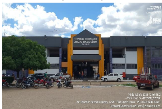
Figura 41 - Entrada principal e estacionamento (vista frontal)
