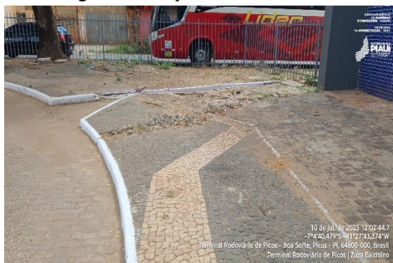
Figura 79 - Calçamento com avarias
