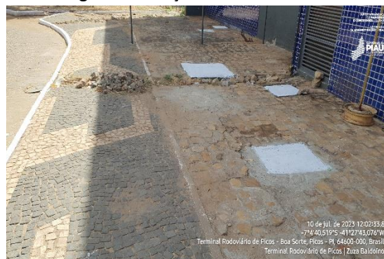
Figura 80 - Calçamento com avarias
