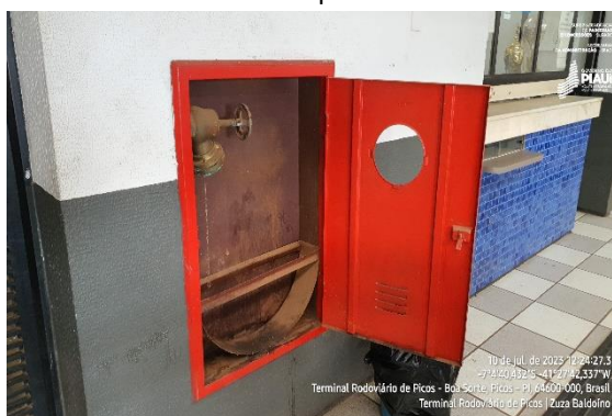
Figura 64 - Sistema de Combate a Incêndio inadequado
