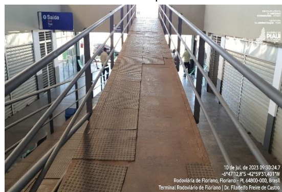
Figura 26 - Rampa de acessibilidade sem o tapete antiderrapante
