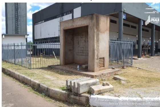
Figura 73 - Local destinal à Central de Gás (vista lateral)
