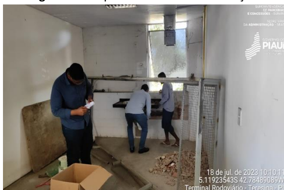
Figura 91 - Reparo e retirada de infiltração
