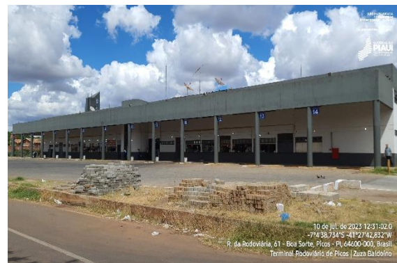
Figura 70 - Pátio de manobras com avarias
